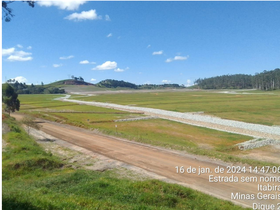
Foto 4. Recomposição da vegetação finalizada em outubro de 2023 – Dique 2. Fonte: Vale, 2024. Nota-se o sucesso da metodologia de plantio empregada e que não há solo exposto no local.
