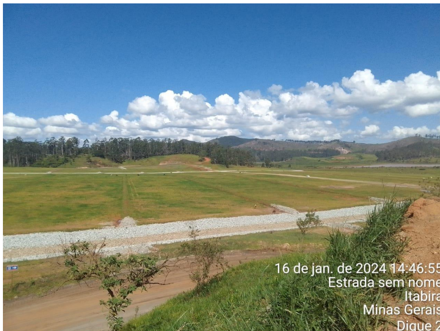
Foto 5: Recomposição da vegetação finalizada em outubro de 2023 – Dique 2. Fonte: Vale, 2024. Nota-se o sucesso da metodologia de plantio empregada e que não há solo exposto no local.
