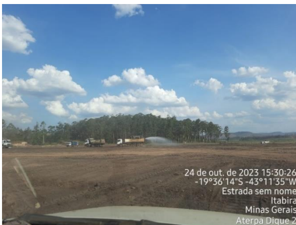
Foto 8 e Foto 9: Umectação na área do Dique 02 por meio de caminhão pipa. Fonte: Vale, 2024.
