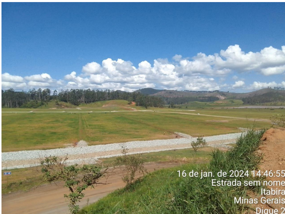
Foto 13: Recomposição da vegetação finalizada em outubro de 2023 – Dique 2. Fonte: Vale, 2024. Nota-se o sucesso da metodologia de plantio empregada e que não há solo exposto no local.
