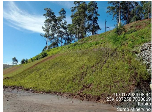
Foto 6 e Foto 7. Desenvolvimento da Aplicação de hidrossemeadura com biomanta em taludes como medida de contenção de processos erosivos – Sump Dique Minervino. (VALE, 2023).
