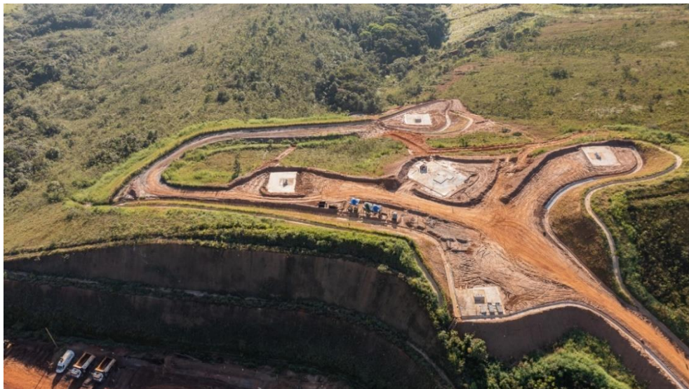
Foto 20: Obras de implantação das fundações do Lift Line fase 2 – Torre T3 – Ombreira Direita (abril/24).
