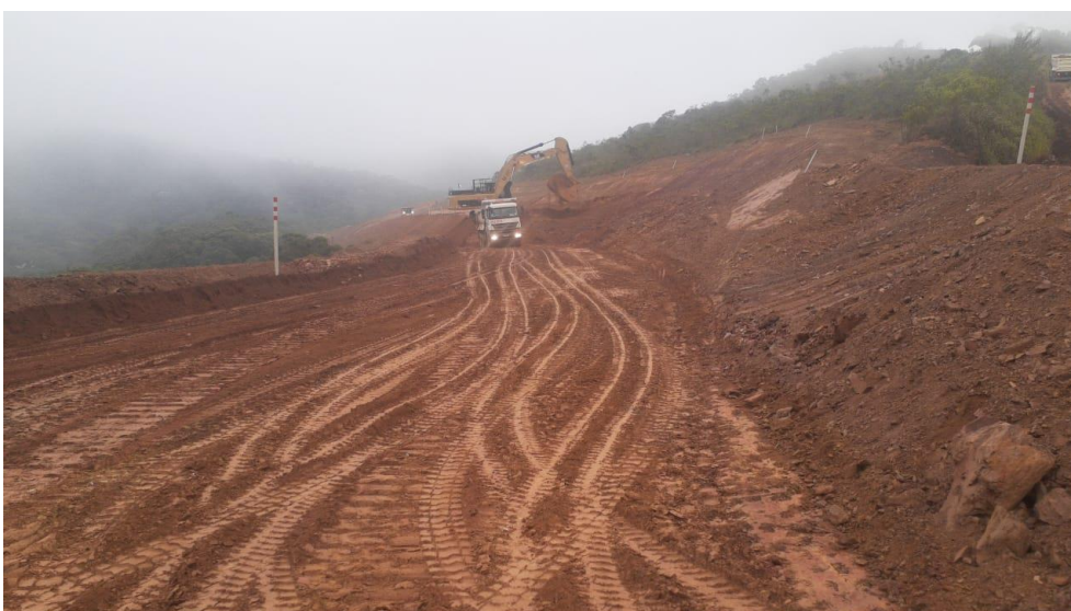
Foto 5: Obras de implantação do acesso construtivo na ombreira esquerda de Forquilha III (abril/24)
