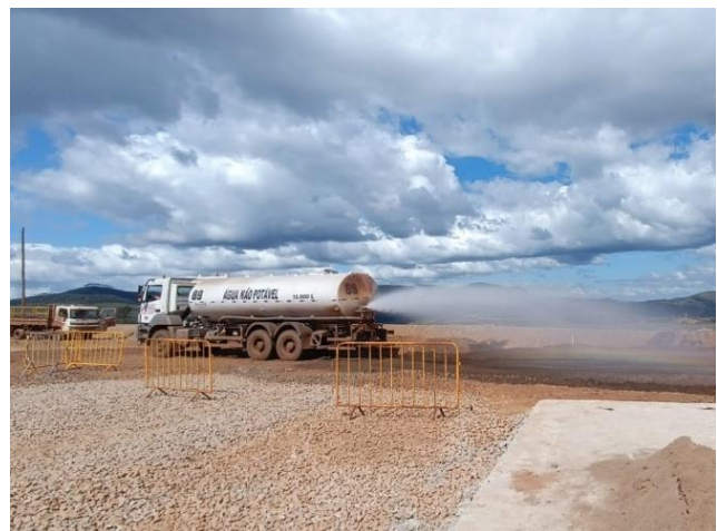
Foto 42: Aspersão de acessos no entorno do canteiro Barbosa Mello que atende as obras preparatórias de Forquilha III. Fonte: Vale, abril de 2024.
