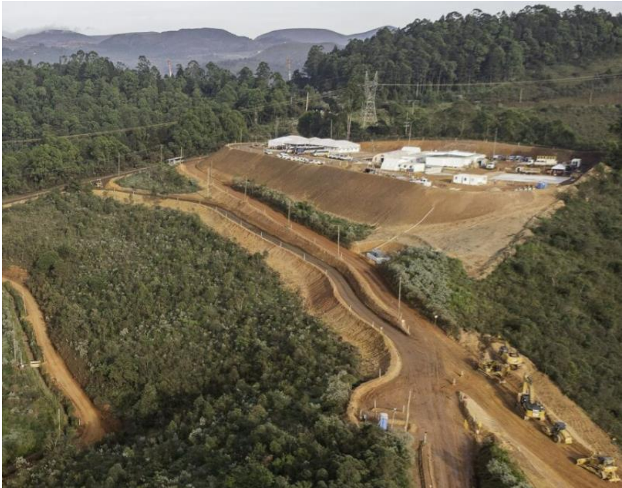
Foto 12: Canteiro de obras Forquilha III (abril/24).
