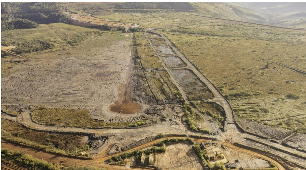
Foto 23: Visão geral do reservatório de Forquilha III e Sump 1 (abril/24)
