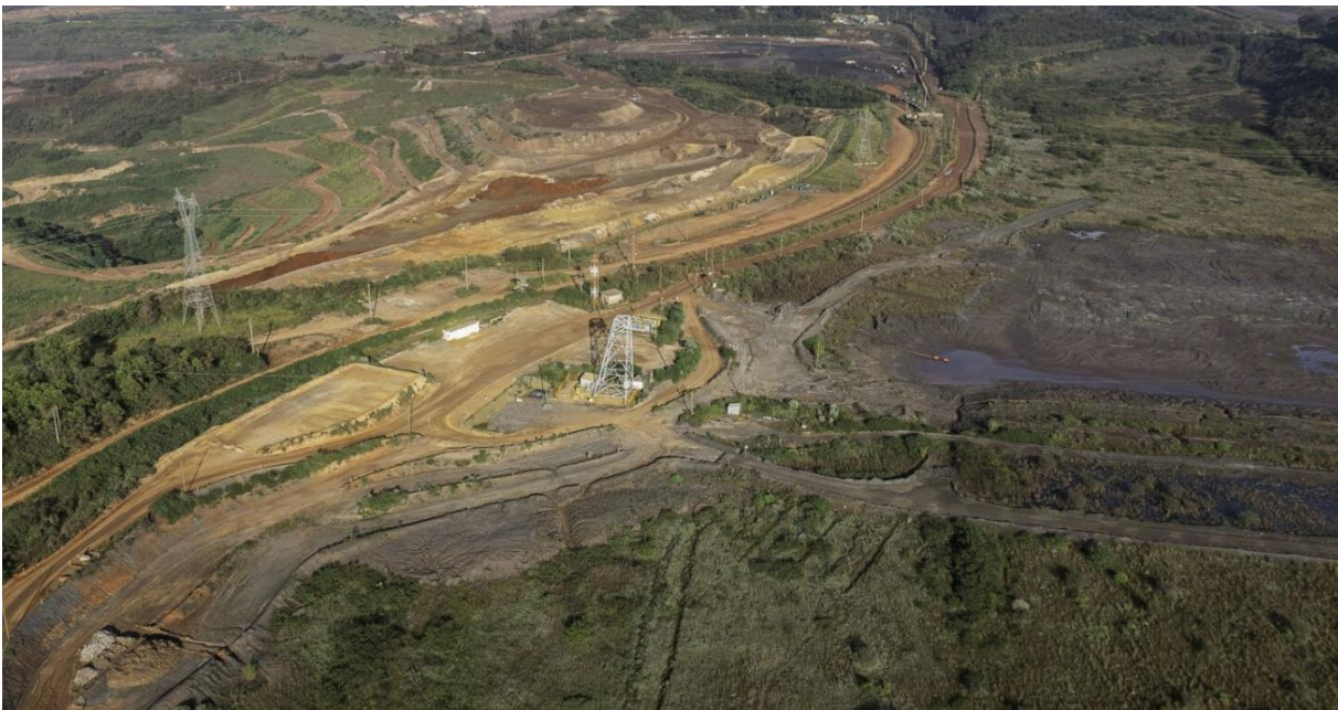
Foto 11: Sistema de bombeamento implantado no Sump 1 de Forquilha III e região do antigo canteiro de obras na margem direita (abril/24).
