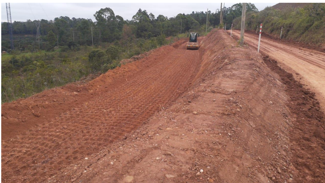
Foto 18: Obras de implantação do acesso construtivo na ombreira esquerda de Forquilha III (abril/24)
