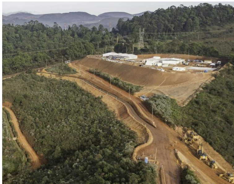
Foto 26: Canteiro de obras Forquilha III (abril/24).
