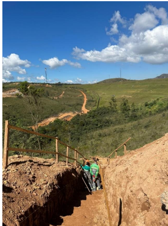
Foto 40: Controle de erosão na ombreira esquerda de Forquilha III. Vale, 2024.
