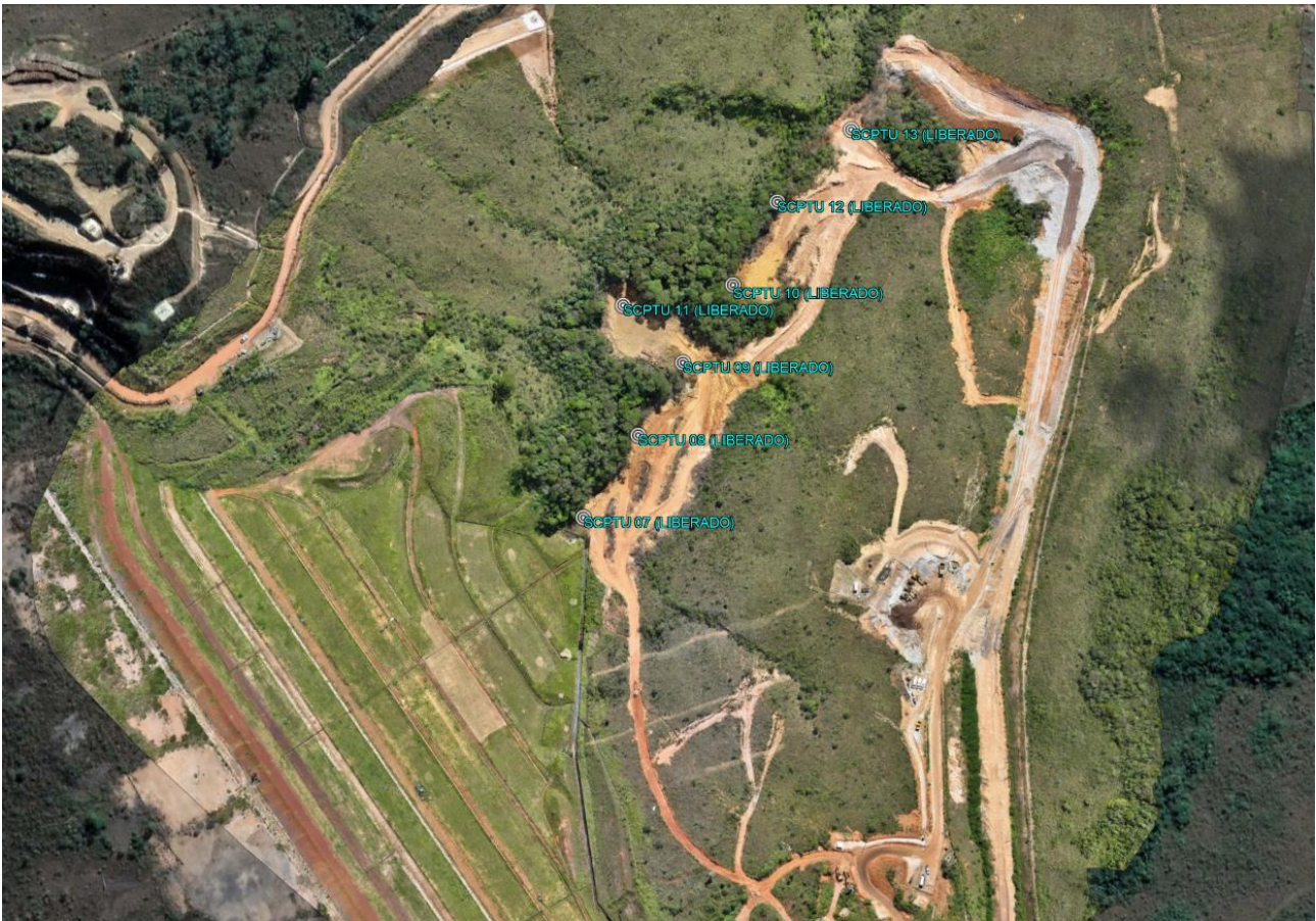
Figura 20: Acessos a jusante para sondagens na fundação. Projeto INTT (abril, 2024)
