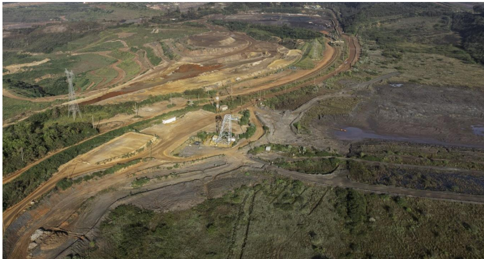
Foto 25: Sistema de bombeamento implantado no Sump 1 de Forquilha III e região do antigo canteiro de obras na margem direita (abril/24).
