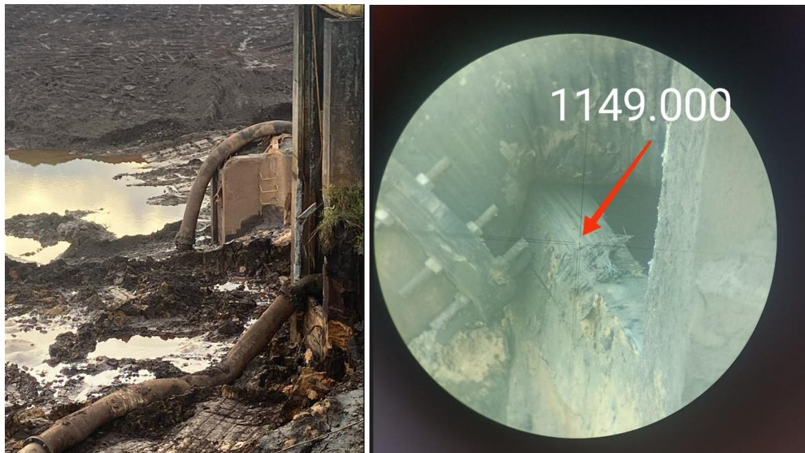
Figura 10: Desobstrução dos stop-logs até a cota 1.149,00m – Torre T4 – Extravasor Forquilha III (março/24)
