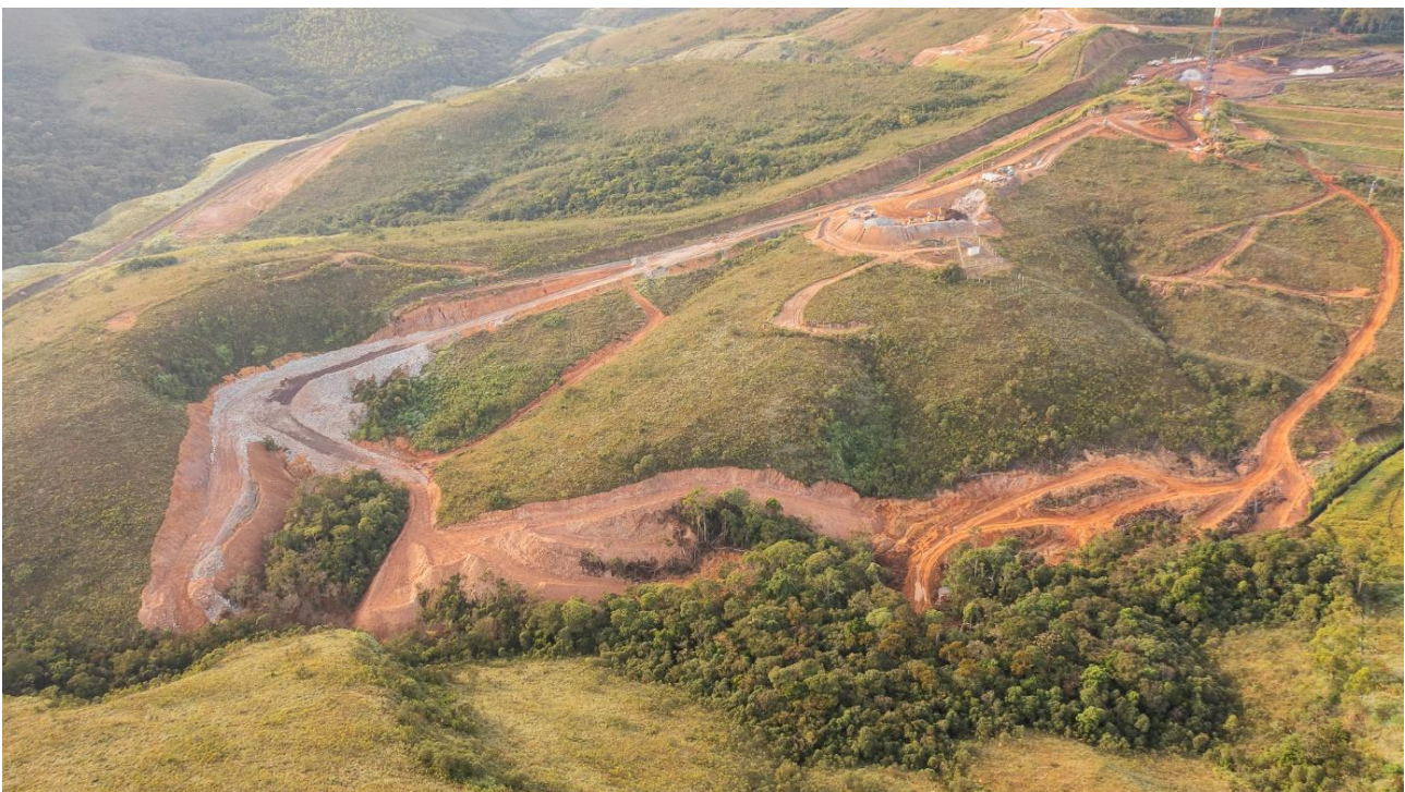
Foto 16: Acessos a jusante para sondagens na fundação. Projeto INTT (abril, 2024)
