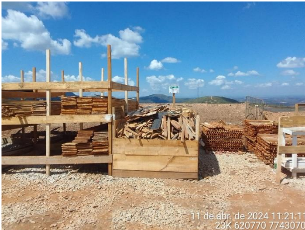
Foto 50: Baía com resíduos de madeira (Antes) - (Fonte: Vale, abril de 2024).
