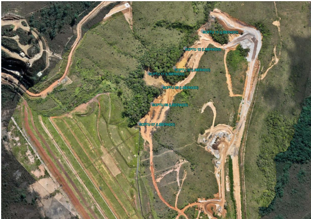
Figura 3: Acessos à jusante para sondagens na fundação. Projeto INTT (abril, 2024).
