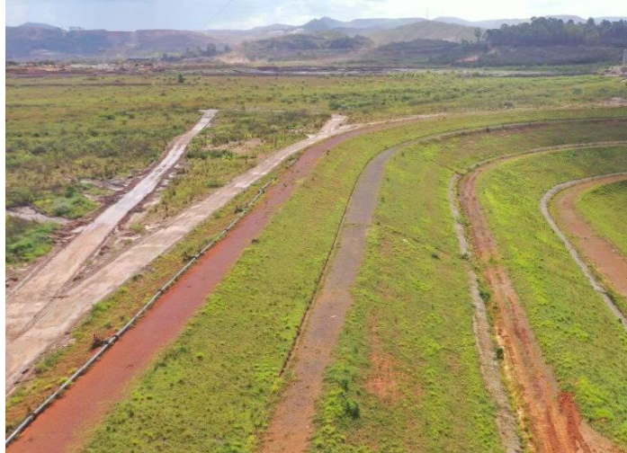
Foto 15: Tubulação existente na crista de Forquilha III.
