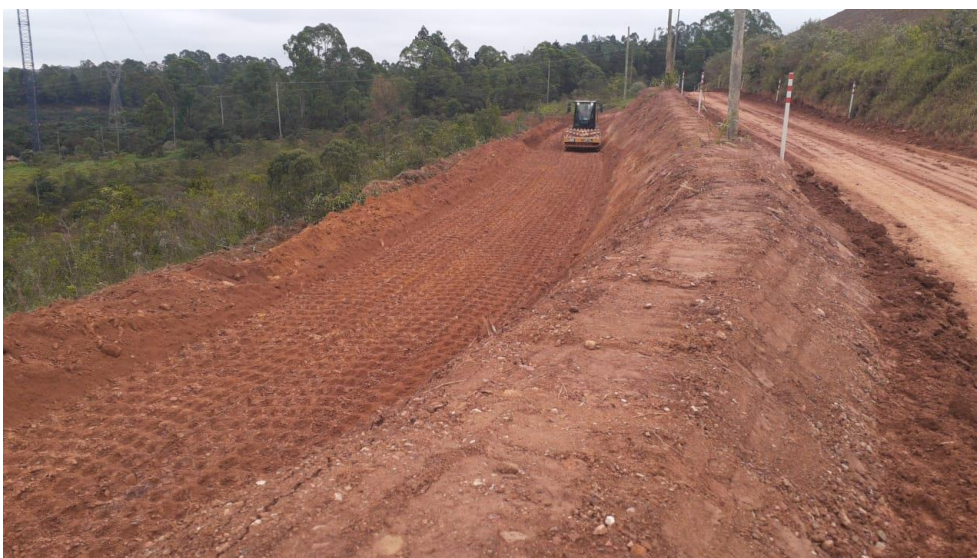
Foto 4: Obras de implantação do acesso construtivo na ombreira esquerda de Forquilha III (abril/24)
