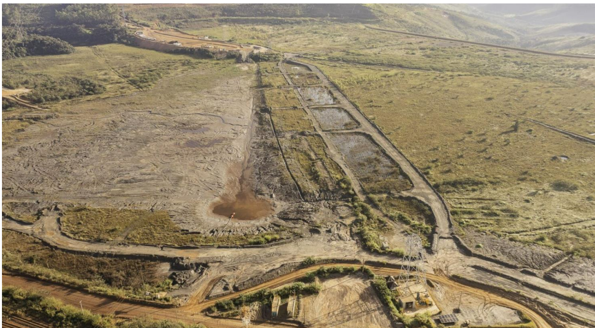
Foto 9: Visão geral do reservatório de Forquilha III e Sump 1 (abril/24)
