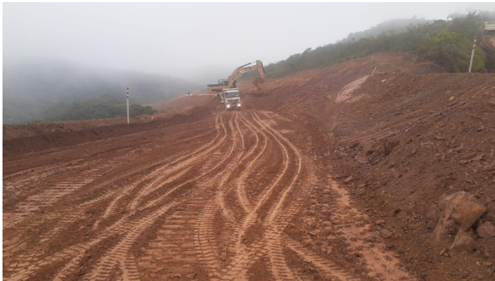
Foto 19: Obras de implantação do acesso construtivo na ombreira esquerda de Forquilha III (abril/24)
