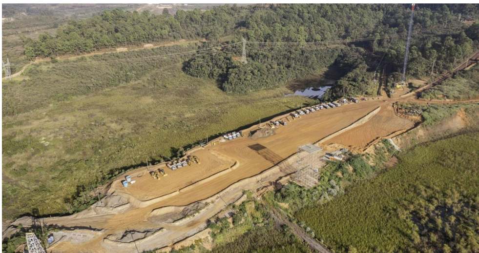
Foto 24: Visão geral Sump 2 e preparação do pátio de transbordo na margem esquerda (abril/24)
