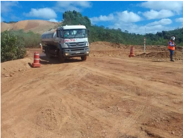
Foto 41: Aspersão de acessos no canteiro da Barbosa Mello que atende as obras preparatórias de Forquilha III. Fonte: Vale, abril de 2024.
