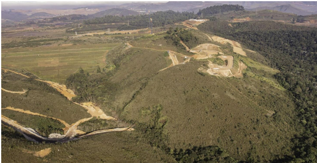
Foto 17: Visão geral – obras dos acessos construtivos a jusante. Projeto INTT (abril, 2024)
