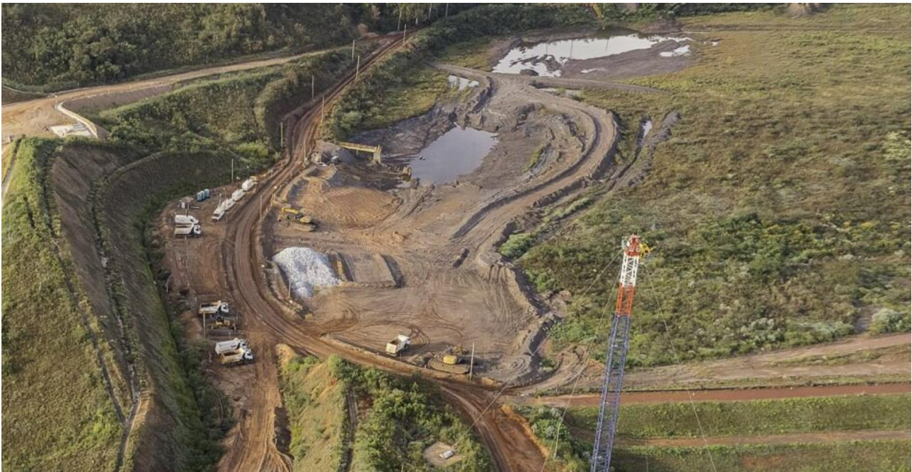
Foto 13: Area de transbordo ou Depósito temporário de Forquilha III – Margem direita.
