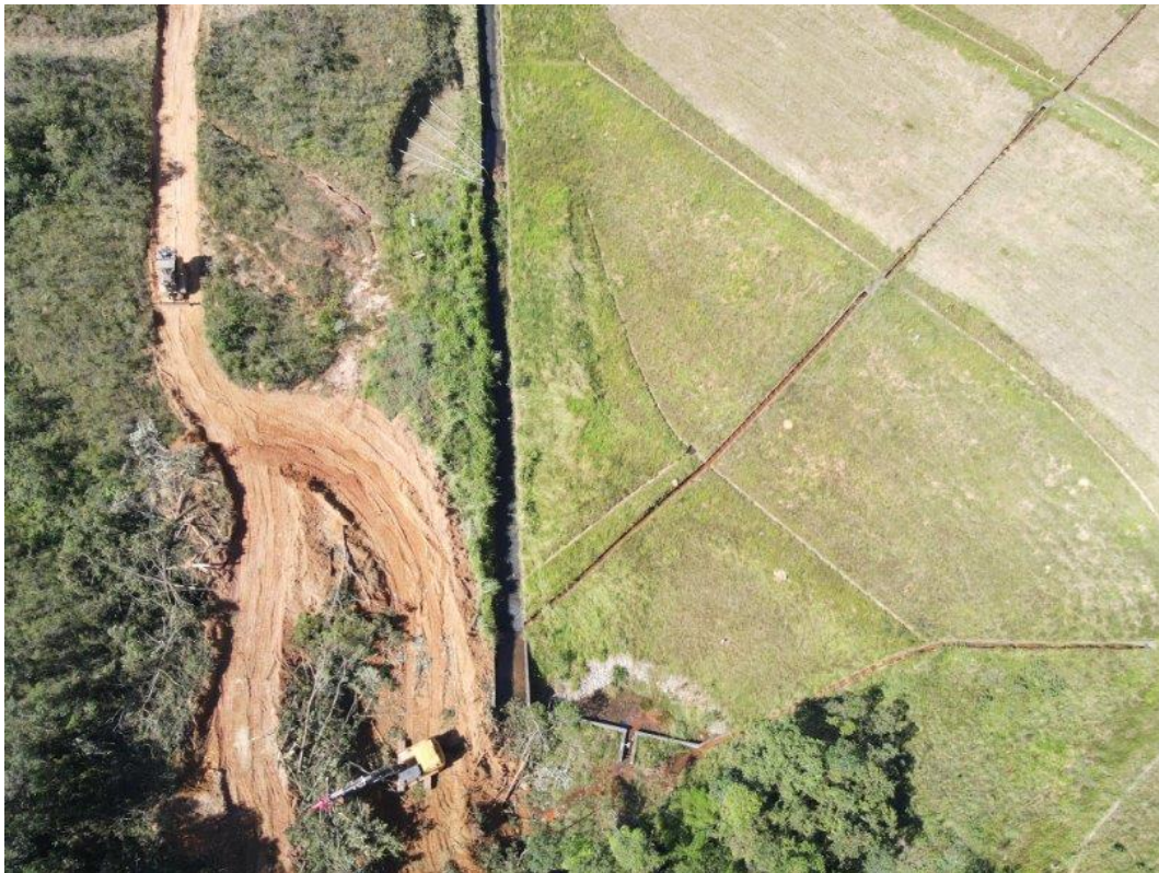
Foto 31: Execução das atividades de supressão de vegetação área da jusante de Forquilha III (fonte: Vale, 2024).
