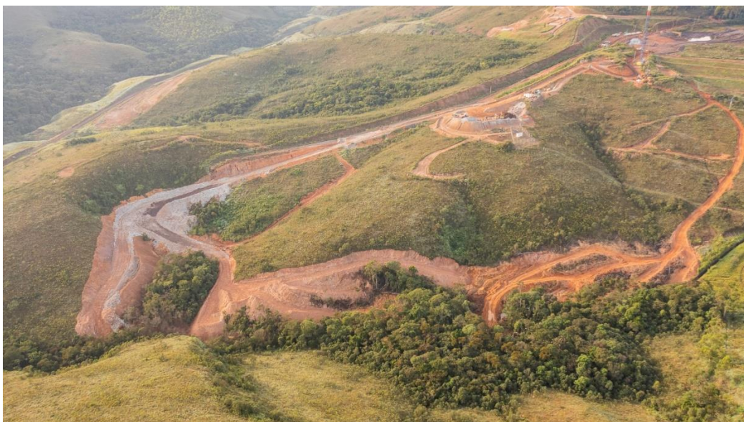
Foto 1: Acessos a jusante para sondagens na fundação. Projeto INTT (abril, 2024).
