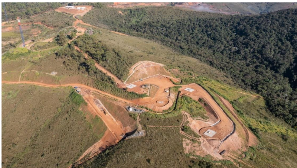
Foto 21: Obras de implantação das fundações do Lift Line fase 2 – Torre T4 – Ombreira Esquerda (abril/24).
