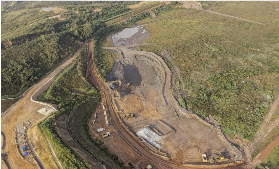
Foto 22: Escavações do canal de rebaixamento do extravasor de Forquilha III e Bombeamentos Sump 3 (abril/24)
