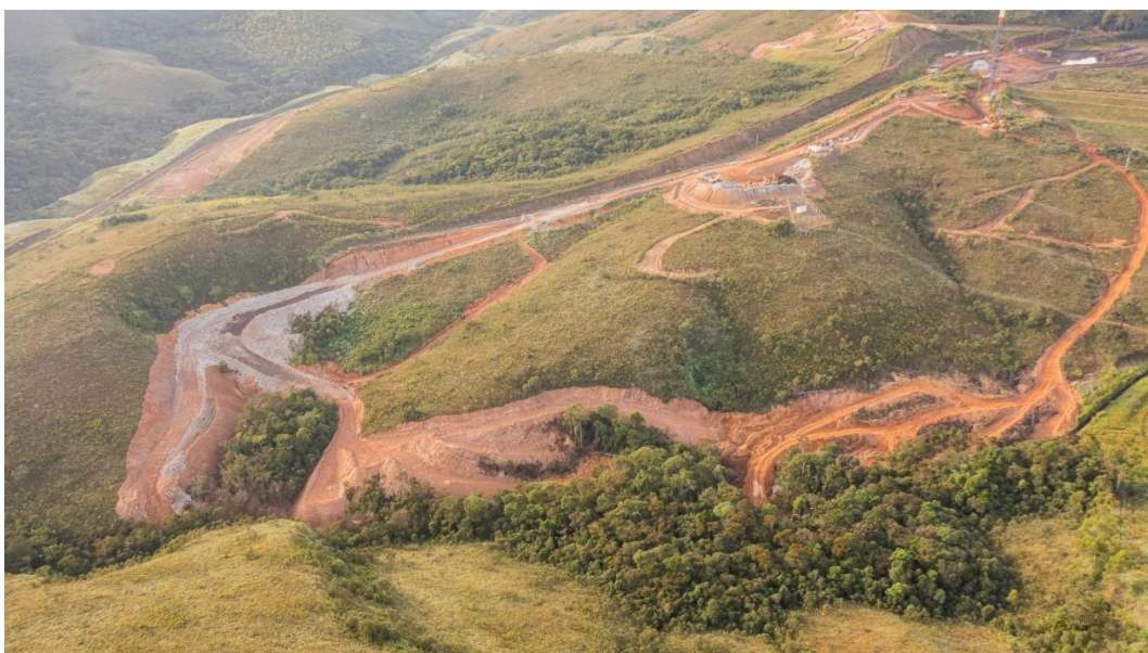
Foto 2: Acessos a jusante para sondagens na fundação. Projeto INTT (abril, 2024).
