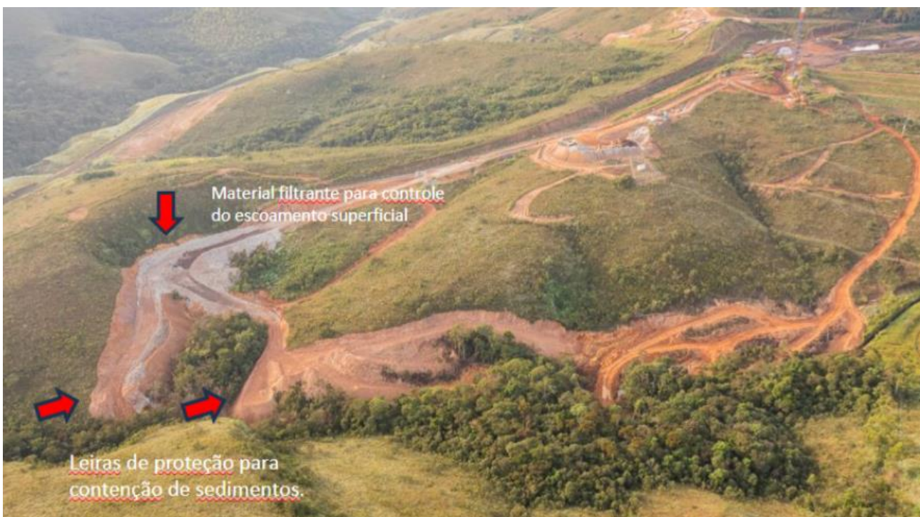
Figura 42: Ações de controle de processos erosivos na ZAS de Forquilha III. Fonte: Vale, 2024.
