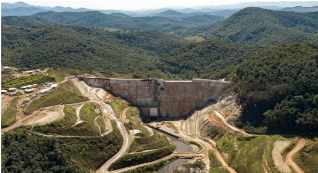
Foto 72: Estrutura de Contenção a Jusante Fábrica. Fonte: Vale, 2022.
