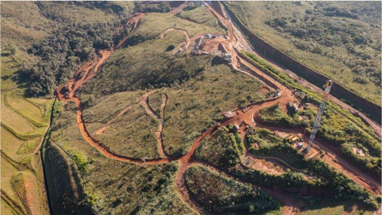
Foto 33: Área após realização da supressão de vegetação (fonte: Vale, 2024).
