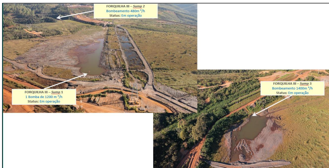
Figura 13: Sistema de bombeamento atual de Forquilha III (abril/24).
