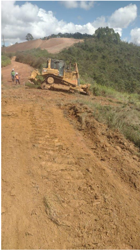
Foto 36 e Foto 37: Execução da remoção de topsoil pela Construtora Barbosa Mello (fonte: Vale, 2024).
