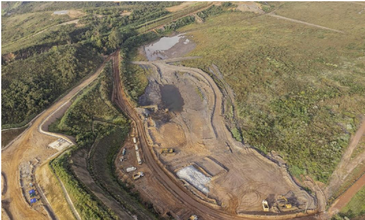
Foto 8: Escavações do canal de rebaixamento do extravasor de Forquilha III e Bombeamentos Sump 3 (abril/24)
