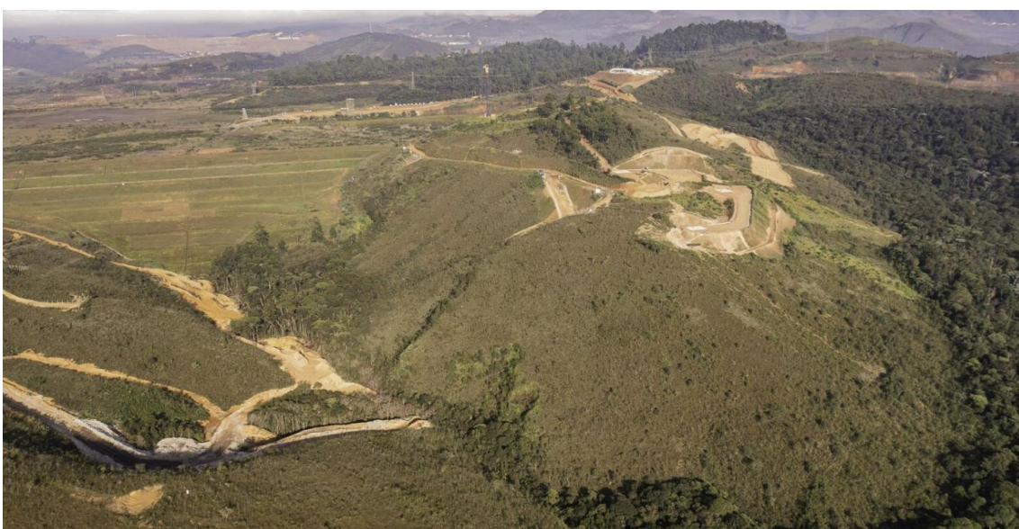
Foto 3: Visão geral – obras dos acessos construtivos a jusante. Projeto INTT (abril, 2024)
