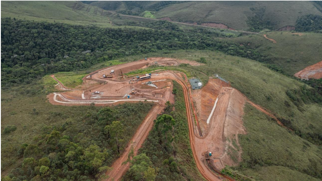
Foto 5: Obras de implantação das fundações do Lift Line fase 2 (imagem Dezembro/23).
