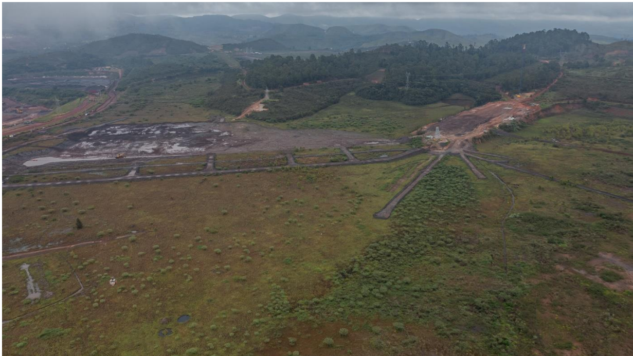
Foto 3: Sump, canal e escavações-teste concluídos (imagem Dezembro/23).
