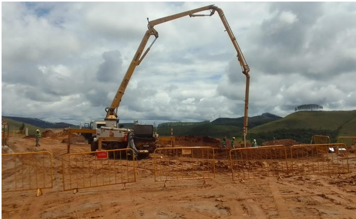
Foto 23: Obras civis do Lift Line fase 2 - Forquilha III (janeiro/24).
