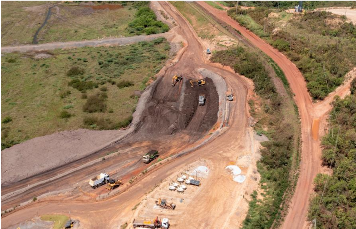
Foto 8: Área de transbordo ou Depósito temporário de Forquilha III – Margem direita.
