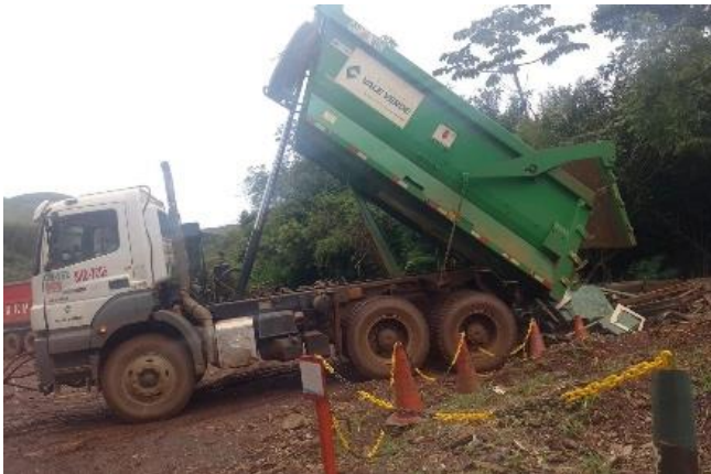
Foto 42: Recolhimento e envio de madeira para o CMD (Fonte: Vale, 2024).
