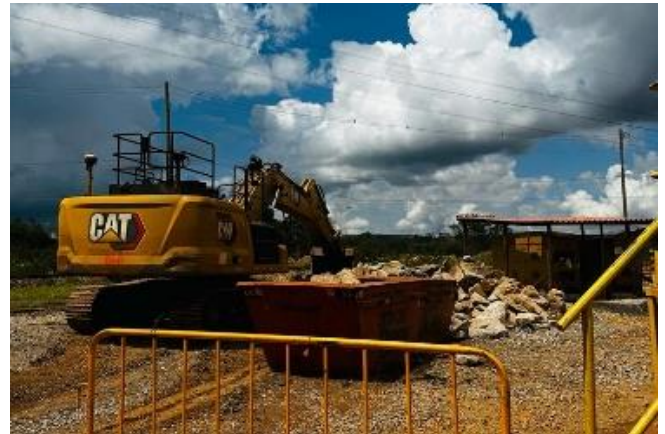
Foto 43: Destinação de concreto com malha de ferro (entulho de construção civil). Fonte: Vale, 2024.
