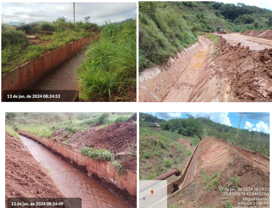
Foto 27, Foto 28, Foto 29 e Foto 30: Manutenções de rotina nos canais de cintura de Forquilha III.
