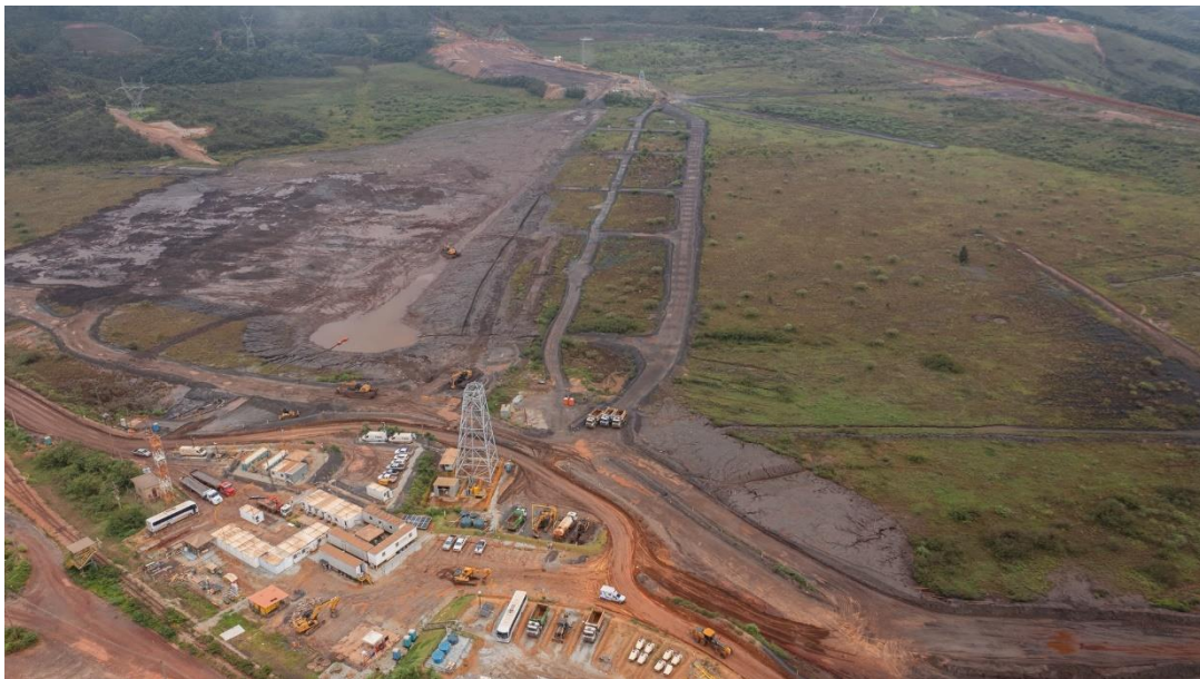
Foto 2: Sump, canal e escavações-teste concluídos (imagem Dezembro/23)
