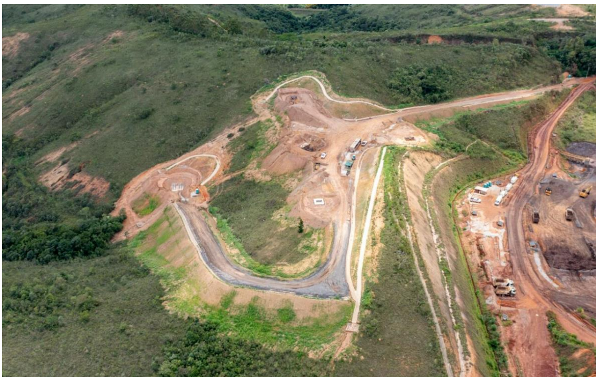
Foto 21: Obras civis do Lift Line fase 2 - Forquilha III (janeiro/24).
