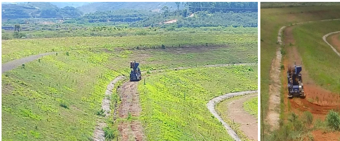
Foto 11: Execução de sondagens/instrumentação maciço de Forquilha III (dez e jan/23).
