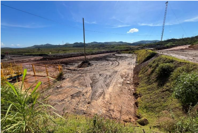
Foto 46: Vista do canteiro desativado. (Fonte: Vale, 2024).
