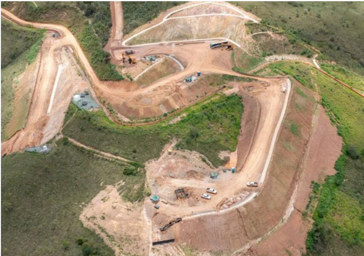
Foto 22: Obras civis do Lift Line fase 2 - Forquilha III (janeiro/24).
