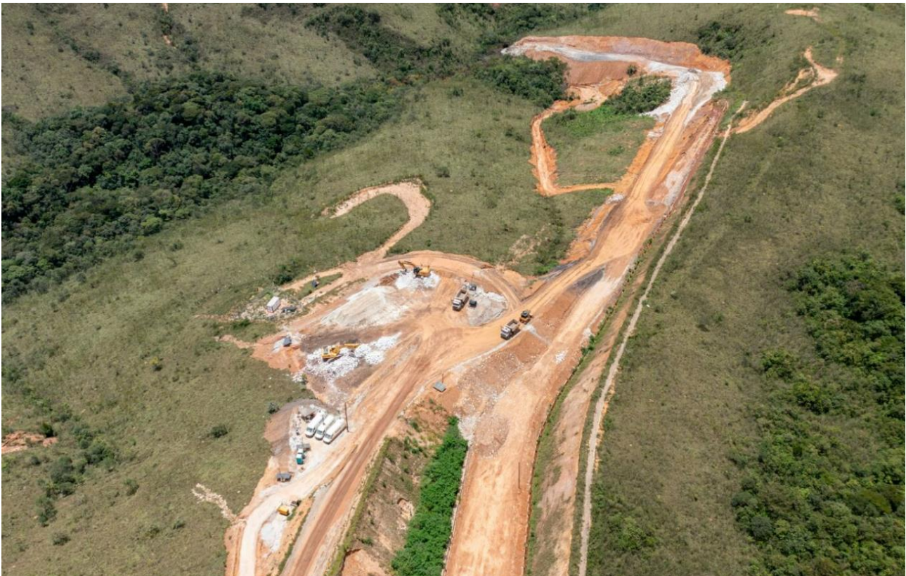
Foto 20: Construção de acesso para investigações à jusante - Forquilha III (janeiro/24).
