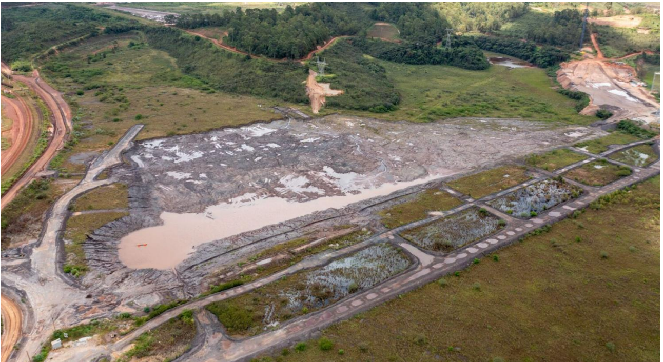
Foto 14: Teste de escavação e canal do PPC concluídos - Forquilha III (janeiro/24).
