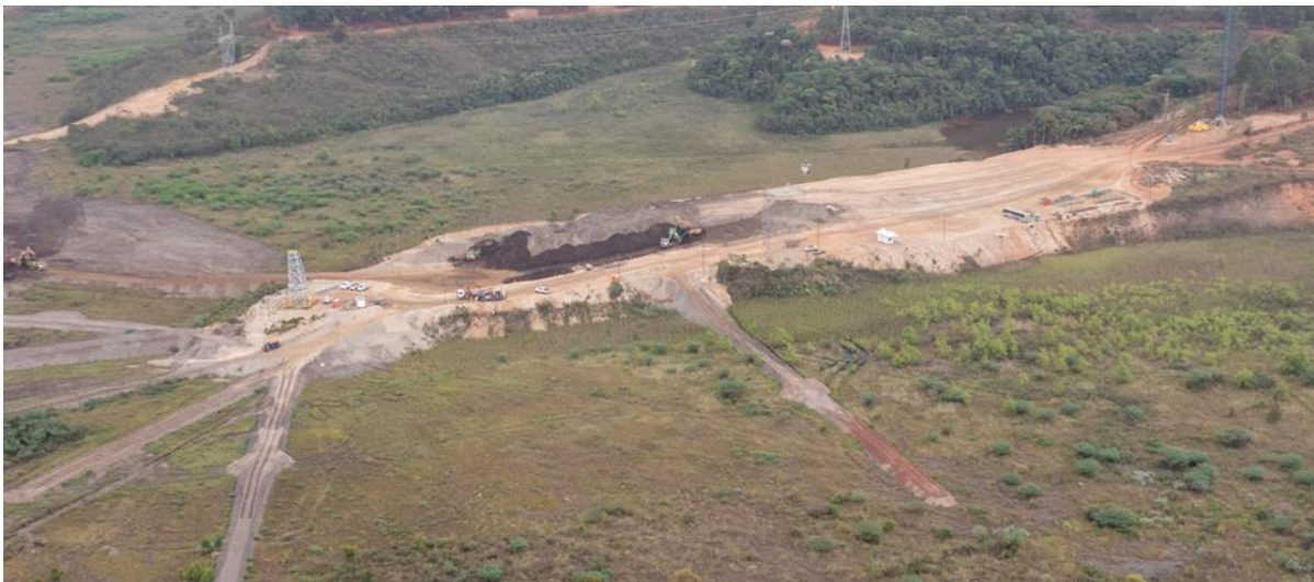
Foto 9: Área de transbordo ou Depósito temporário de Forquilha III – Margem esquerda.
