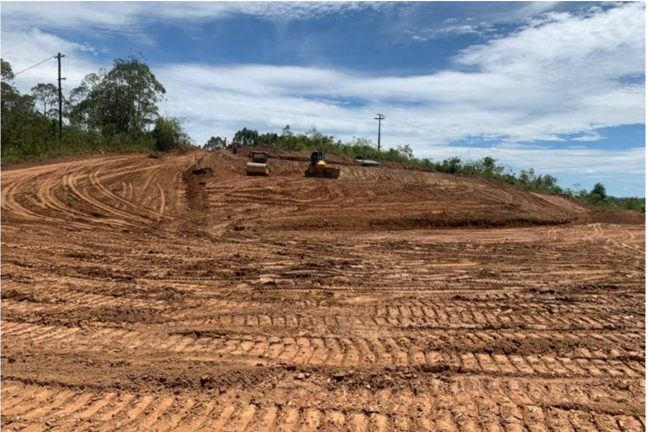
Foto 24: Terraplenagem do canteiro de obras do novo contrato Barbosa Melo (janeiro/24).
