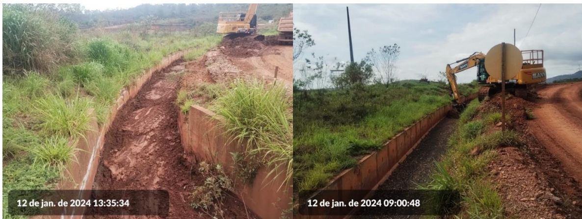
Foto 25 e Foto 26: Manutenções de rotina nos canais de cintura de Forquilha III.
