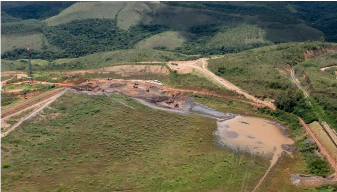
Foto 18: Escavação de canal para rebaixamento do emboque do extravasor - Forquilha III (janeiro/24).
