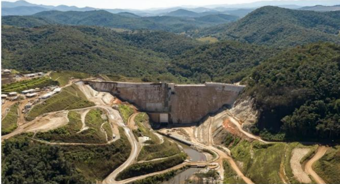
Foto 50: Estrutura de Contenção a Jusante Fábrica. Fonte: Vale, 2022.
