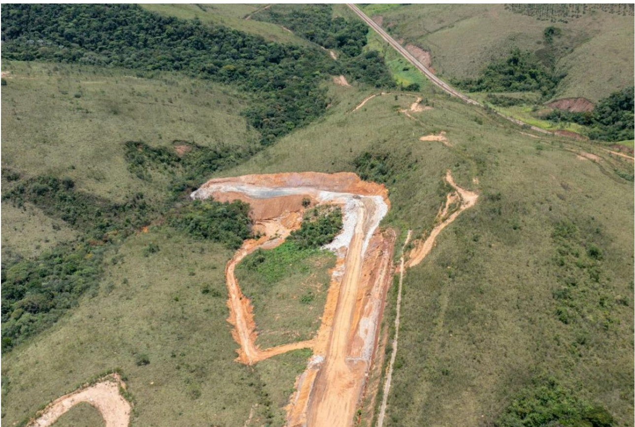
Foto 19: Construção de acesso para investigações à jusante - Forquilha III (janeiro/24).
