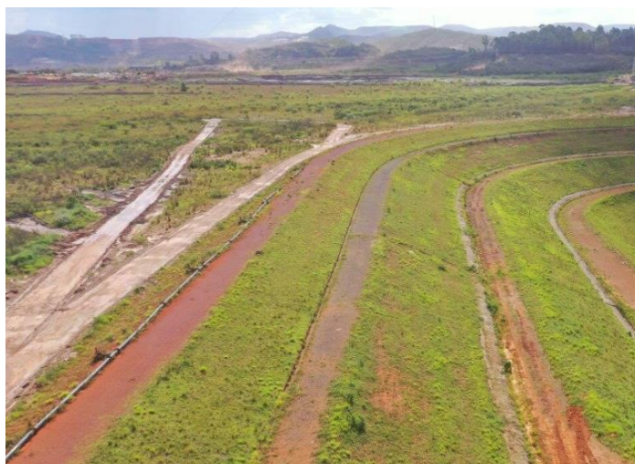
Foto 10: Tubulação existente na crista de Forquilha III.
