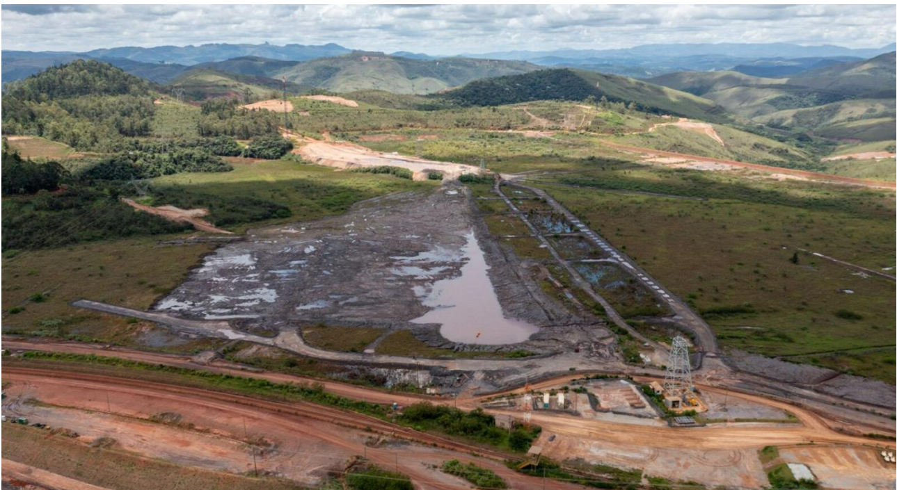
Foto 13: Teste de escavação e canal do PPPC concluídos - Forquilha III (janeiro/24).
