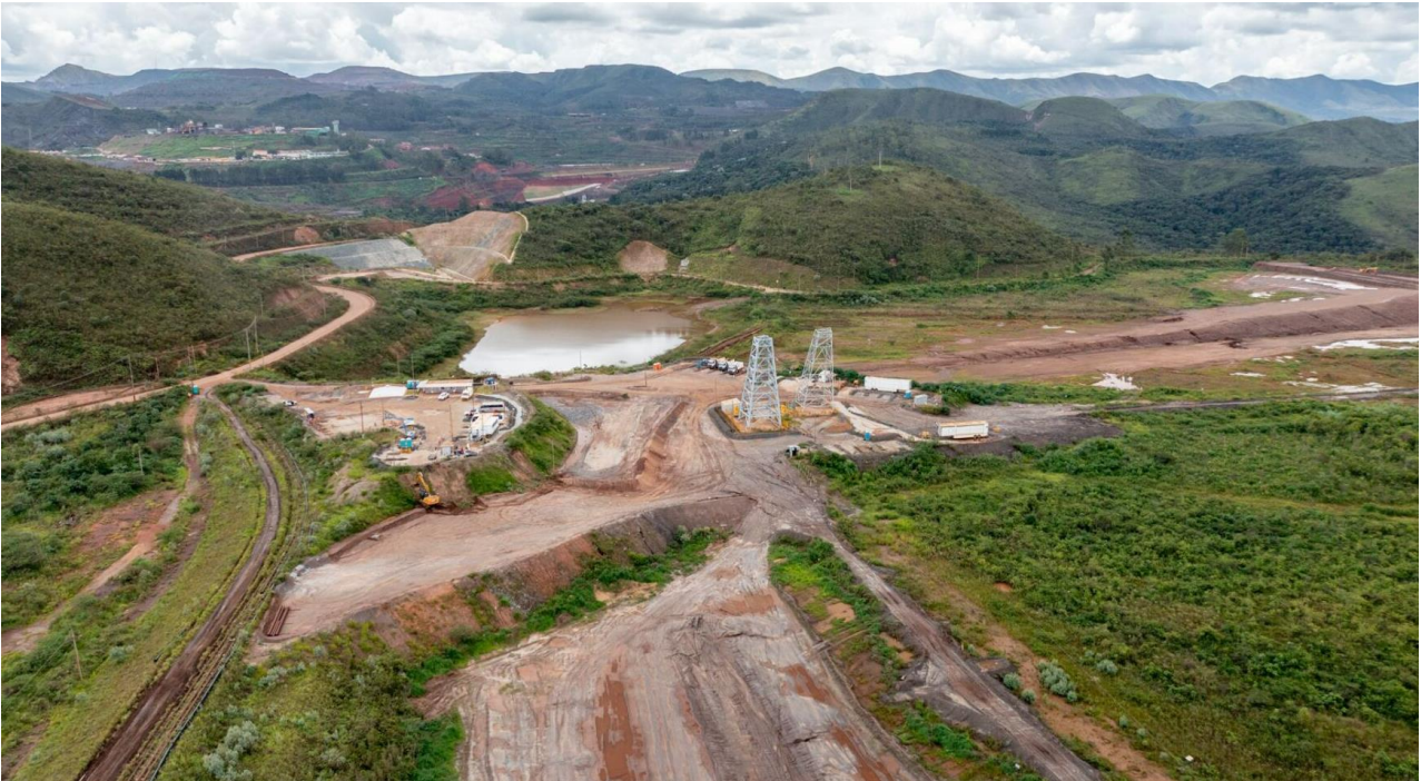
Foto 12. Forquilha II – Canteiro de obra e região de montante (Foto janeiro/24).
