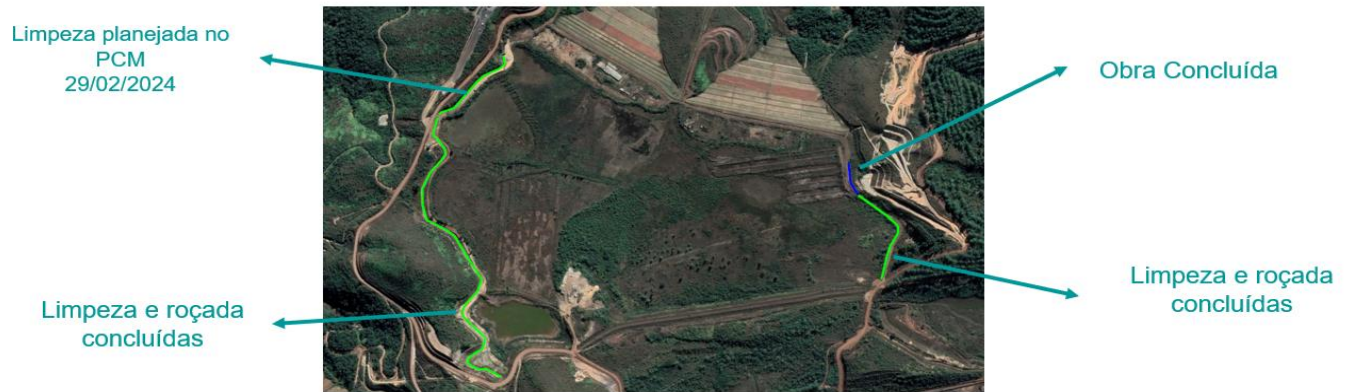
Figura 17: Status da limpeza e desobstrução do canal de cintura – Forquilha I e II
