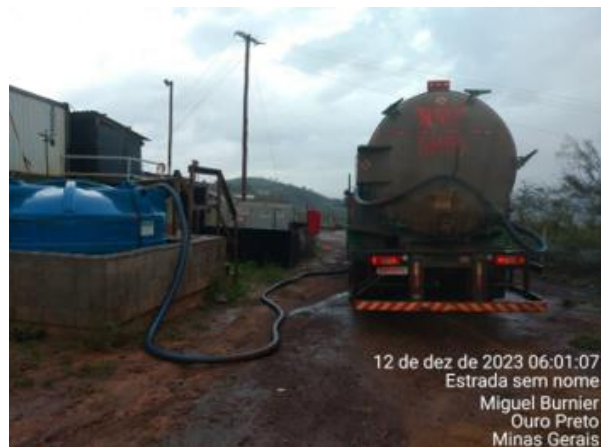
Foto 32. Sucção do tanque séptico no canteiro de Forquilhas realizado pela HB locações. Vale, dezembro de 2023
