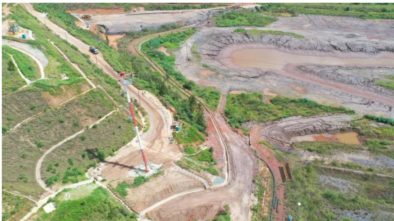
Foto 19: Vista geral do Canal de Cintura de Forquilha II (Janeiro 2024)
