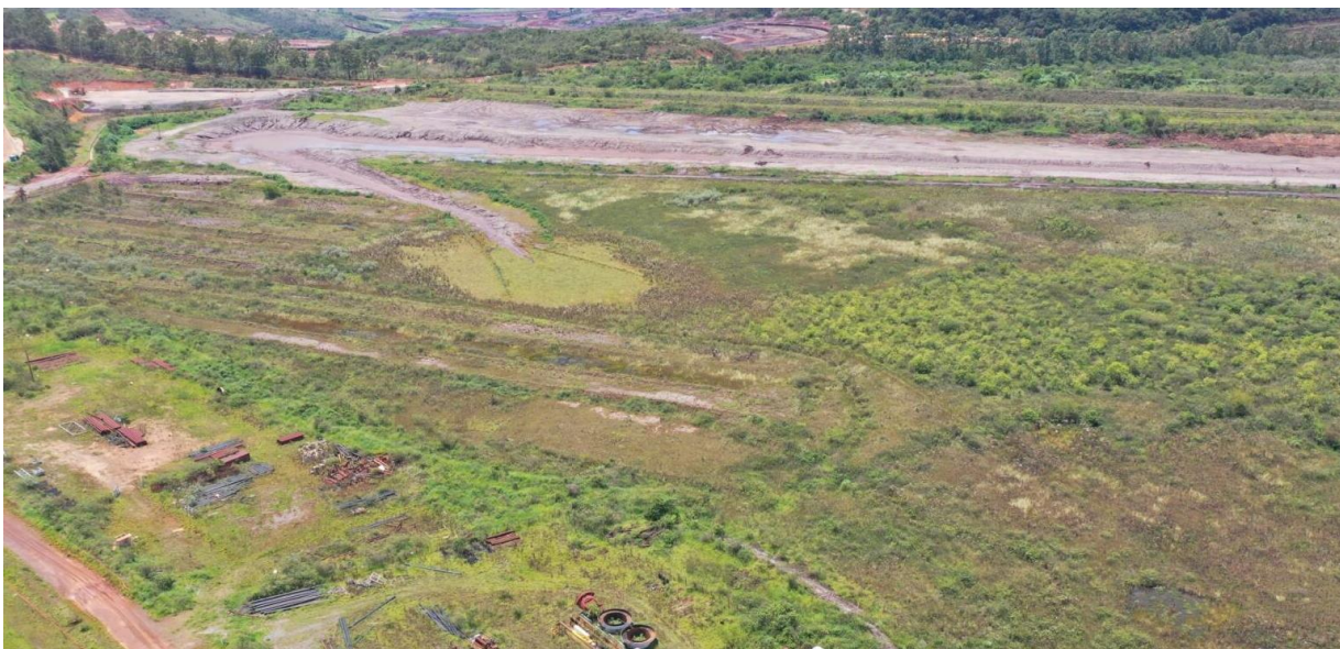
Foto 9. Forquilha II – Canal do teste piloto e canal do plano de chuva – em operação (janeiro/23)
