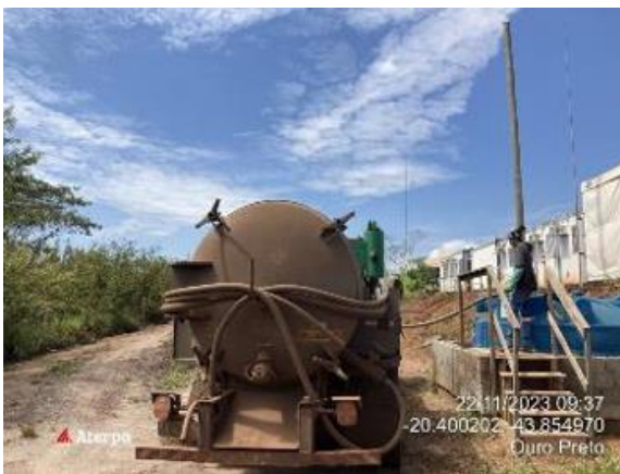
Foto 31. Sucção de efluente sanitário dos tanques sépticos no Canteiro de Forquilhas.Vale, novembro 2023.
