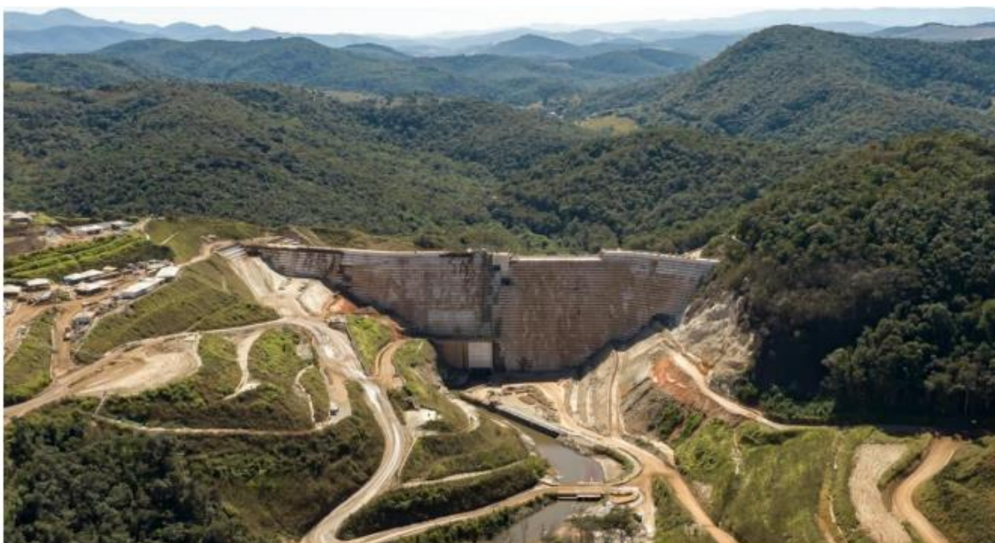
Foto 42. Estrutura de Contenção a Jusante Fábrica. Fonte: Vale, 2022.
