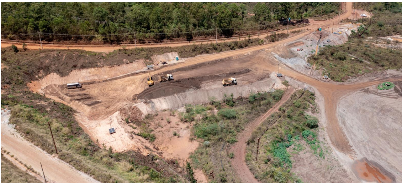
Foto 5. Área de transbordo ou Depósito temporário de Forquilha II
