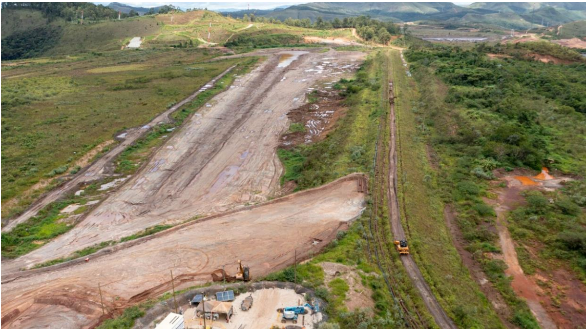
Foto 3. Forquilha II – Dique de montante – retirada de interferências (Foto janeiro/24).
