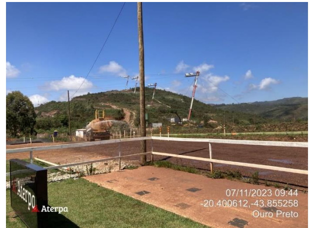
Foto 25. Aspersão frentes de obras da contrata Aterpa. Fonte: Vale, novembro, 2023.
