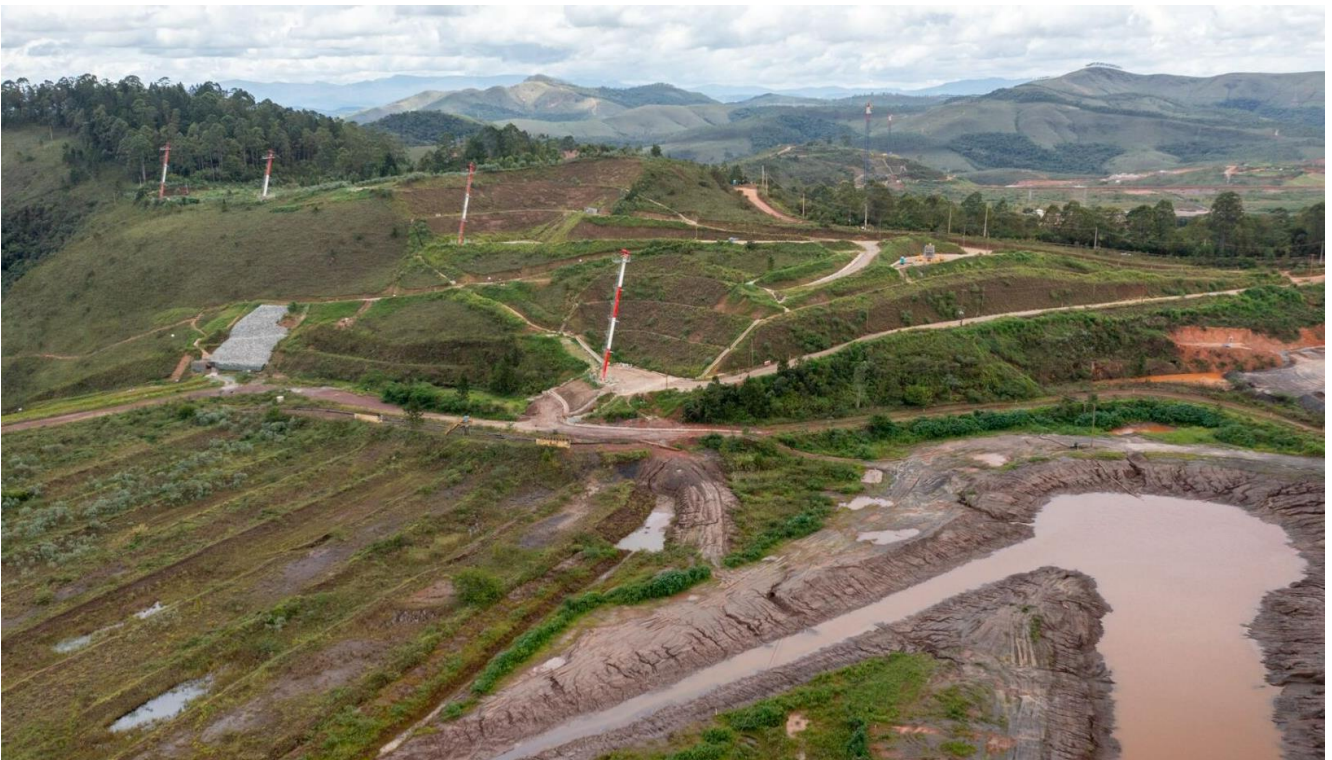
Foto 13. Forquilha II – Condição das obras de contenção ombreira direita (Foto janeiro/24).
