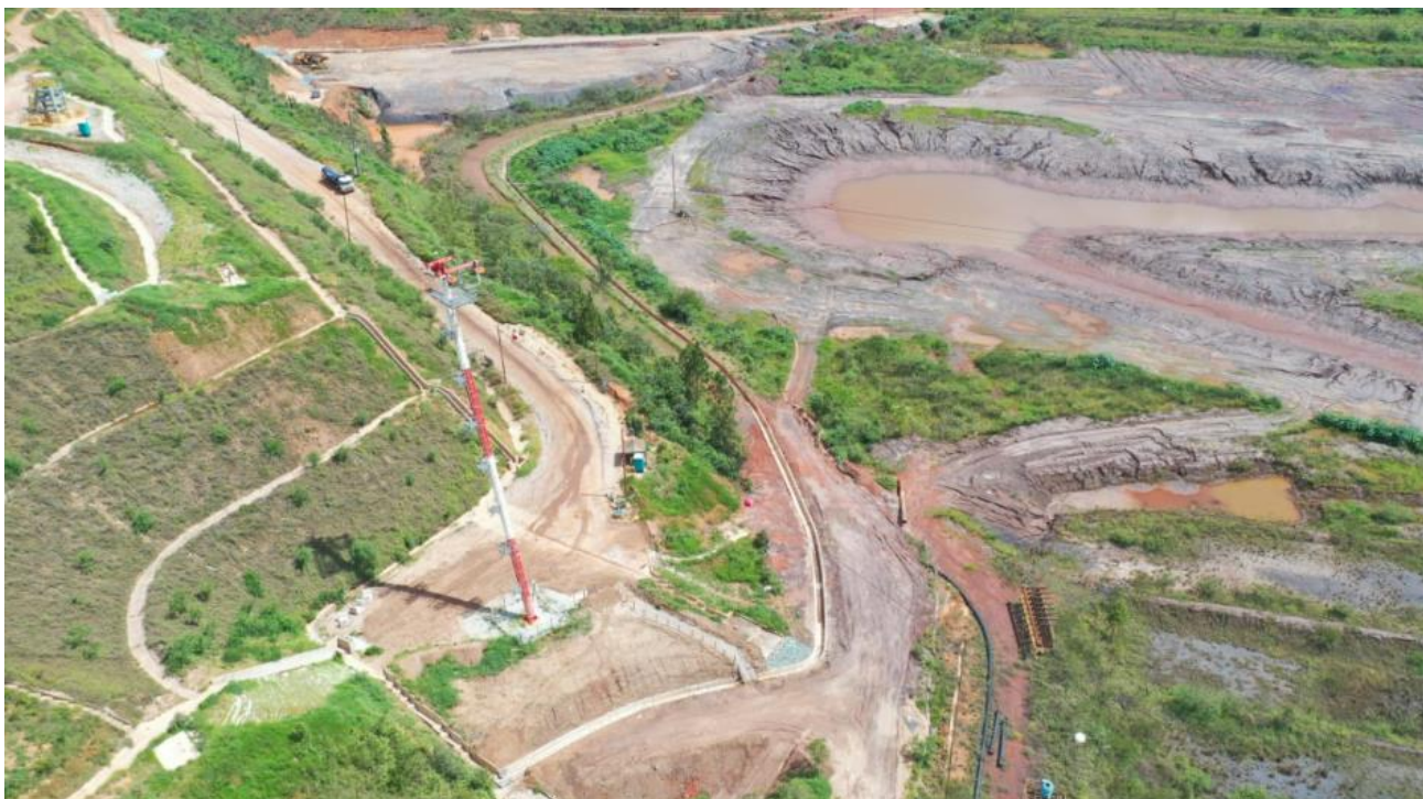
Foto 7. Vista geral do Canal de Cintura de Forquilha II (Janeiro, 2024).
