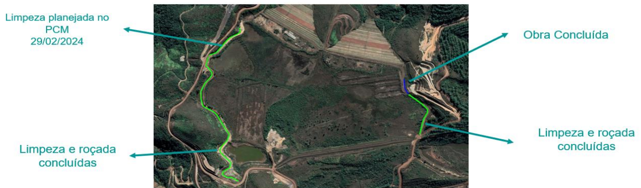
Figura 16: Status da limpeza e desobstrução dos canais de cintura – Forquilha I e II.
