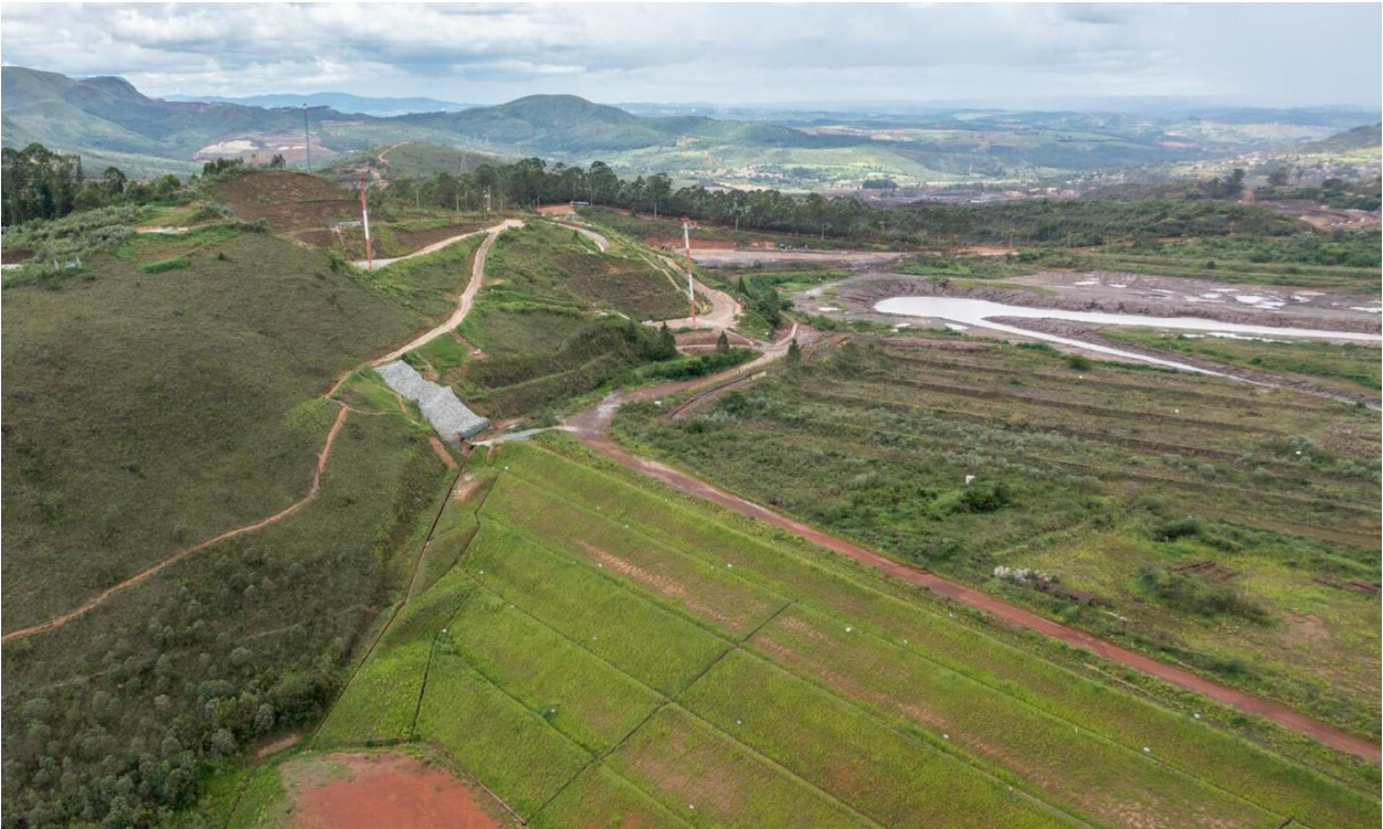
Foto 14. Forquilha II – Condição das obras de contenção ombreira direita (Foto janeiro/24).
