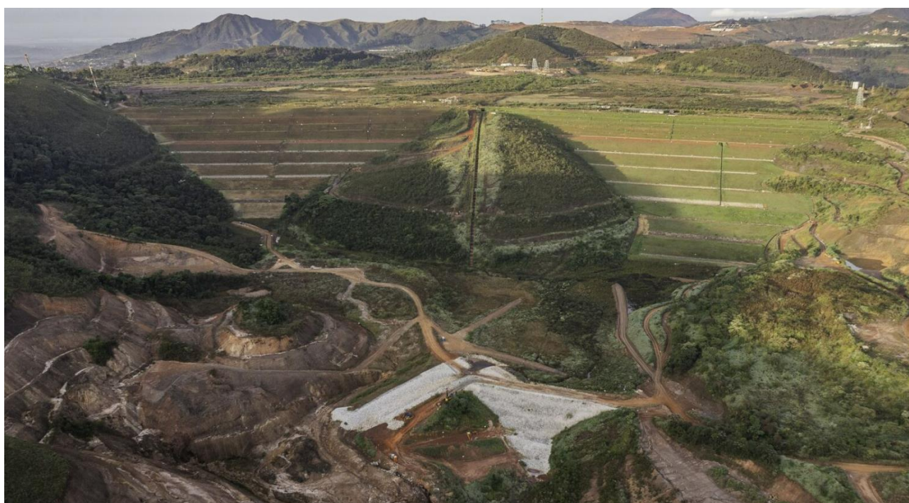
Foto 7. Forquilha I – Sondagens a jusante e ombreiras (Abril/24).
