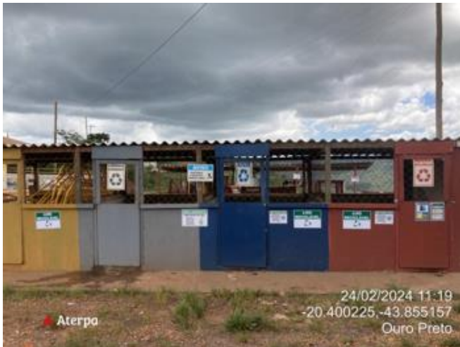
Foto 60: DIR para armazenamento temporário de resíduos no canteiro de Forquilha I e II. Vale, fevereiro de 2024.
