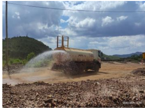
Foto 46. Aspersão frentes de obras da contrata Aterpa. Fonte: Vale, fevereiro, 2024.
