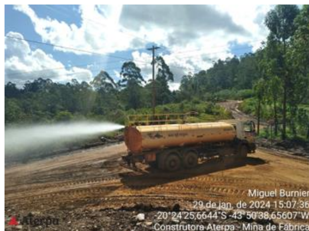
Foto 44. Aspersão das vias. Fonte: Vale, janeiro, 2024.
