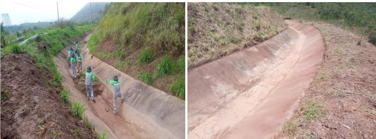
Foto 9 e Foto 10: Status da limpeza e desobstrução dos canais de cintura – Forquilha I e II (abril/24).
