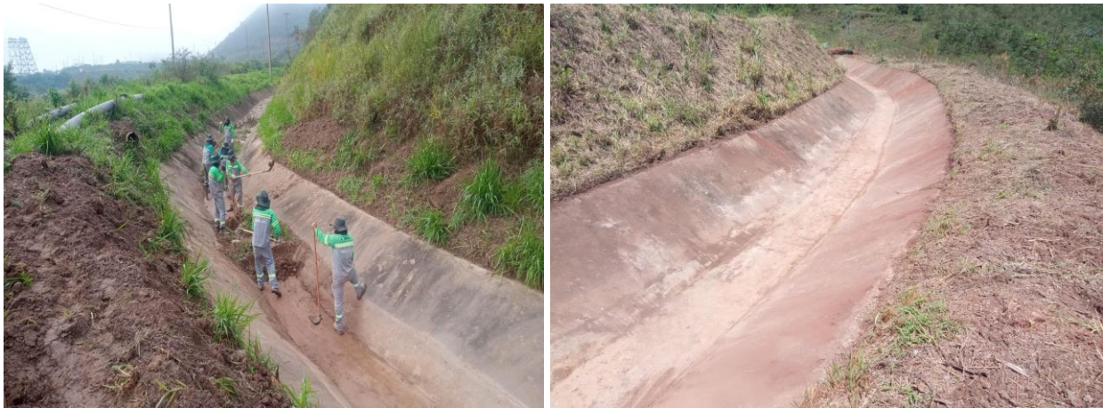
Foto 29 e Foto 30: Status da limpeza e desobstrução dos canais de cintura – Forquilha I e II (abril/24).
