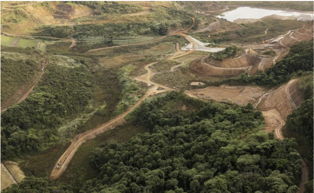
Foto 28. Forquilha I e II – Sondagens à jusante e ombreiras (Abril/24).
