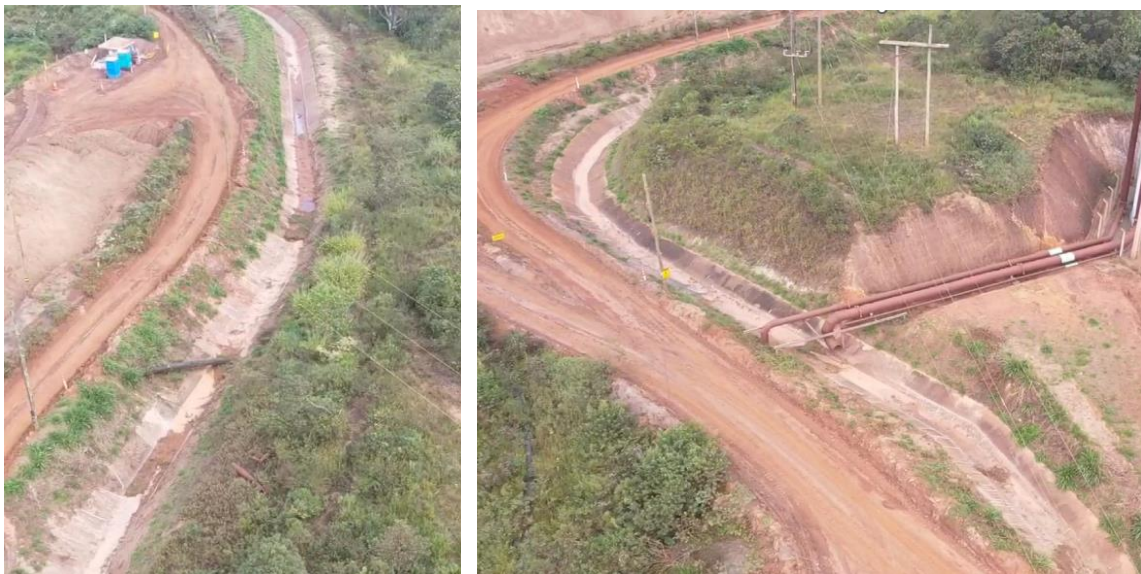
Foto 15 e Foto 16: Status da limpeza e desobstrução dos canais de cintura – Forquilha I e II (abril/24).
