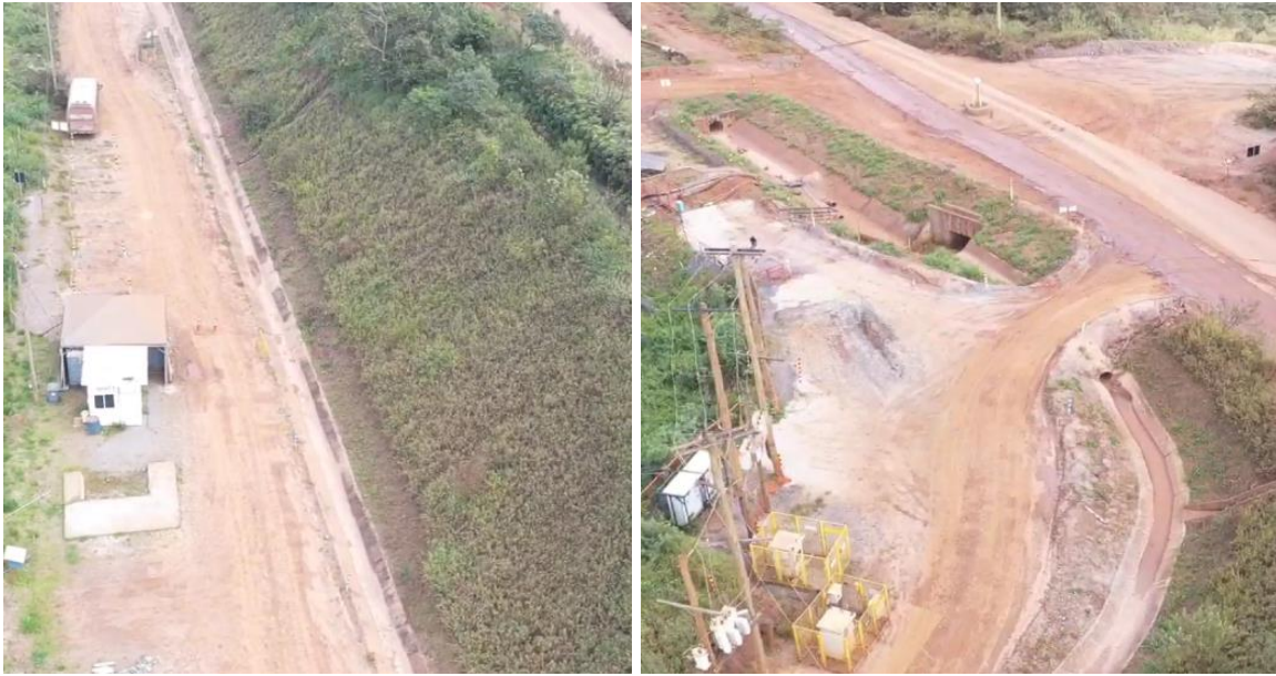
Foto 13 e Foto 14: Status da limpeza e desobstrução dos canais de cintura – Forquilha I e II (abril/24).
