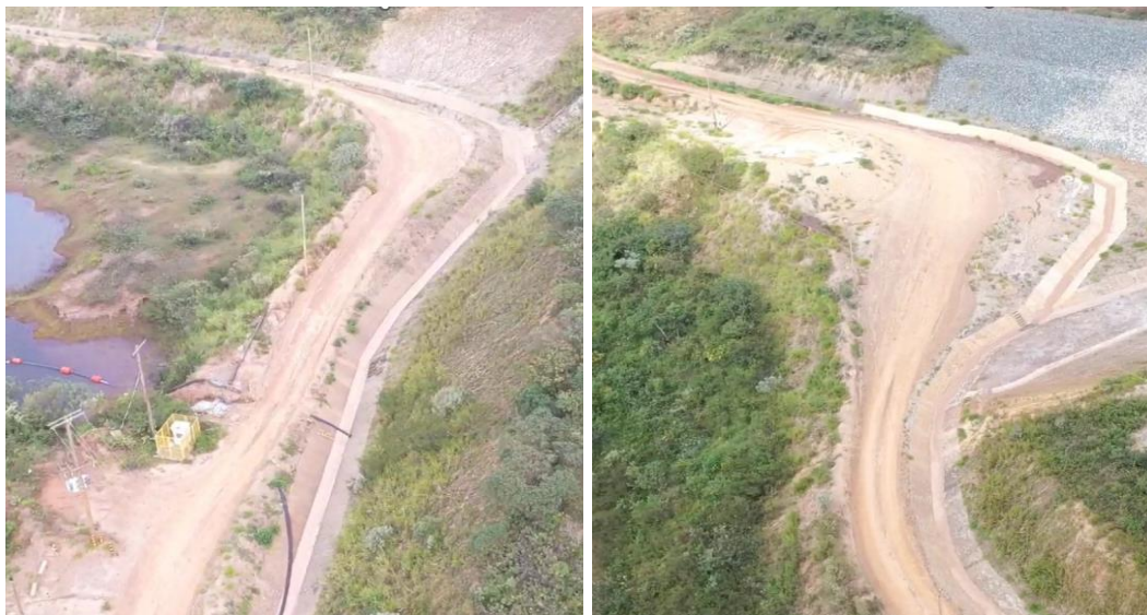
Foto 38 e Foto 39: Status da limpeza e desobstrução dos canais de cintura – Forquilha I e II (abril/24).
