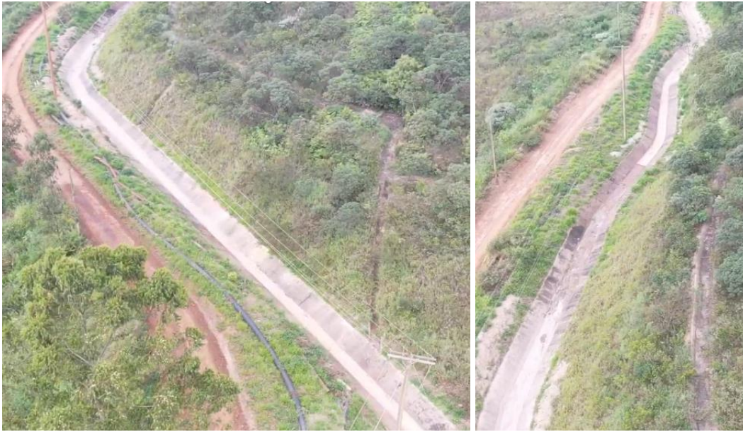
Foto 17 e Foto 18: Status da limpeza e desobstrução dos canais de cintura – Forquilha I e II (abril/24).
