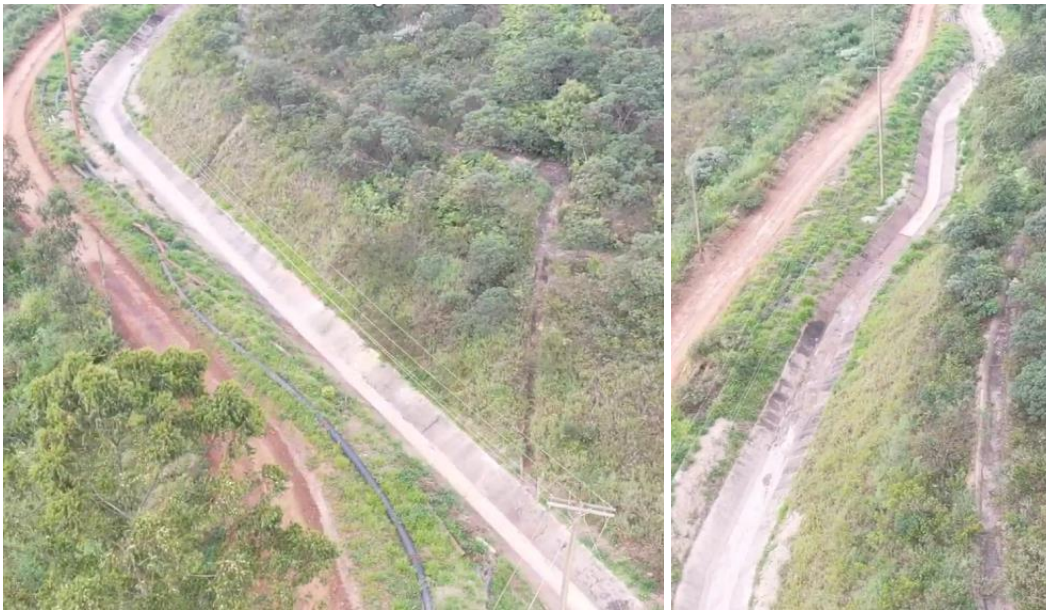
Foto 36 e Foto 37: Status da limpeza e desobstrução dos canais de cintura – Forquilha I e II (abril/24).
