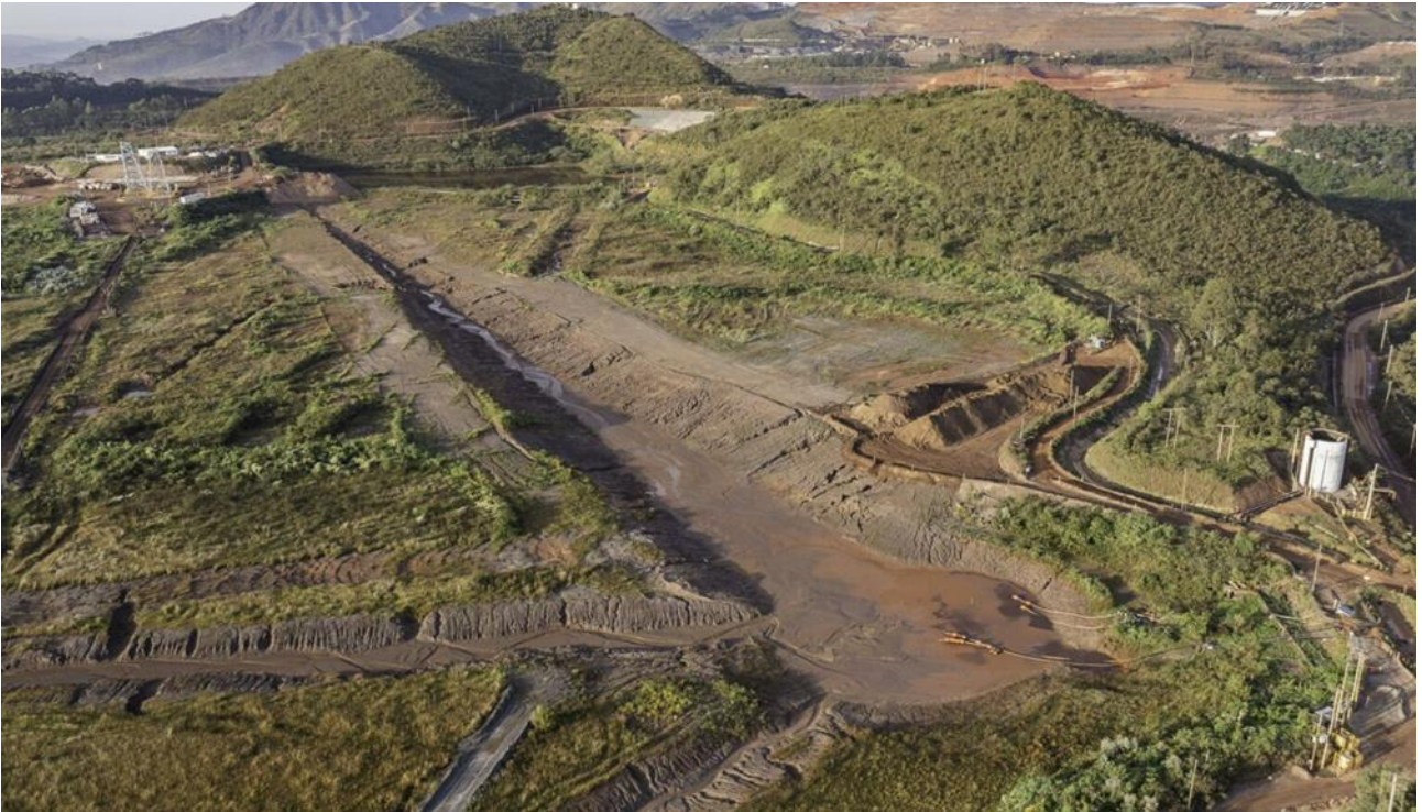
Foto 21. Forquilha I – Canal do teste piloto e canal do plano de chuva (Abril/24).
