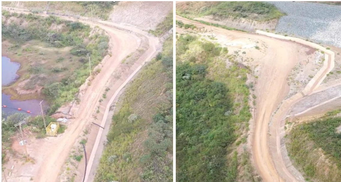
Foto 19 e Foto 20: Status da limpeza e desobstrução dos canais de cintura – Forquilha I e II (abril/24).
