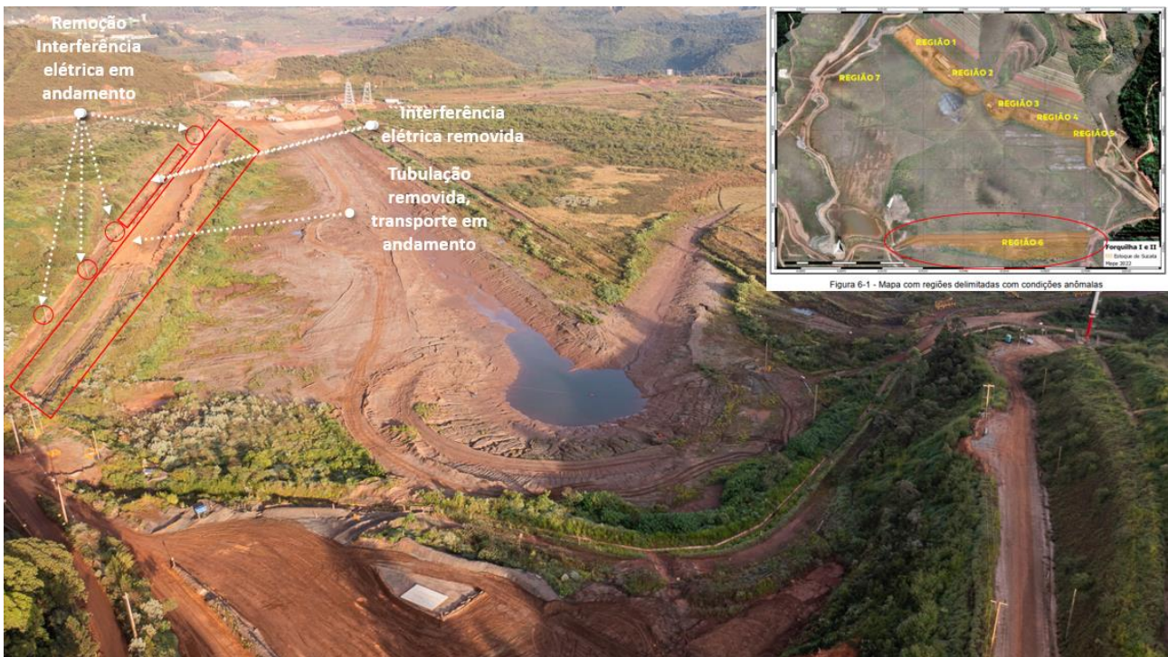
Figura 21: Status de remoção da interferências e infraestruturas (Abril/24).
