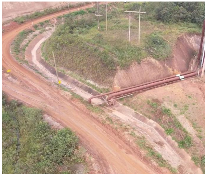
Foto 35: Status da limpeza e desobstrução dos canais de cintura – Forquilha I e II (abril/24).
