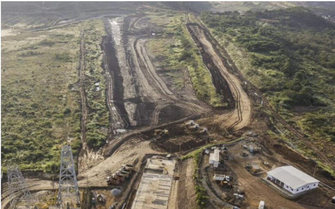
Figura 12: Escavação Dique da Adutora – Forquilha II (Abril/24).
