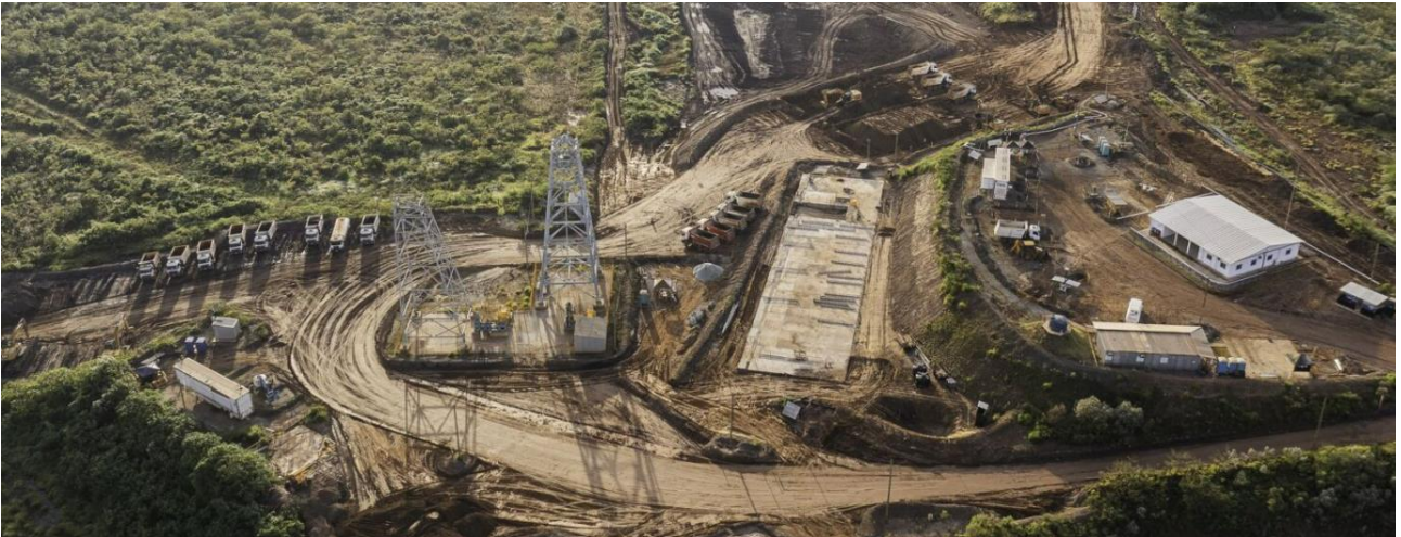
Foto 3. Forquilha I – Mobilização e construção de canteiro de obras à margem montante de Forquilha I e II (Abril/24).
