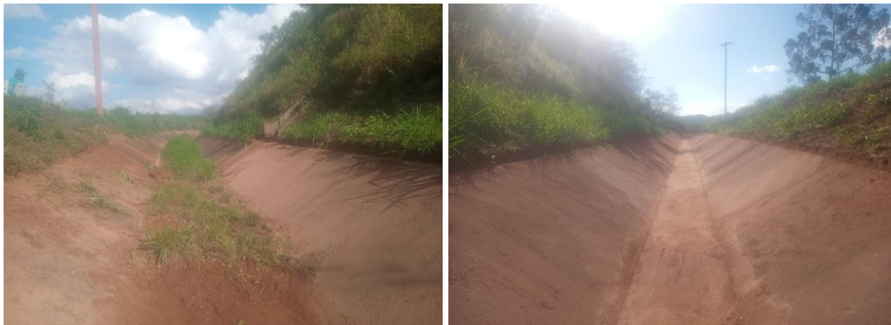
Foto 31 e Foto 32: Status da limpeza e desobstrução dos canais de cintura – Forquilha I e II (abril/24).
