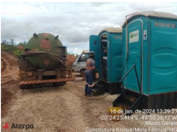
Foto 54. Sucção de efluente sanitário dos tanques sépticos no Canteiro de Forquilhas. Vale, janeiro, 2024.
