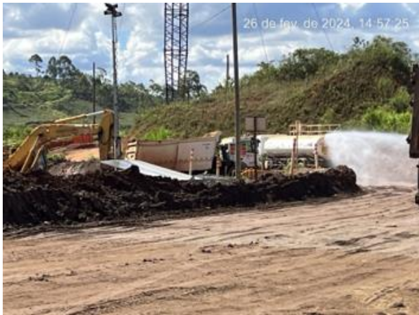
Foto 45. Aspersão de vias. Fonte: Vale, fevereiro, 2024.
