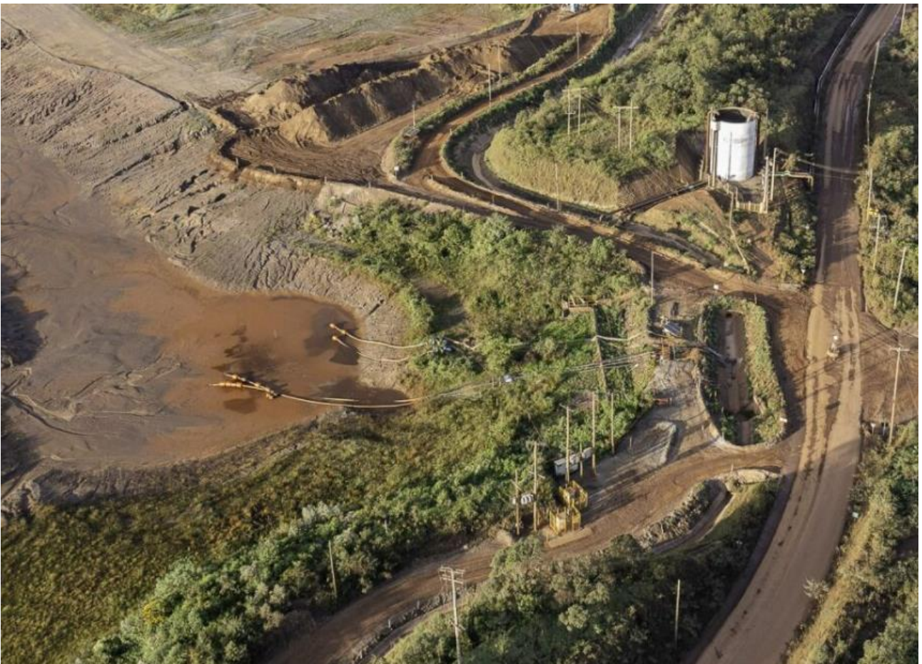
Foto 22. Forquilha I – Sump e sistema de bombeamento (Abril/24).
