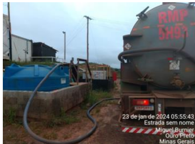
Foto 55. Sucção do tanque séptico no canteiro de Forquilhas realizado pela HB locações - Forquilhas I. Vale, janeiro de 2024.
