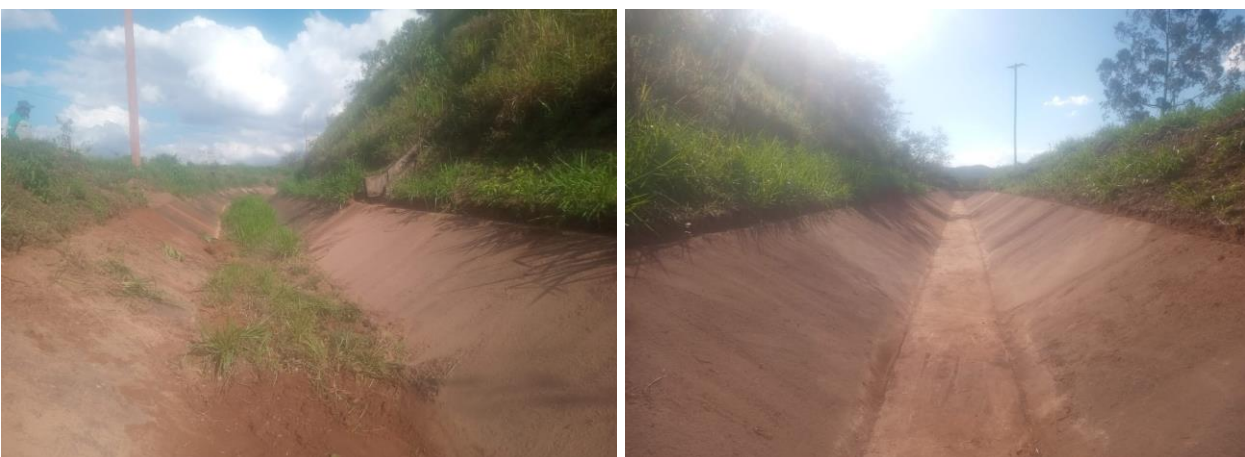
Foto 11 e Foto 12: Status da limpeza e desobstrução dos canais de cintura – Forquilha I e II (abril/24).
