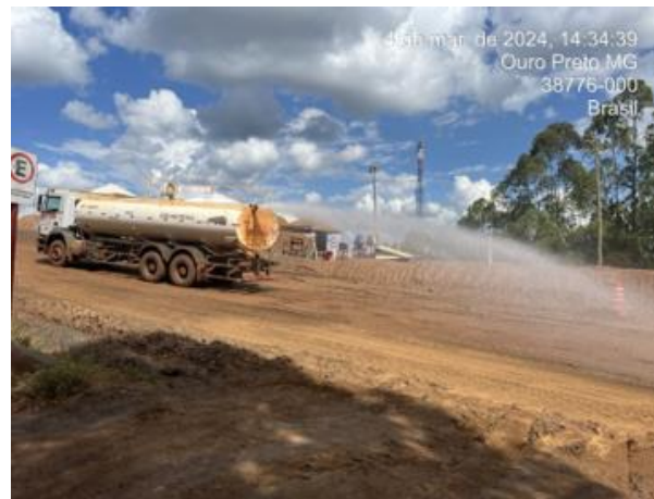
Foto 48: Caminhão pipa realizando aspersão das vias. Fonte: Vale, março, 2024.
