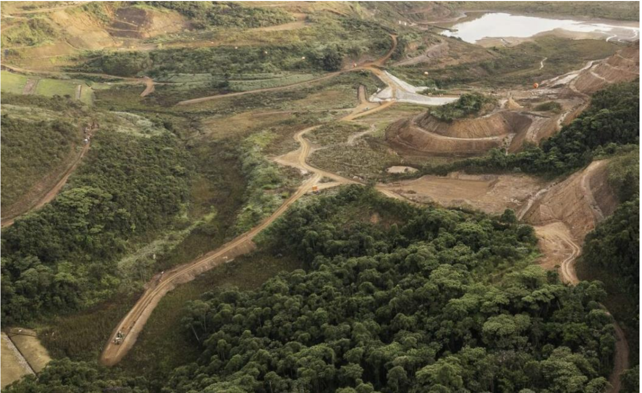
Foto 8. Forquilha I e II – Sondagens a jusante e ombreiras (Abril/24).
