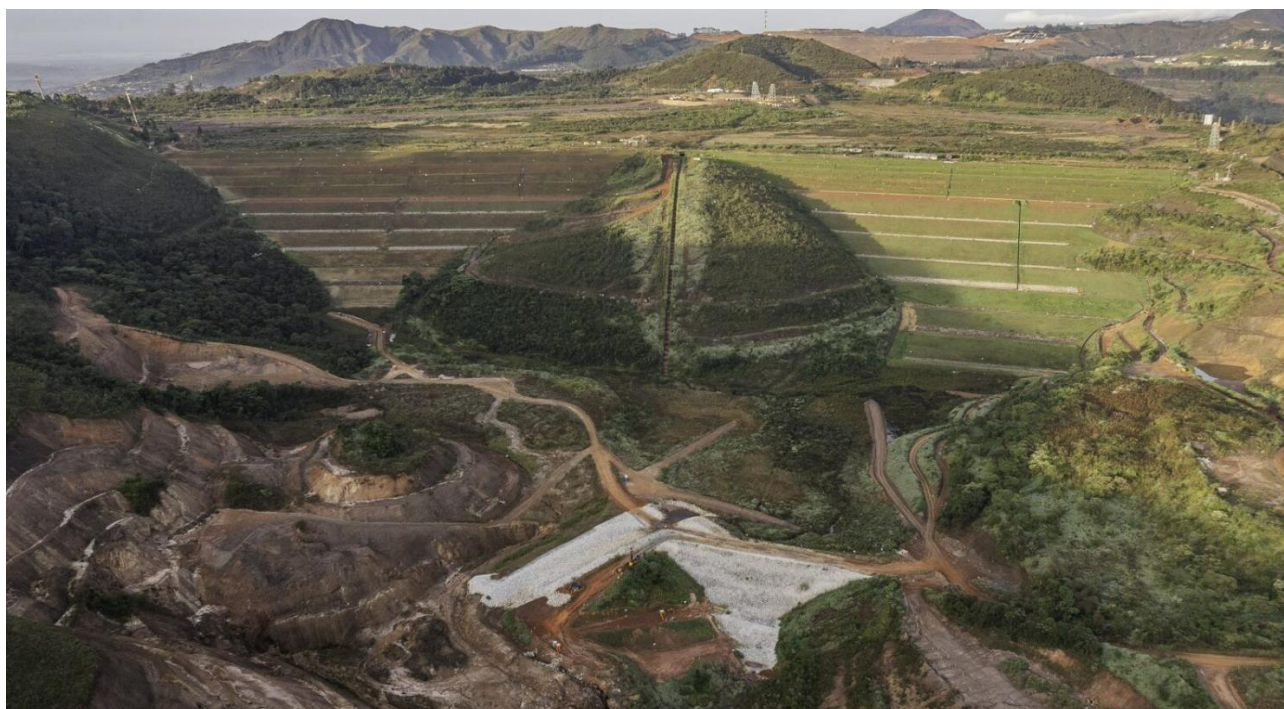
Foto 27. Forquilha I – Sondagens à jusante e ombreiras (Abril/24).
