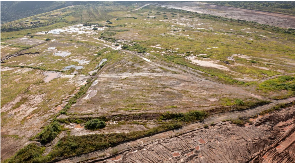
Figura 15 - Forquilha I – Vista geral após raspagem superficial reservatório (Janeiro/25).
