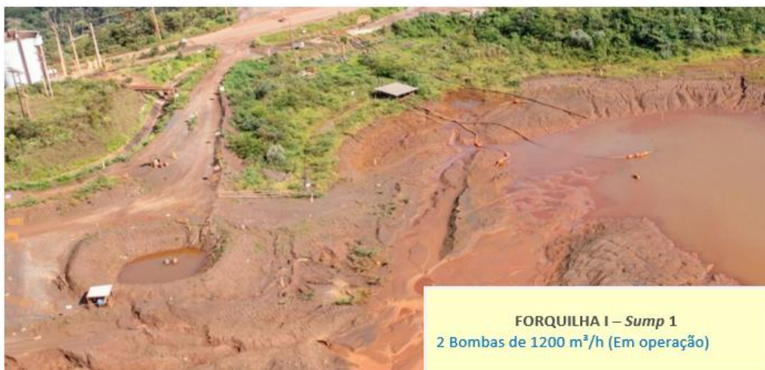
Figura 22 - Sistema de bombeamento no Sump 1 (Janeiro/25)
