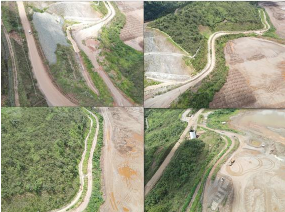
Figura 40 - Estado de conservação e limpeza dos canais de cintura (Janeiro/25).
