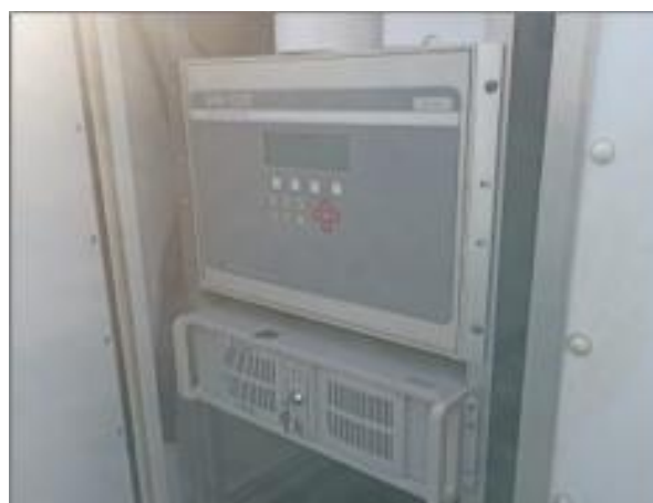
Figura 74 - Estação de Monitoramento de Qualidade do Ar Mota. Fonte: Fonte: Vale, 2023.
