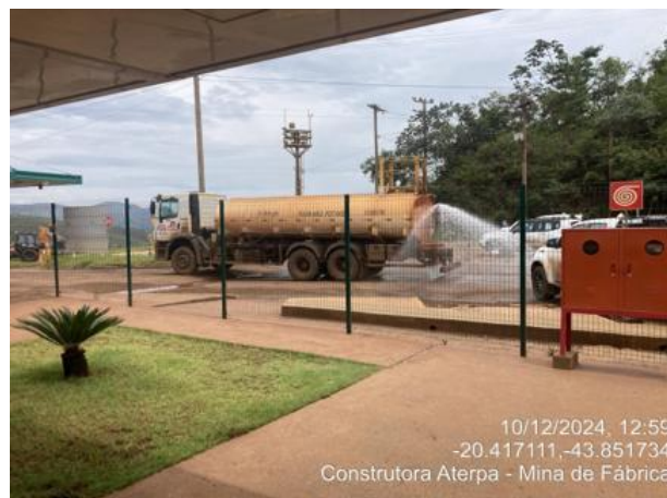
Figura 65 - Caminhão pipa realizando aspersão das vias. Fonte: Vale, dezembro de 2024.
