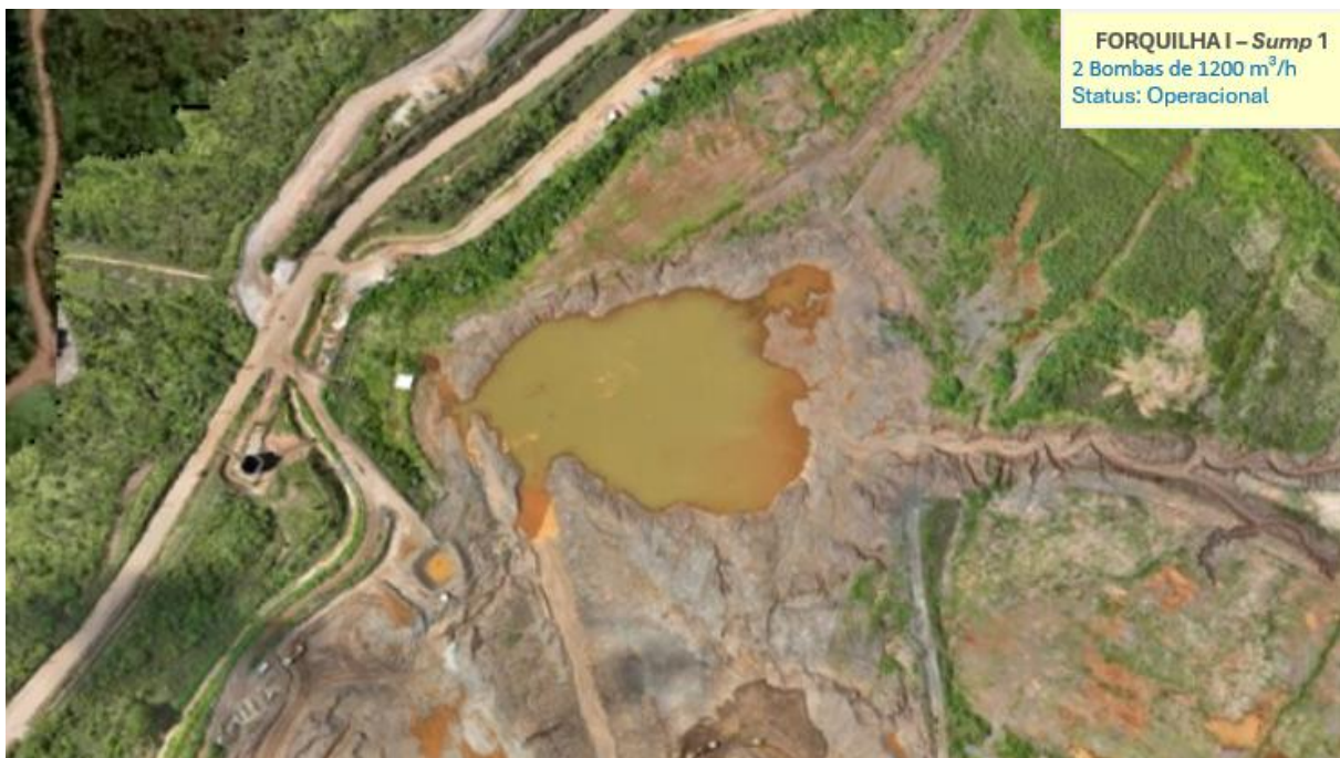
Figura 45 - Manutenção do sistema de bombeamento (Janeiro/25).
