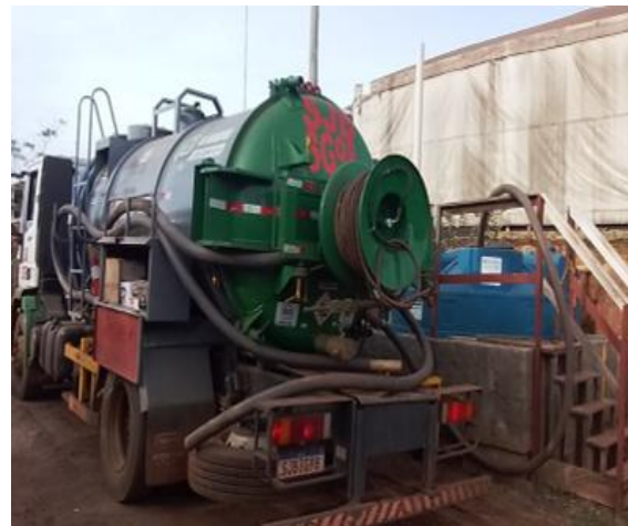
Figura 106 - Recolhimento de efluentes do tanque localizado no canteiro (Fonte: Vale, 2024).
