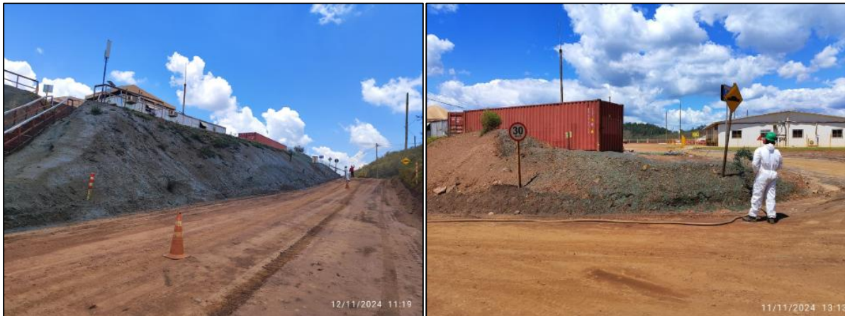
Figura 57 - Aplicação de MVP nos taludes da região do COR. Fonte: Vale, 2025.
