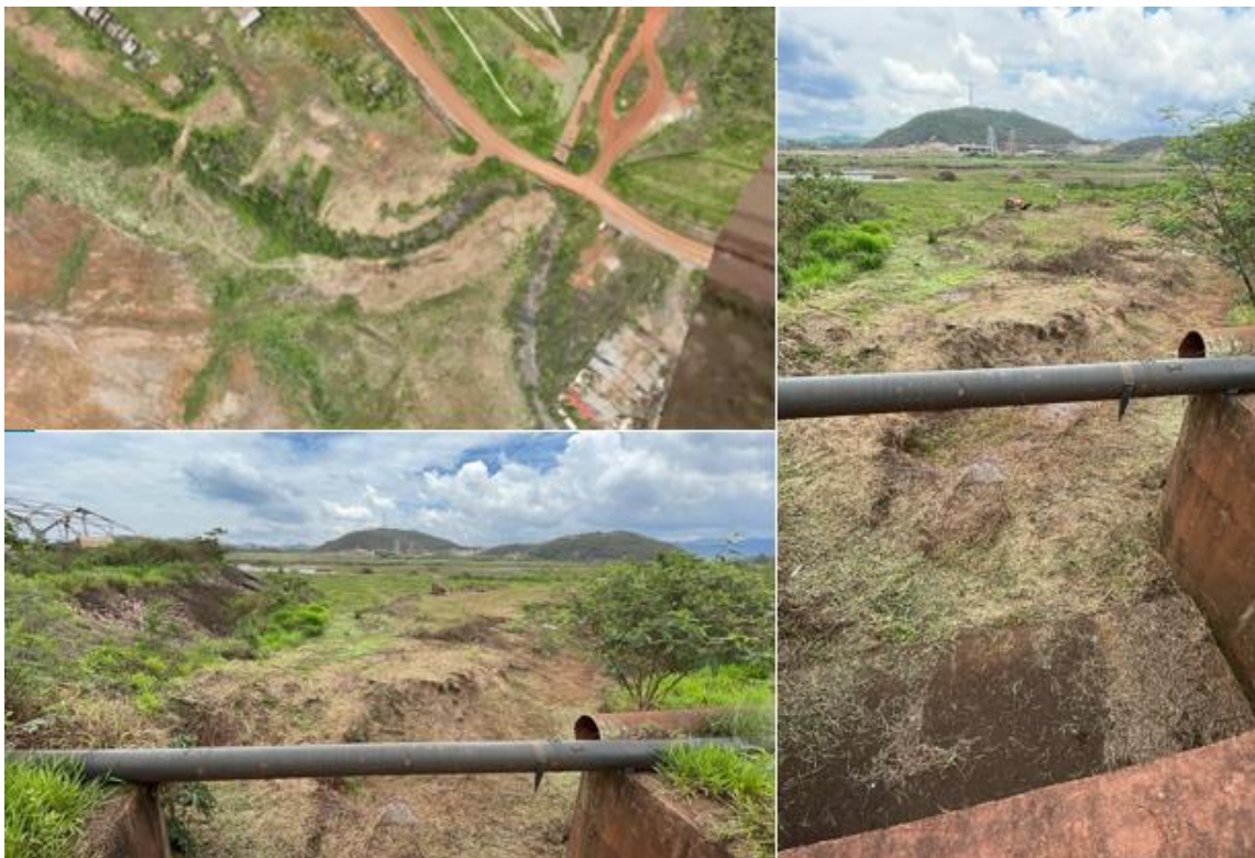
Figura 39 - Limpeza canal de aproximação Novembro/25.
