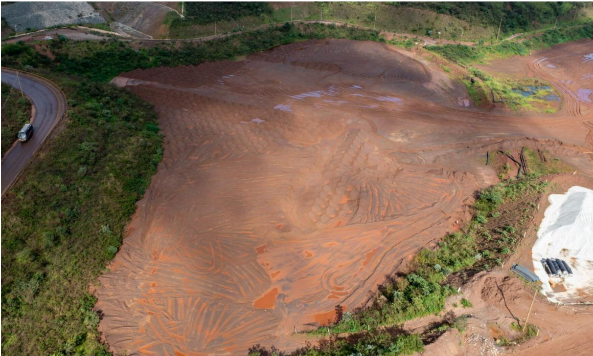
Figura 14 - Forquilha I – Execução do PPPC 24/25 – aterro Lagoa das Capivaras (Janeiro/2025).
