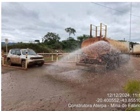
Figura 64 - Aspersão frentes de obras da contratada Aterpa (canteiro DB). Fonte: Vale, dezembro de 2024.
