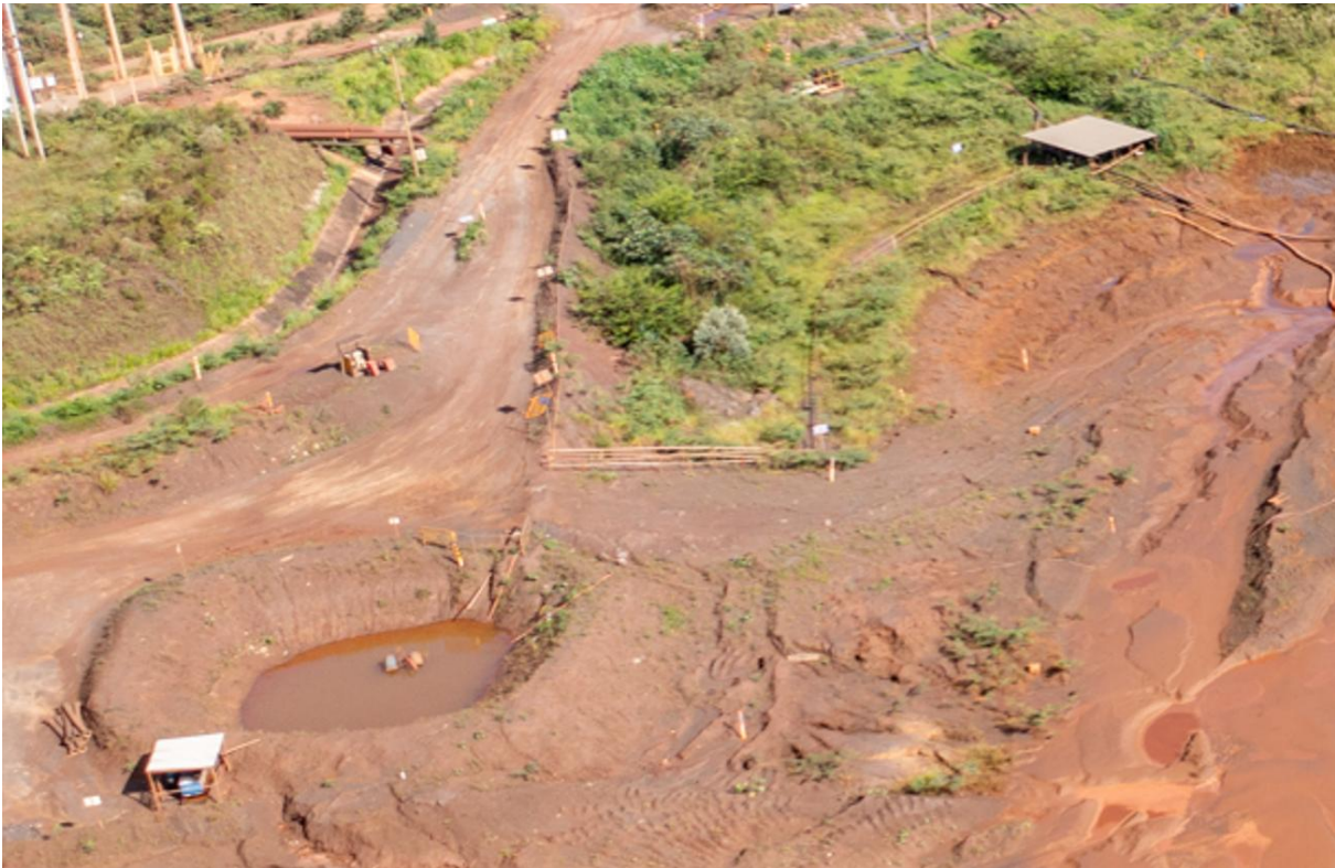
Figura 24 - Melhorias na praça de posicionamento das bombas de Forquilha I - recomendação F1-0148 (Janeiro/24).
