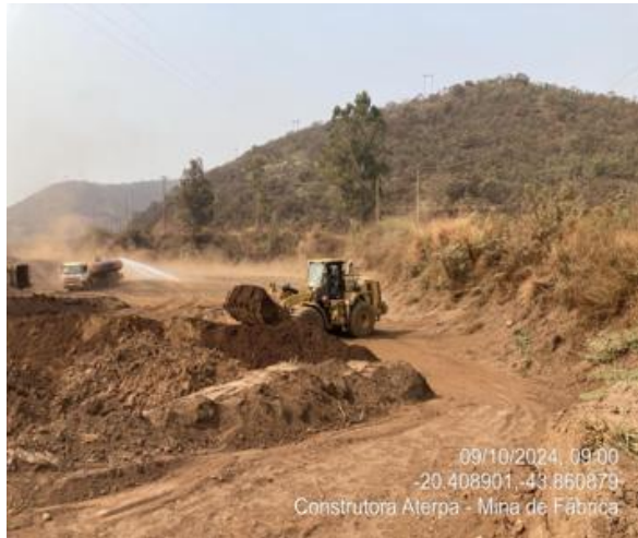
Figura 61 - Aspersão das vias. Fonte: Vale, outubro de 2024.
