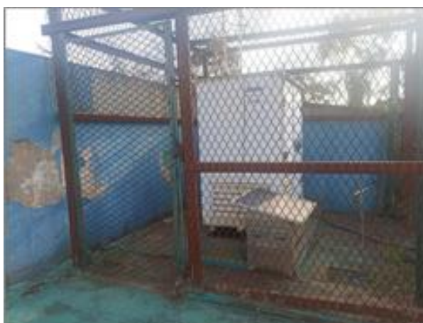
Figura 73 - Estação de Monitoramento de Qualidade do Ar Mota. Fonte: Fonte: Vale, 2023.
