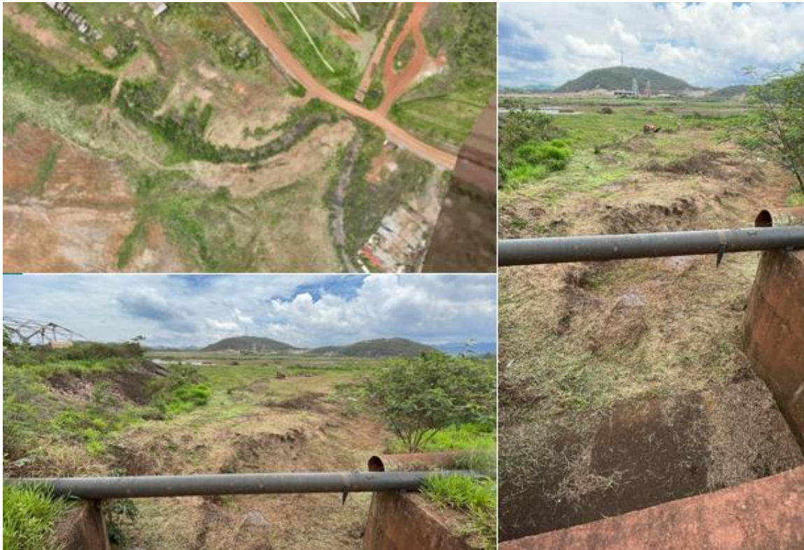
Figura 47 - Limpeza canal de aproximação Novembro/25
