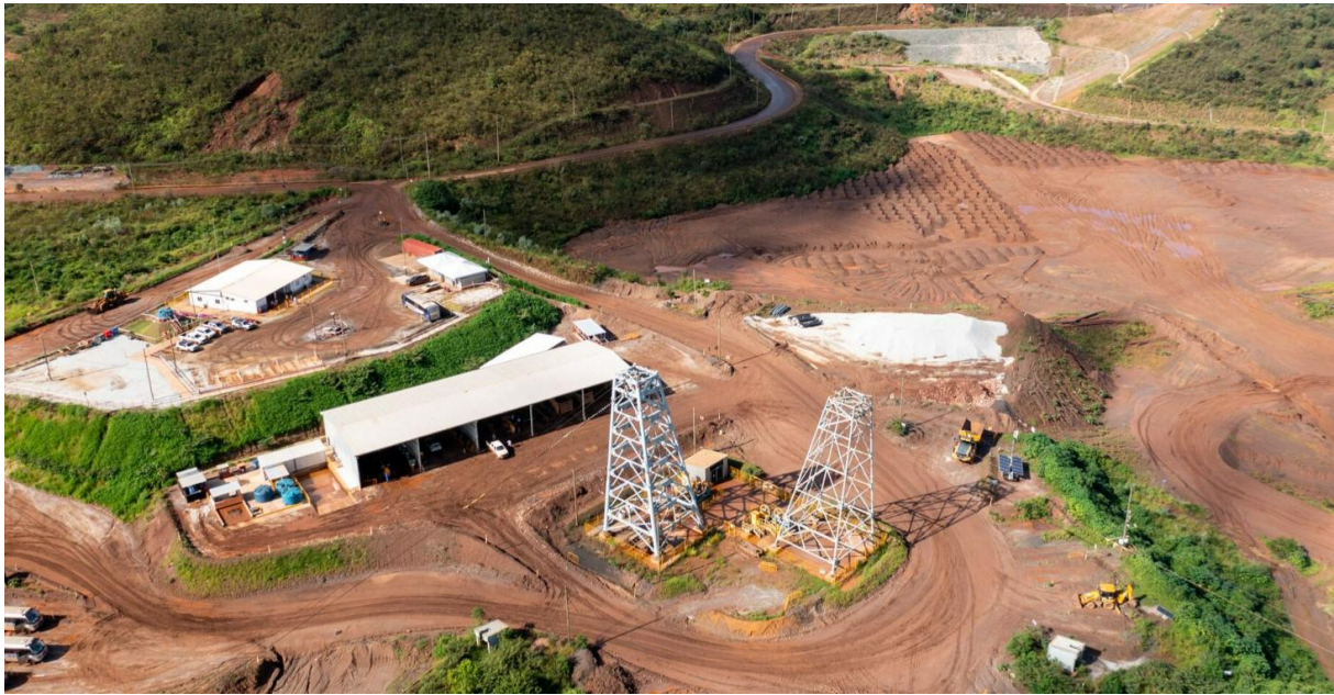
Figura 16 - Forquilha I – Canteiro de obras (Janeiro/25)
