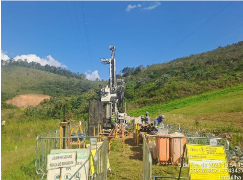
Figura 10 - Forquilha I – Sondagem rotativa com Hollow Auger- (SM-25 – Fevereiro/25).
