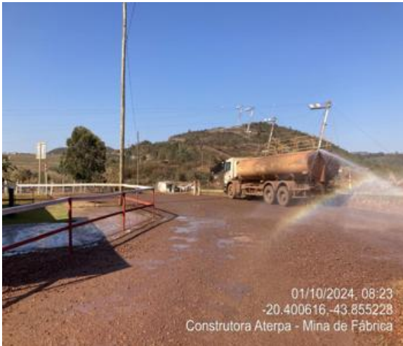
Figura 60 - Atividades de aspersão das vias. Fonte: Vale, outubro de 2024.
