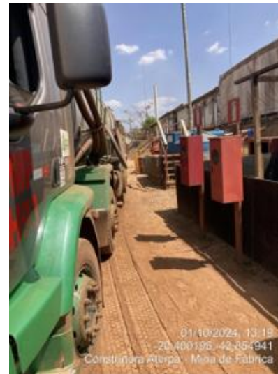
Figura 108 - Recolhimento de efluentes do tanque localizado no canteiro (Fonte: Vale, 2024).
