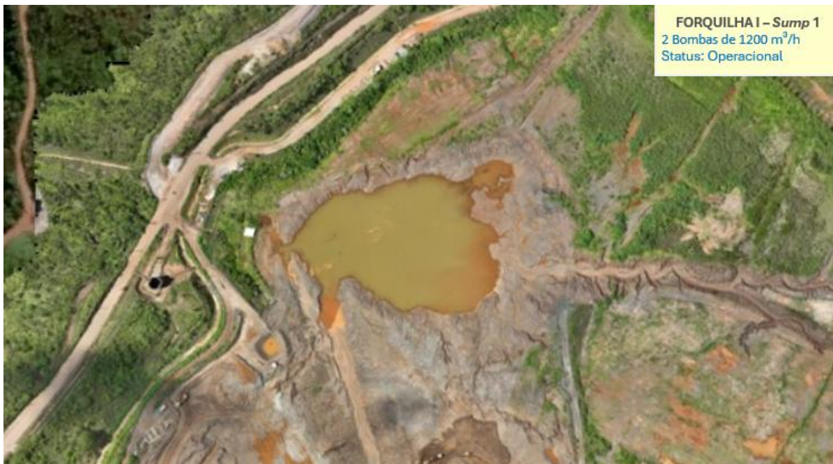
Figura 33 – Sistema de bombeamento PPC 24/25 (Janeiro/25).
