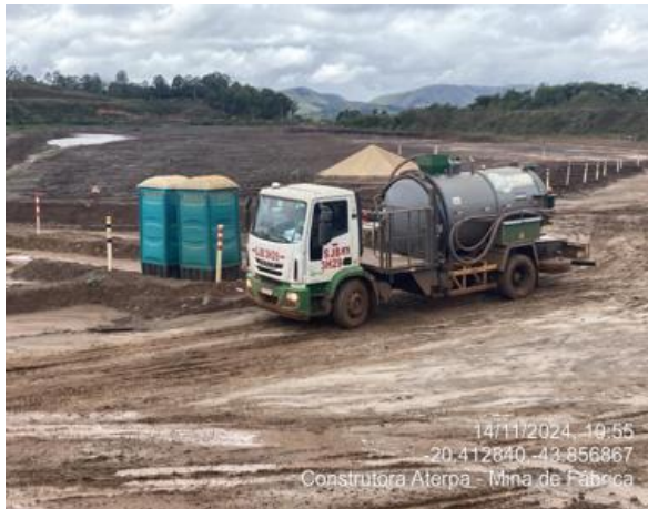
Figura 105 - Manutenção dos banheiros químicos disponíveis nas frentes de obra (Fonte: Vale, 2024).
