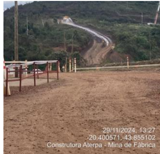
Figura 63 - Aspersão de água nos acessos de obra. Fonte: Vale, novembro de 2024.
