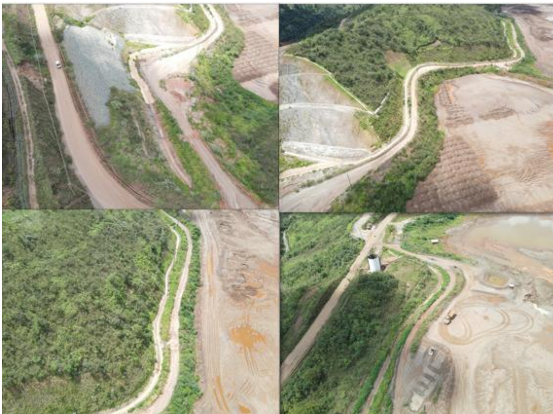
Figura 48 - Estado de conservação e limpeza dos canais de cintura (Janeiro/25)
