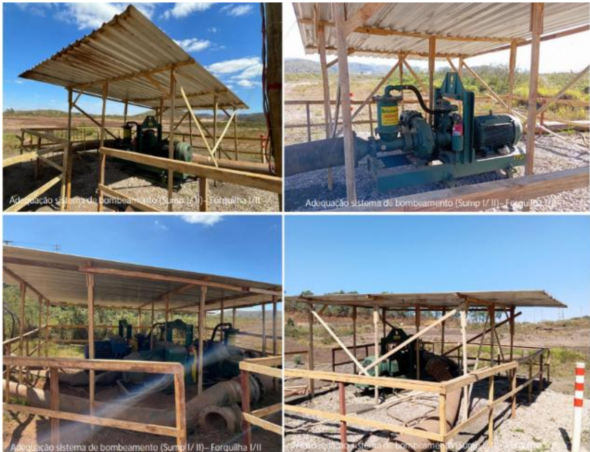
Figura 23 - Melhorias na praça de posicionamento das bombas de Forquilha I - recomendação F1-0148 (Julho/24).
