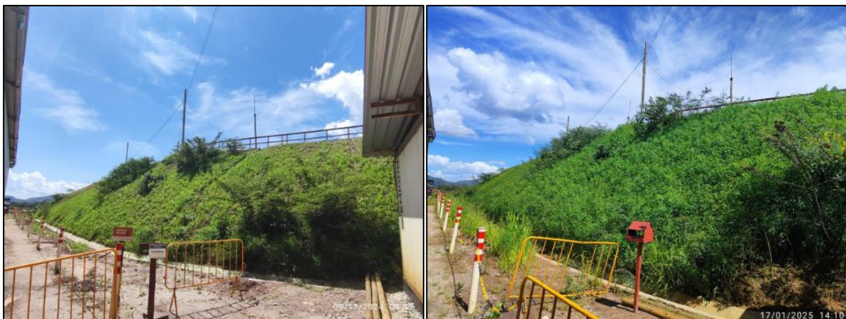
Figura 58 - Resultado da aplicação de MVP nos taludes da região do COR. Fonte: Vale, 2025.
