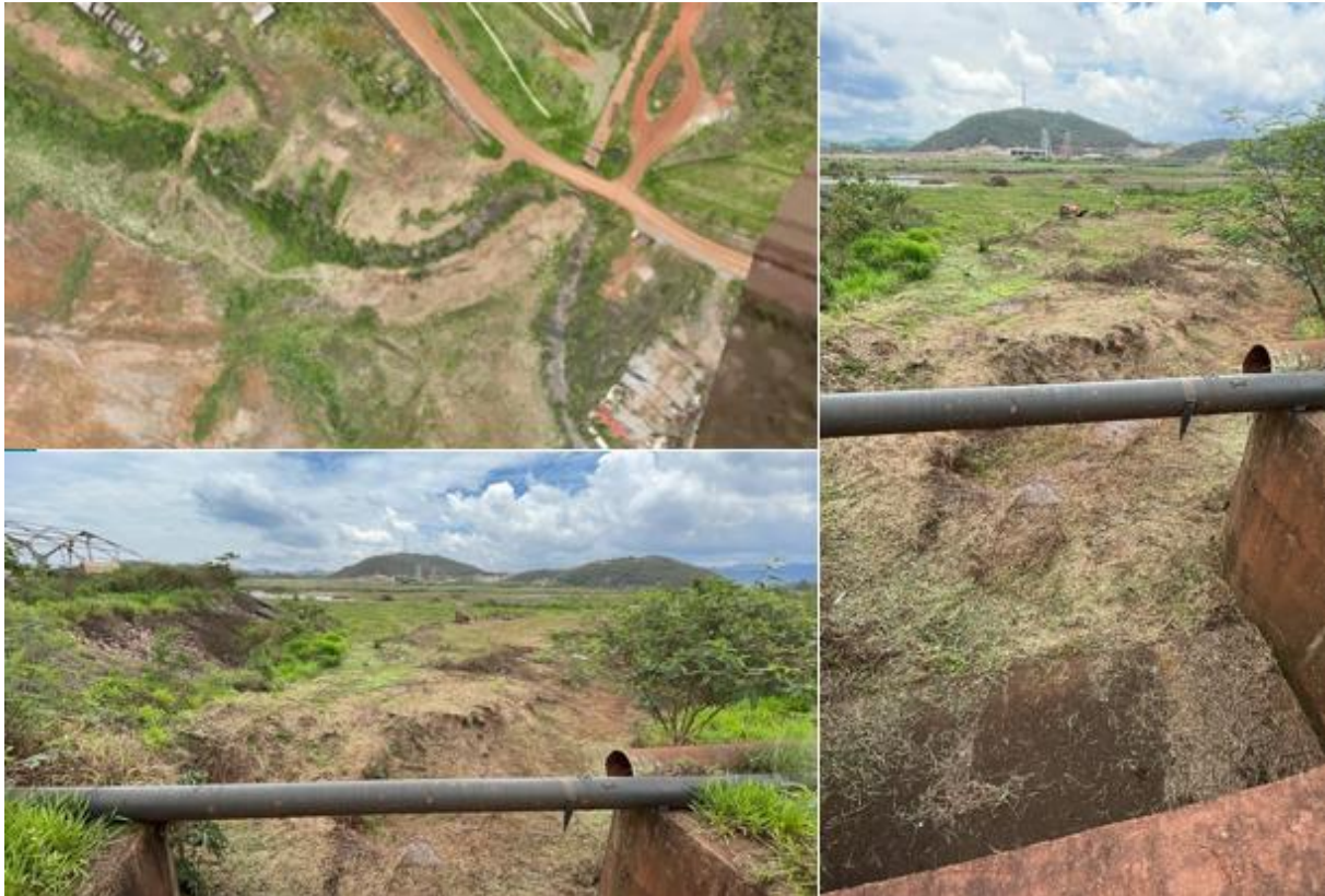
Figura 44 - Limpeza canal de aproximação (Novembro/24).
