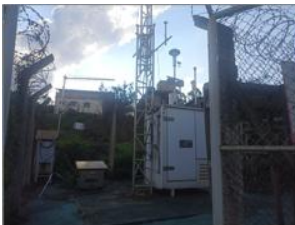
Figura 71 - Estação de Monitoramento de Qualidade do Ar Pires. Fonte: Vale, 2023.
