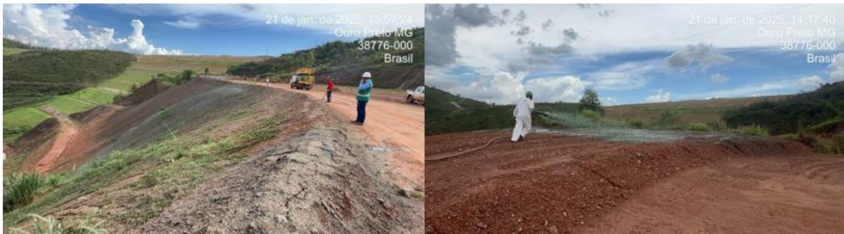
Figura 18 - Aplicação hidrossemeadura em janeiro/25
