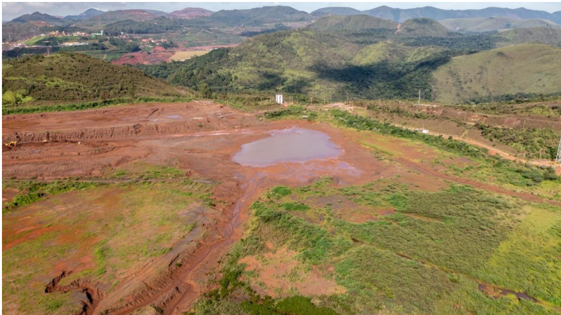
Figura 41 - Sump 1 em andamento (Janeiro/25).
