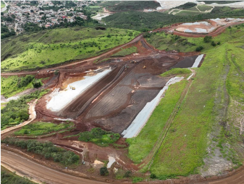
Foto 9. Aterro do reforço do Dique 1 – foto dia 11/01/24 (Em andamento).
