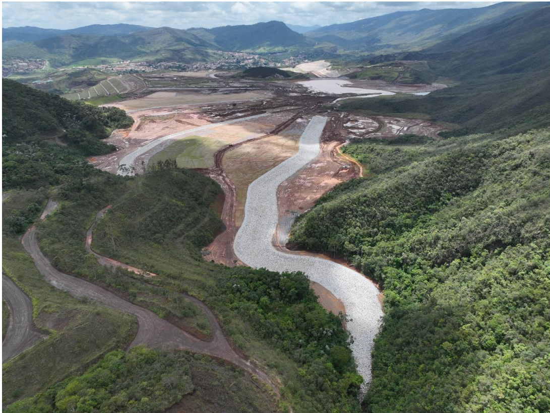
Foto 5. Reconformação do reservatório foto dia 11/01/24 (Em andamento).
