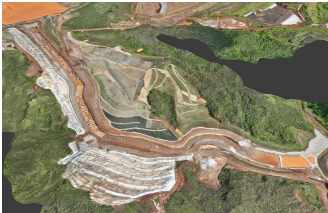
Foto 6. Construção do canal extravasor em concreto foto dia 11/01/24 (Concluído)
