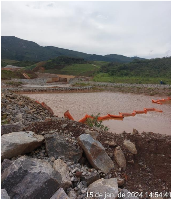
Foto 14 e Foto 15. Bacia de Contenção à jusante do extravasor.
