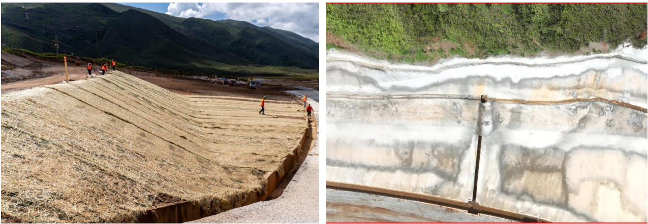
Foto 10 e Foto 11. Canaletas e escada de drenagem
