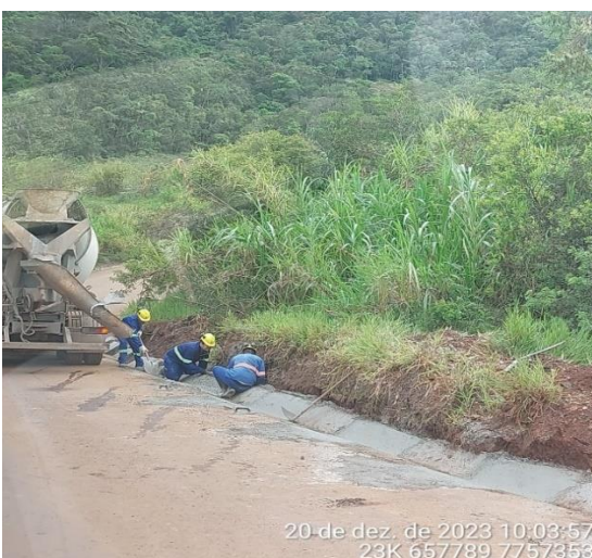
Foto 12 e Foto 13. Implantação da canaleta de drenagem no acesso e limpeza do sump a jusante do maciço principal
