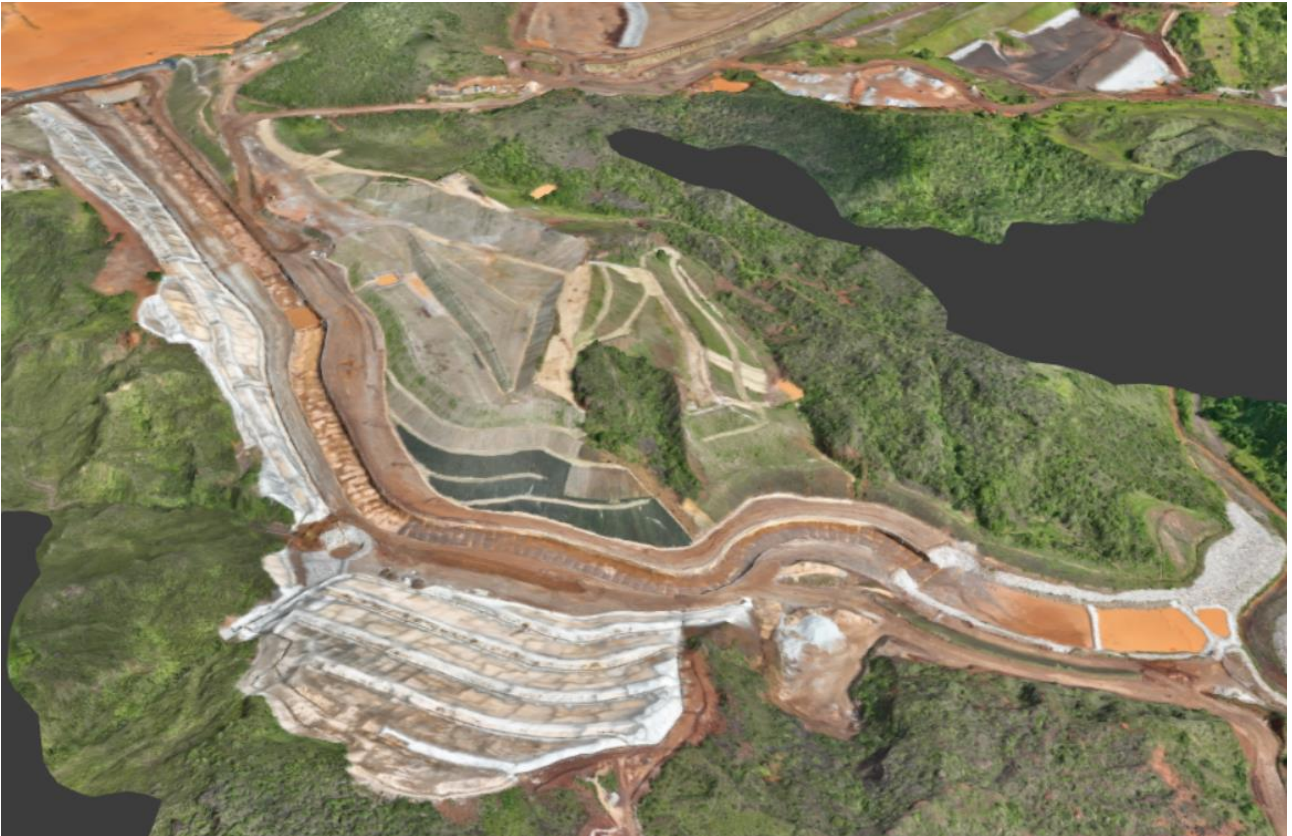
Foto 1. Obras no canal extravasor (11/01/24).
