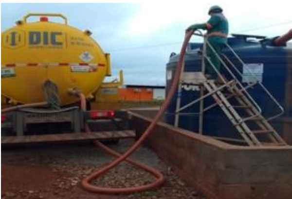
Foto 26 e Foto 27. Limpeza de tanque séptico (dezembro/2023).
