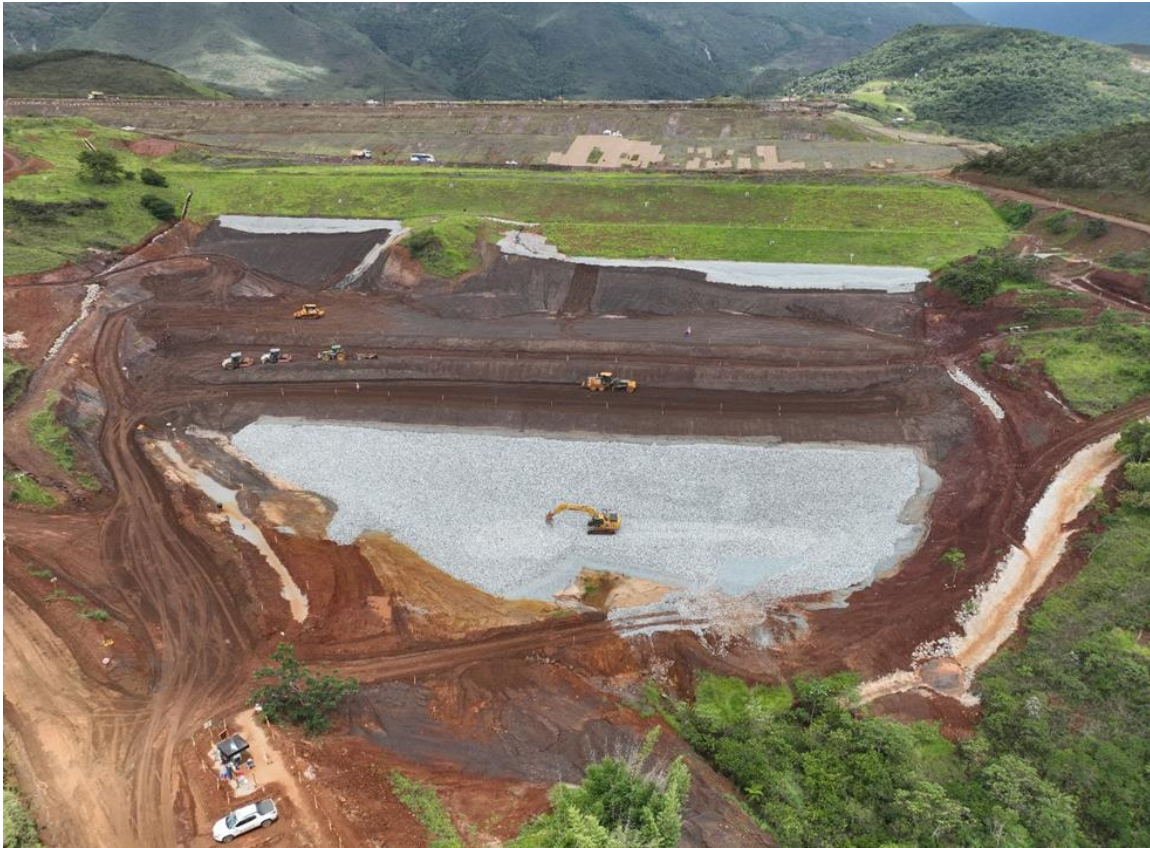
Foto 4. Tratamento de fundação do Dique 1 (Imagem de 11/01/24).
