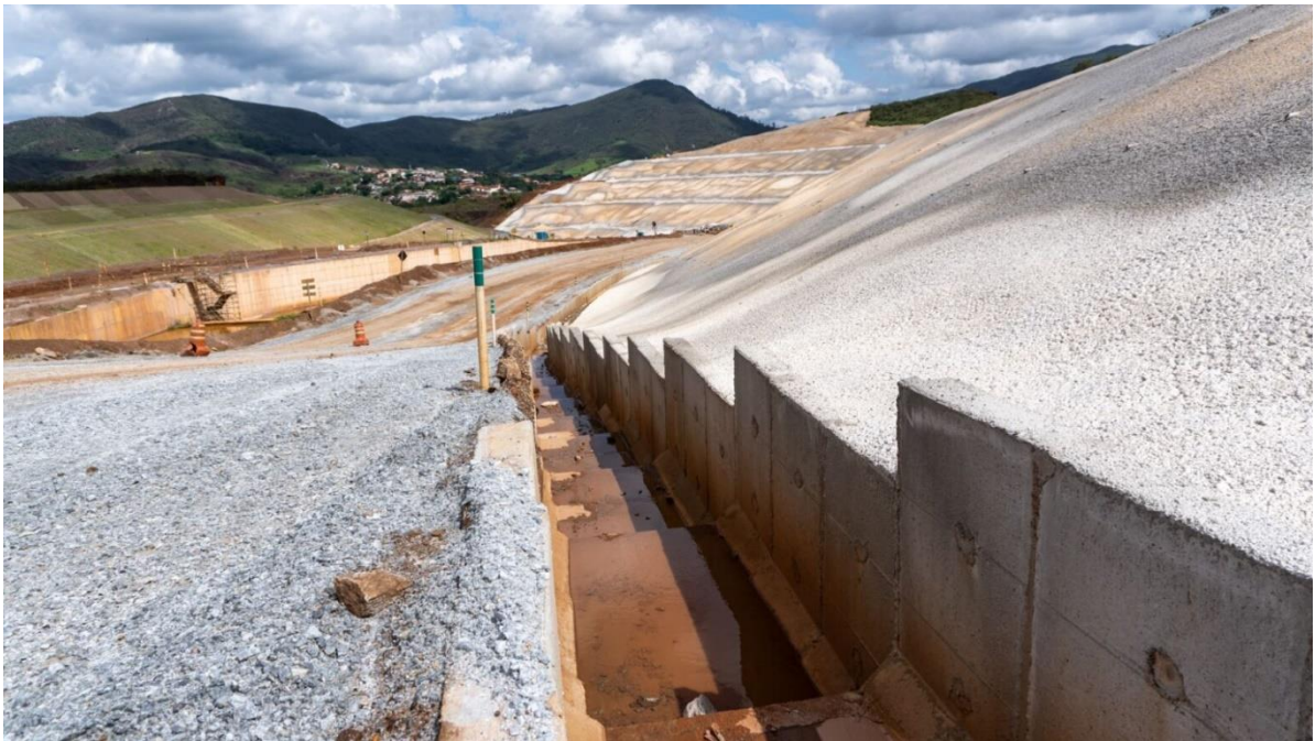
Foto 7. Recuperação de taludes (Concluída) foto dia 13/12/23.
