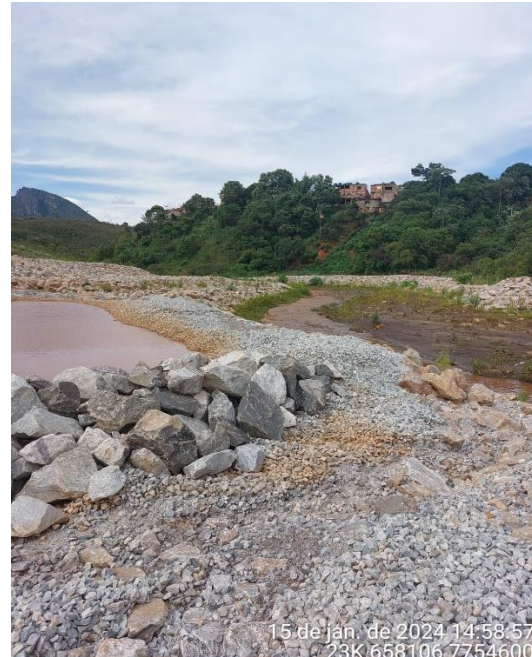
Foto 14 e Foto 15. Bacia de Contenção à jusante do extravasor.
