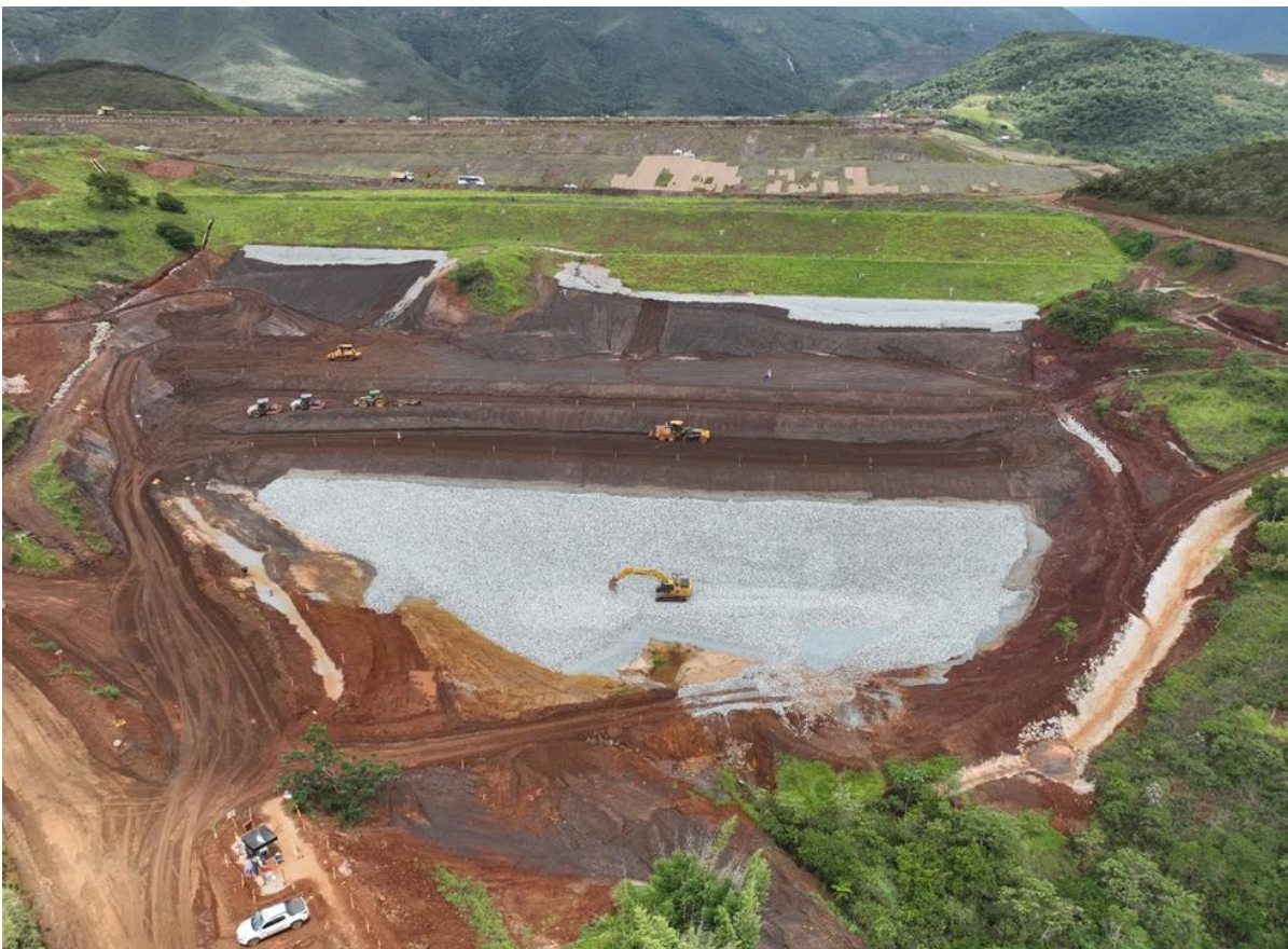
Foto 8. Tratamento da fundação do Dique 1 – foto dia 11/01/24 (Concluído).
