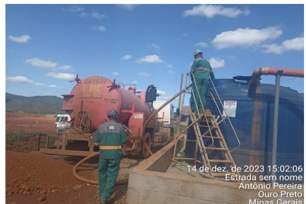
Foto 26 e Foto 27. Limpeza de tanque séptico (dezembro/2023).
