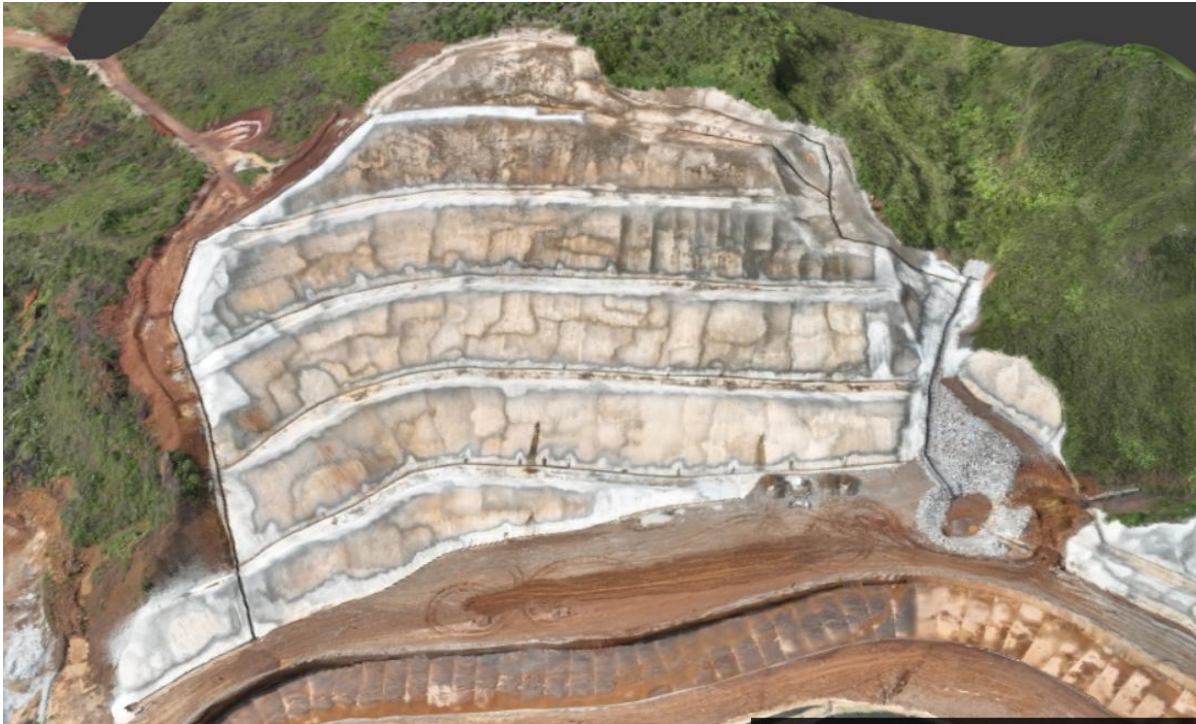
Foto 2. Situação atual das obras do Talude 3 (Foto 11/01/24).
