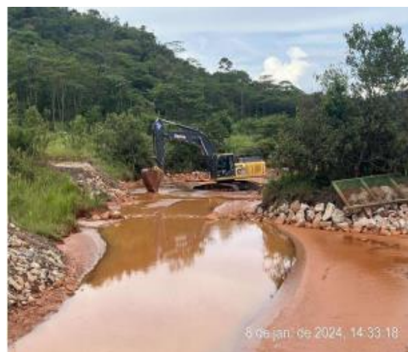
Foto 12 e Foto 13. Implantação da canaleta de drenagem no acesso e limpeza do sump a jusante do maciço principal
