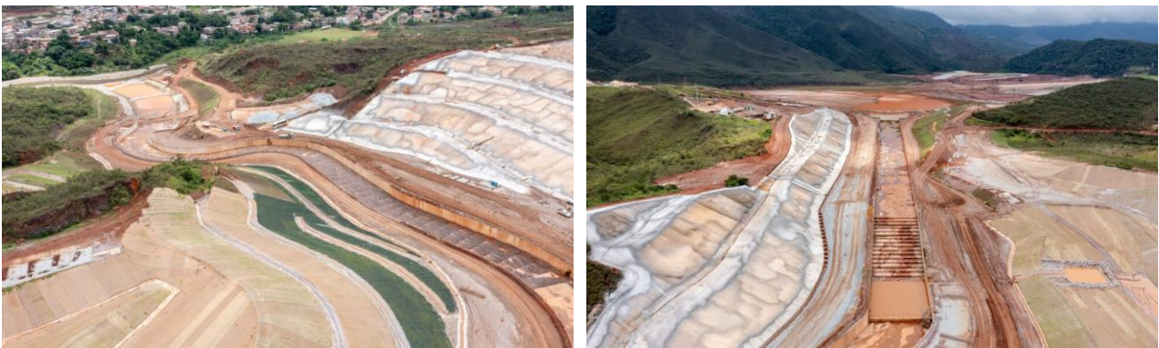
Foto 16 e Foto 17. Técnicas de hidrossemeadura e biomanta aplicadas nos taludes da margem esquerda do extravasor e concreto projetado na margem direita. (janeiro/2024).
