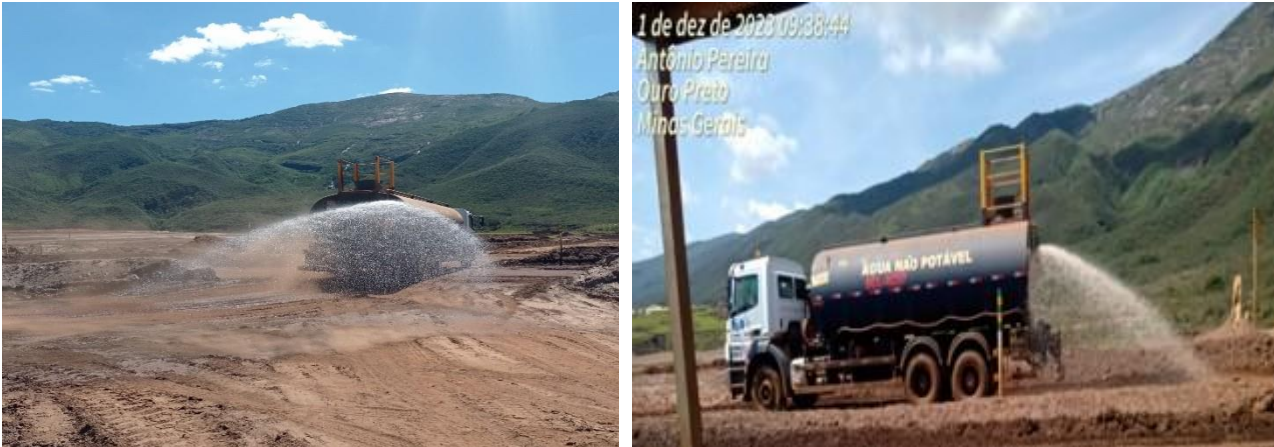
Foto 20 e Foto 21. Atividades de umectação das vias de acesso.
