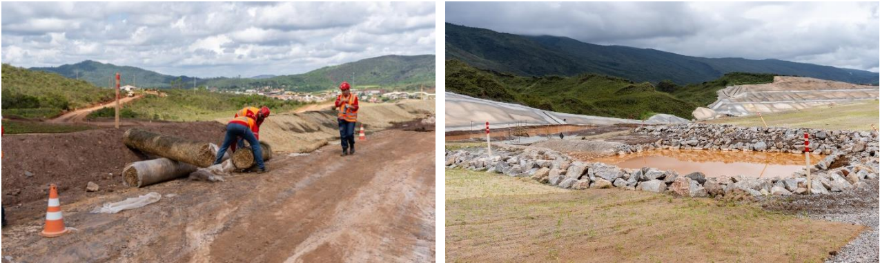
Foto 18 e Foto 19. Combinação das técnicas hidrossemeadura e biomanta para recuperação e proteção do solo em Doutor.
