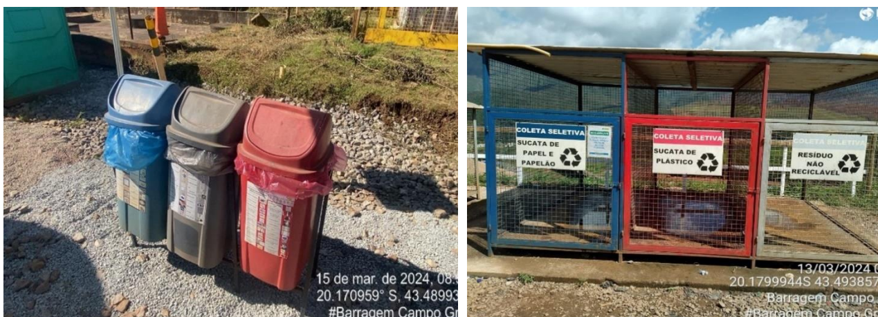
Foto 39 e Foto 40. Coleta de resíduos sólidos nas frentes de serviço e DIR (Depósito Intermediário de Resíduos).
