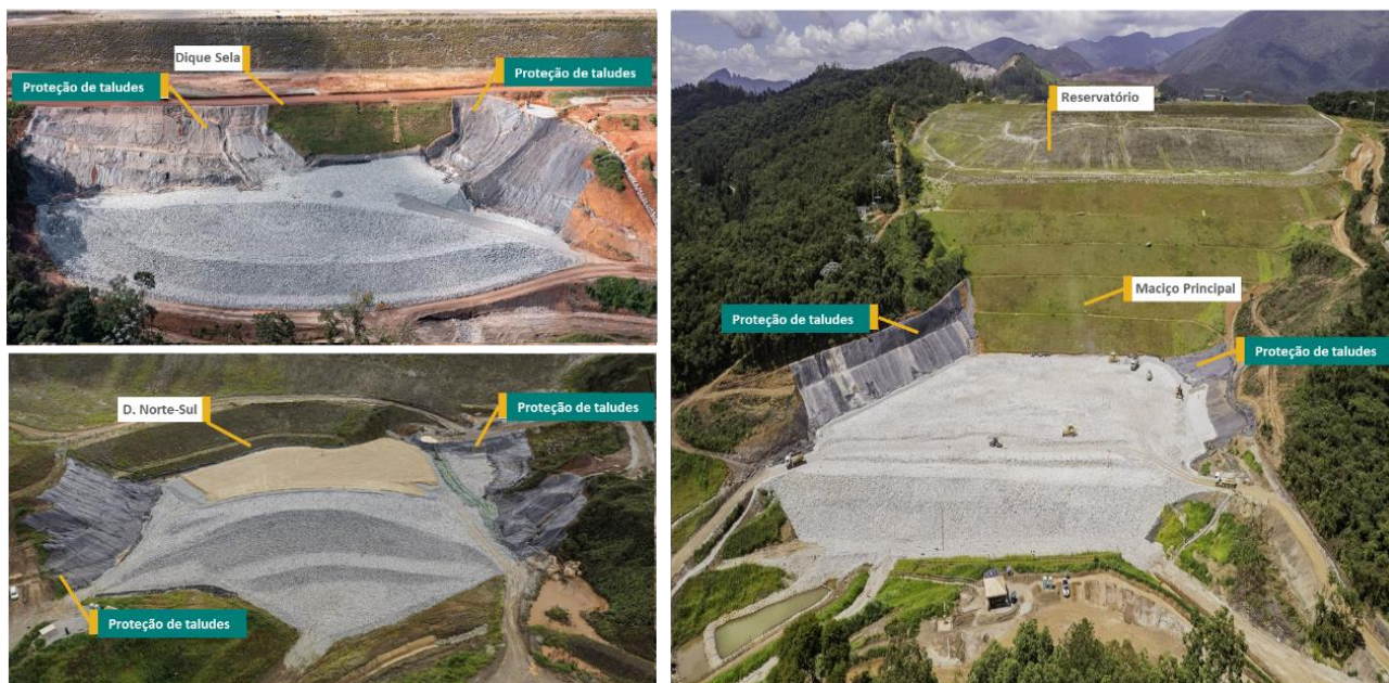
Figura 2: Plano de chuva executado no Maciço Principal, Dique de Sela e Dique Norte Sul.
