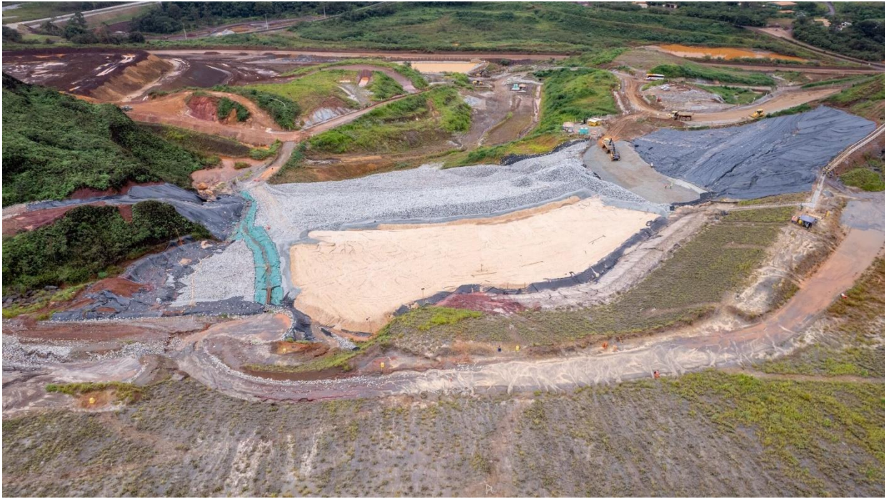
Foto 9. Obras no Dique Norte-Sul – transição de agregados.
