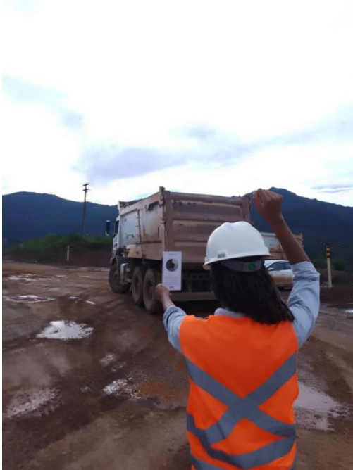
Foto 35 e Foto 36: ilustra o controle das emissões provenientes dos escapamentos dos equipamentos movidos a diesel em operação nas obras da barragem Campo Grande. Fonte: Vale, 2024.
