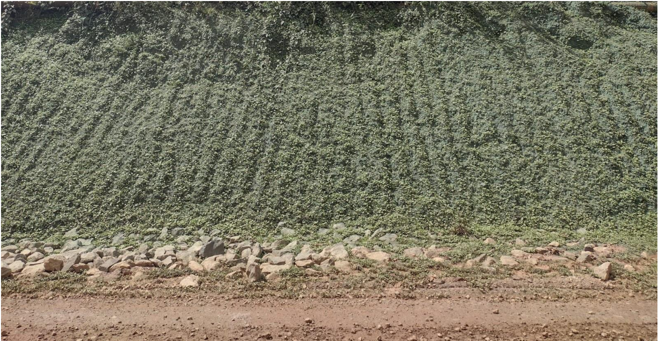
Foto 31: Foto demonstrando a germinação da vegetação no talude após aplicação de hidrossemeadura. Fonte: Vale, abril de 2024.
