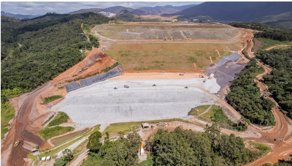
Foto 6. Obras no Maciço Principal.
