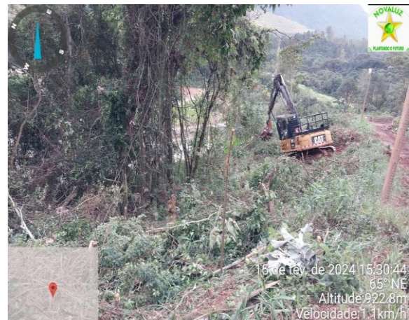
Foto 25. Supressão Maciço Principal indicando supressão na ombreira esquerda. Fonte: Bioma, 2024.
