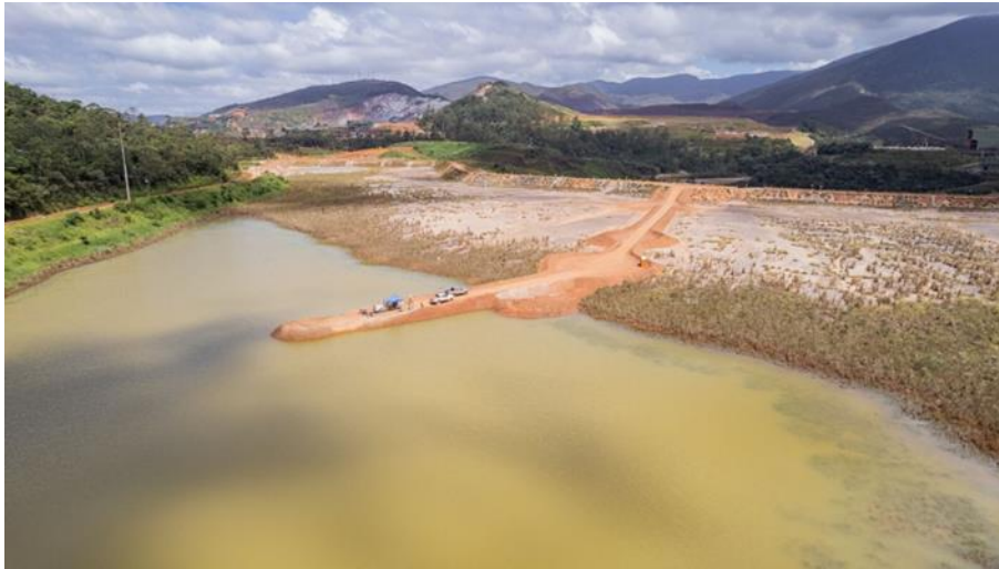
Foto 1: Aterro de conquista para execução dos CPTu's na área do reservatório.
