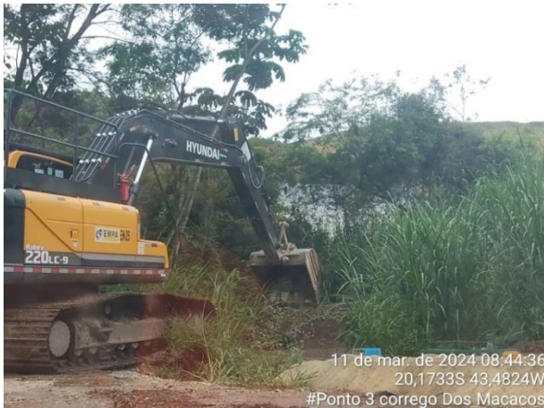
Foto 13. Limpeza Sump's. Fonte: Vale (abril/2024).
