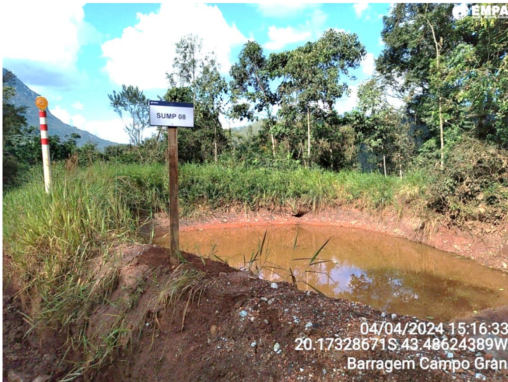
Foto 15. Sump's adequados para uso. Os sump's são posicionados em pontos estratégicos para coletar o escoamento da drenagem pluvial. Isso permite um controle ambiental eficaz, retendo os sedimentos que poderiam alcançar os cursos d'água. Fonte: Vale (abril/2024).
