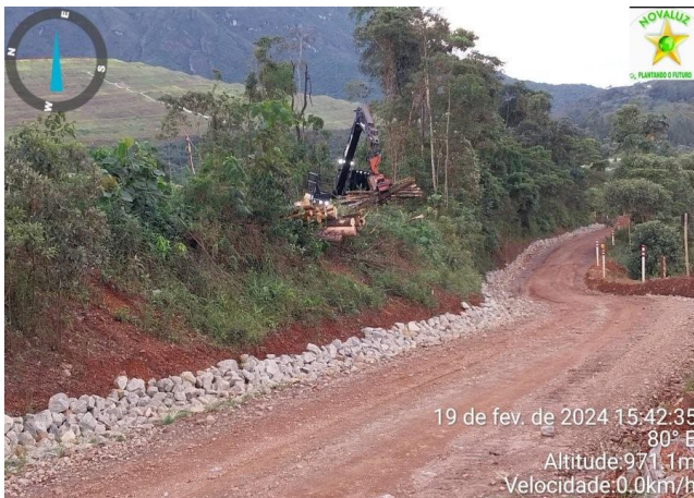
Foto 24. Supressão Maciço Principal indicando supressão da ombreira direita. Fonte: Bioma, 2024.
