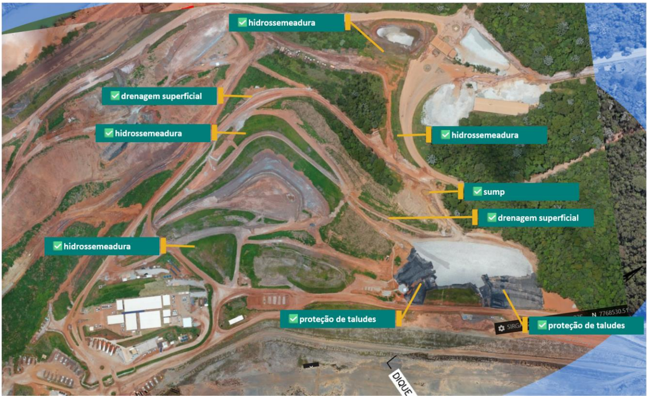
Figura 8: Plano de chuva executado no Dique de Sela e ADME.
