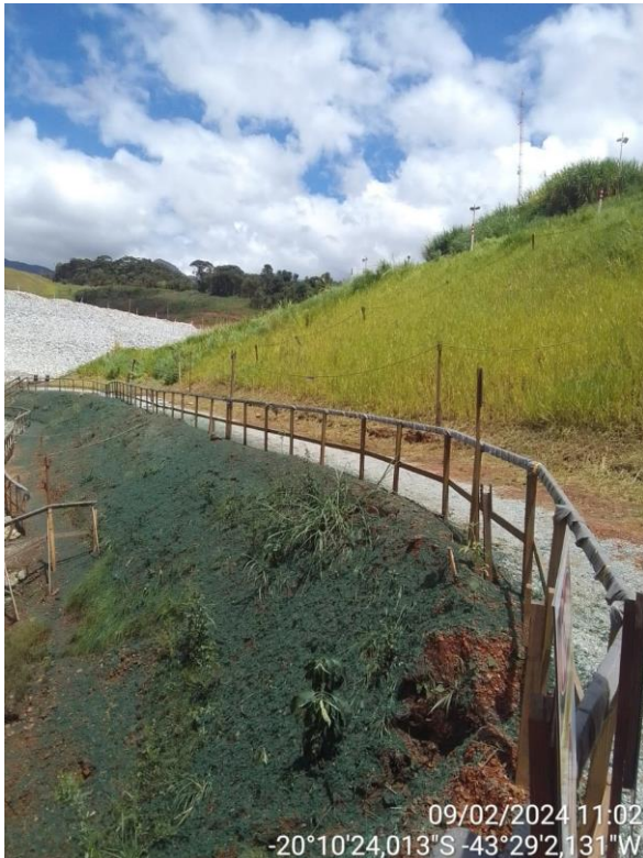
Foto 27 e Foto 28. Antes e depois da revegetação com utilização de hidrossemeadura no talude lateral da trincheira drenante. Fonte: Vale, 2024.
