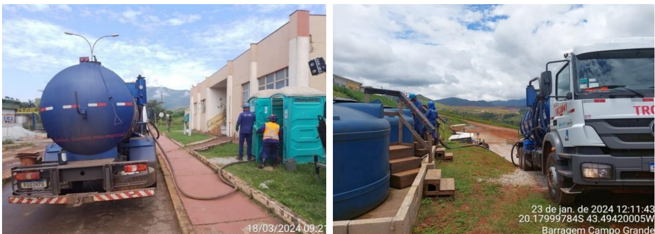
Foto 37 e Foto 38. Limpeza de banheiros químicos e tanque séptico.
