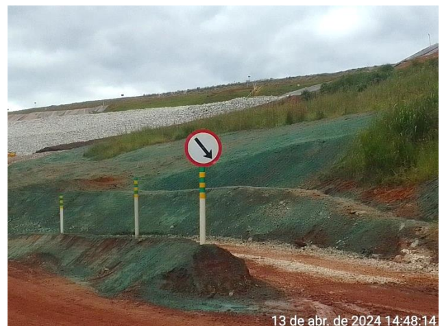
Foto 30. Revegetação com utilização de hidrossemeadura indicando revegetação nos taludes da ADME. Fonte: Vale, 2024
