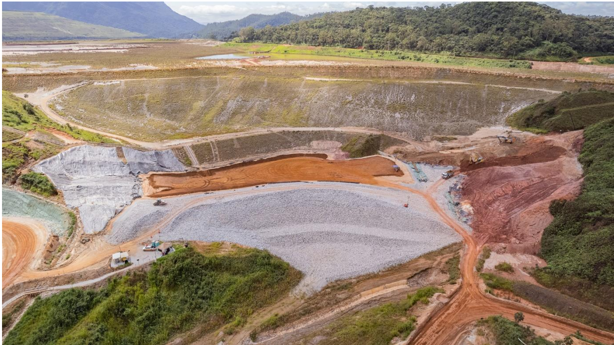
Foto 10. Obras no Dique Norte-Sul – início do aterro em estéril.
