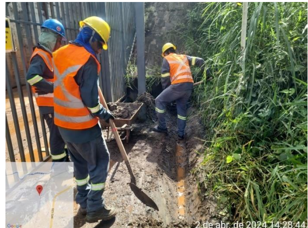
Foto 14. Limpeza Canaletas. Nota-se as medidas adotadas preventivamente objetivando a eficiência do sistema de drenagem. Fonte: Vale (abril/2024).
