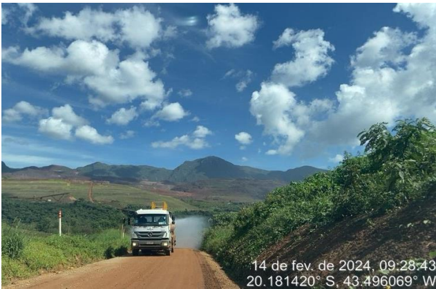
Foto 33 e Foto 34. Umetecação de vias no acesso principal e no pátio de agregado. Fonte: Vale, 2024.
