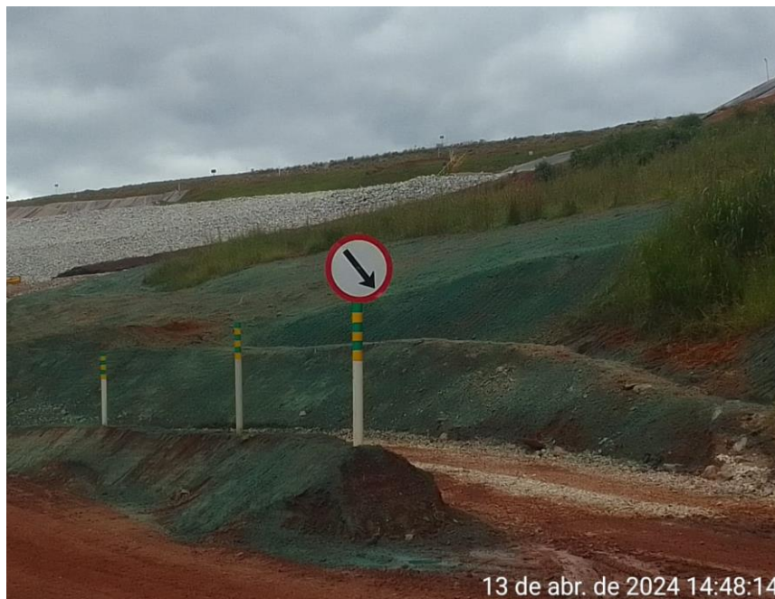
Foto 8. Obras no Dique de Sela – Hidrossemeadura complementar.
