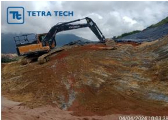
Foto 2 e Foto 3: Liberação de fundação Dique Norte Sul e Maciço Principal, respectivamente.
