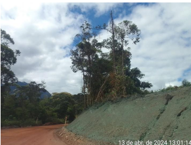
Foto 29. Revegetação com utilização de hidrossemeadura indicando revegetação no acesso. Fonte: Vale, 2024.
