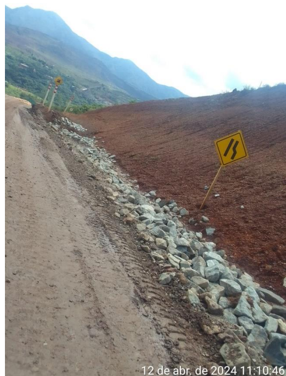
Foto 11 e Foto 12. Drenagem adjacentes ao acesso. Observa-se a disposição de enrocamento ao longo da canaleta para diminuir a velocidade de escoamento da drenagem pluvial. Fonte: Vale (abril/2024).
