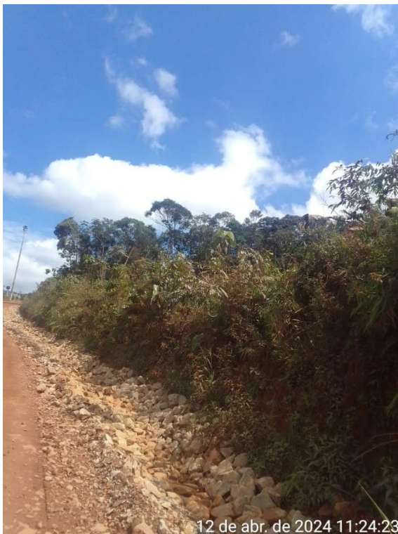
Foto 11 e Foto 12. Drenagem adjacentes ao acesso. Observa-se a disposição de enrocamento ao longo da canaleta para diminuir a velocidade de escoamento da drenagem pluvial. Fonte: Vale (abril/2024).
