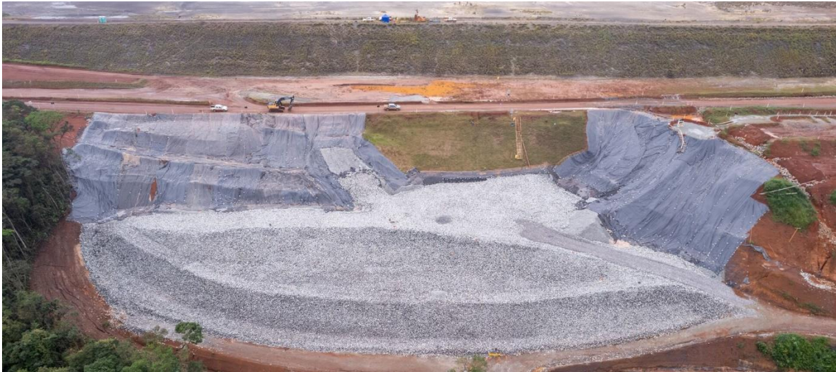
Foto 7. Obras no Dique de Sela e manutenção das proteções para chuva.
