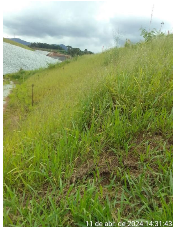
Foto 27 e Foto 28. Antes e depois da revegetação com utilização de hidrossemeadura no talude lateral da trincheira drenante. Fonte: Vale, 2024.
