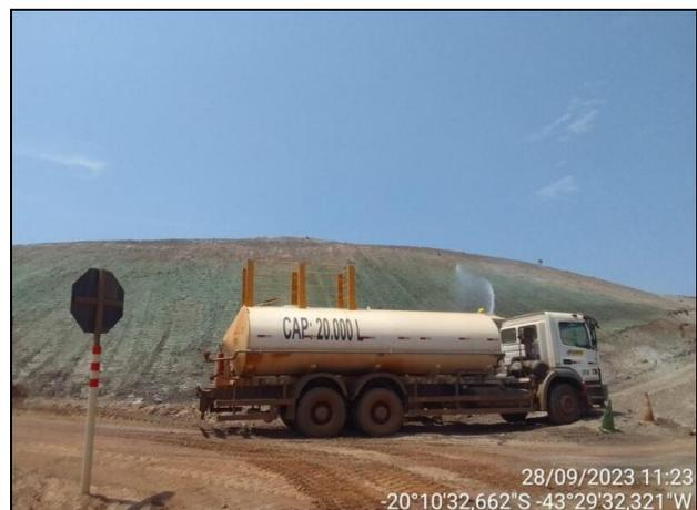
**Foto 27 e Foto 28.** Implementação de projetos de revegetação em taludes e manutenção da revegetação com irrigação.
