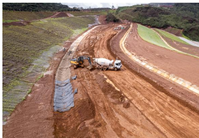
Figura 24 – Concretagem da canaleta do Dique Norte-Sul. Fonte: Vale, 2025.
