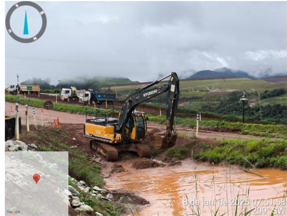
Figura 20 – Desassoreamento do sump carpintaria. Fonte: Vale, 2025.
