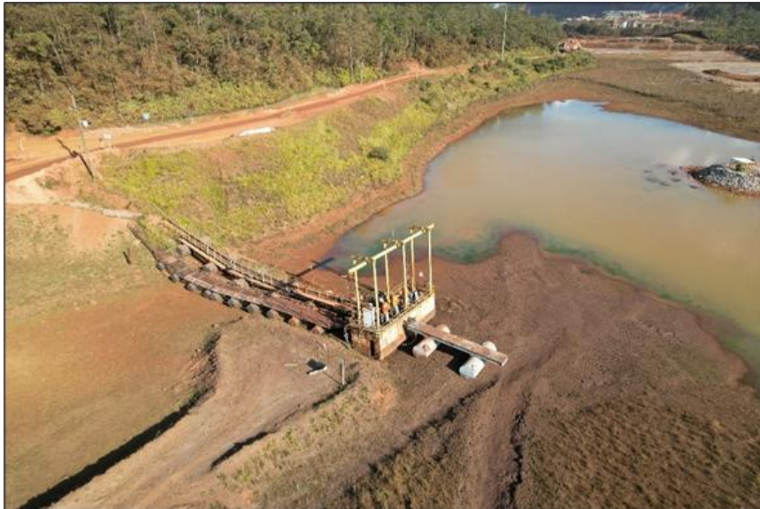
Figura 9 - Sistema de bombeamento da Barragem Campo Grande.
