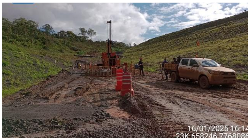
Figura 3 – Sondagens em andamento - campanha complementar canal lateral.
