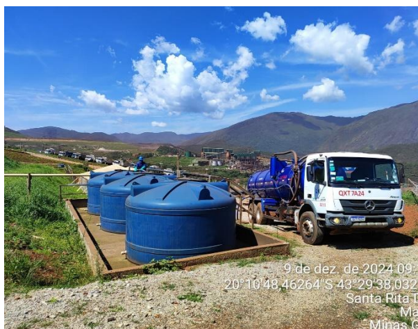
Figura 43 – Sucção de efluente do tanque séptico. Fonte: Vale, 2025.
