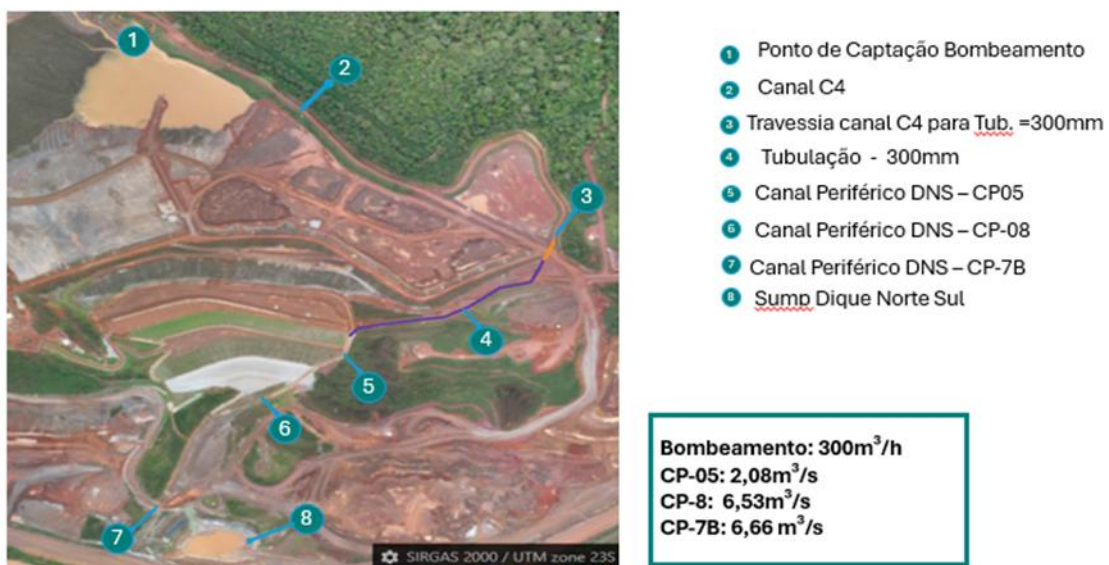
Figura 10 – Sistema de bombeamento e canal periférico C4.
