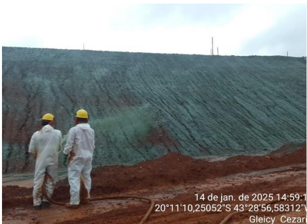
Figura 31 - Aplicação da grama líquida. Fonte: Vale, 2025.
