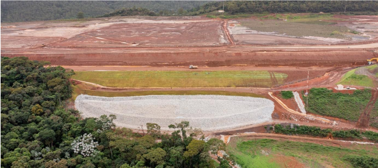
Figura 12 - Obras no Dique de Sela – reforço em estéril e revegetação dos taludes (dezembro/2024).
