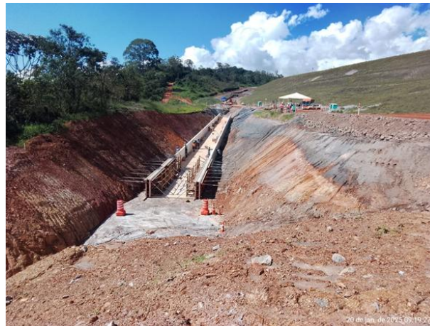
Figura 22 – Execução do canal lateral da ombreira direita da barragem. Fonte: Vale, 2025.
