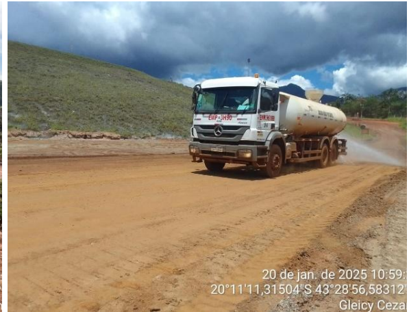
Figura 34 - Umectação de vias para o canal lateral. Fonte: Vale, 2025.
