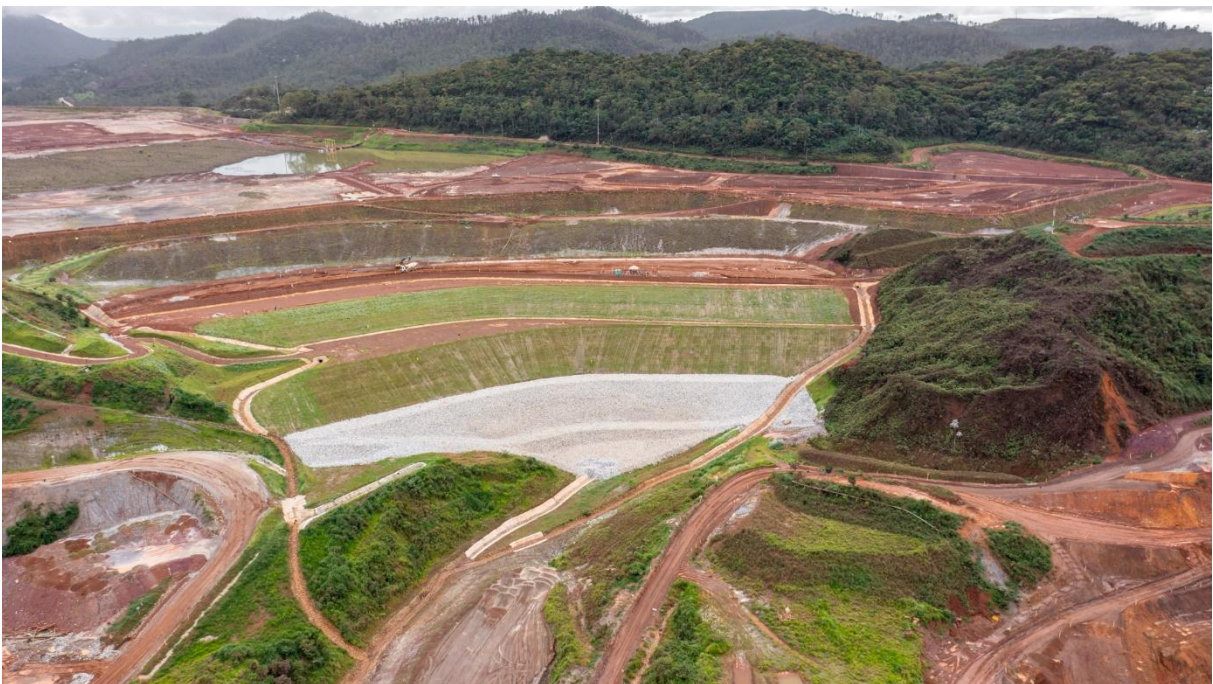
Figura 13 - Obras no Dique Norte-Sul – revegetação nos taludes do reforço para proteção (dezembro/2024).
