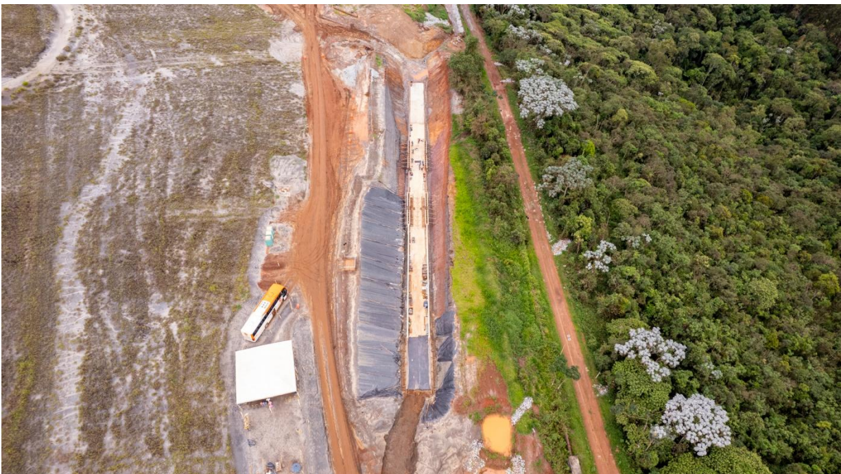
Figura 15 - Obras no Extravasor – concretagem do canal do extravasor (dezembro/2024).
