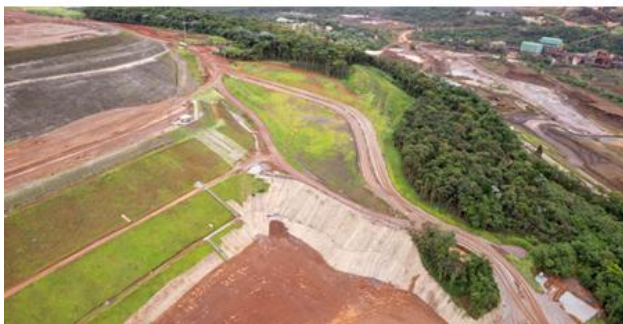
Figura 29 e Figura 30 – Hidrossemeadura e biomanta na ombreira esquerda do maciço principal e taludes de reforço do Dique Norte e Sul. Fonte: Vale, 2025.
