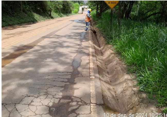
Figura 25 – Limpeza de canaleta do acesso principal. Fonte: Vale, 2025.
