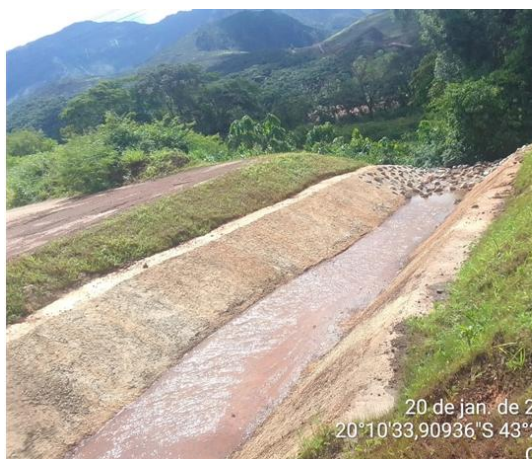
Figura 23 – Aspecto geral da canaleta do extravasor do Dique de Sela Fonte: Vale, 2025.
