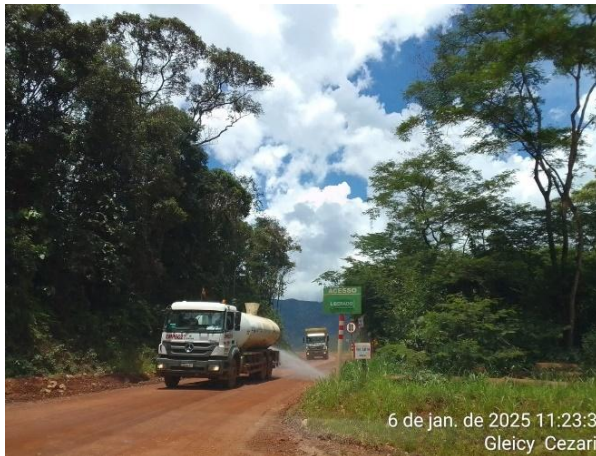
Figura 35 - Umectação de vias próximo ao dique de sela. Fonte: Vale, 2025.
