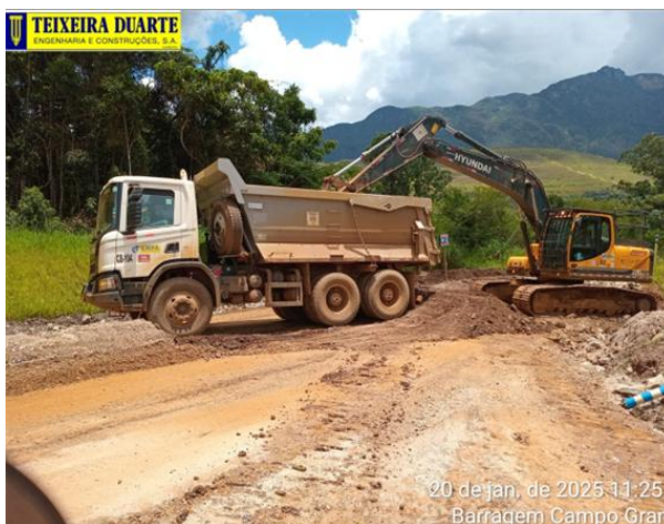
Figura 17 - Desassoreamento do sump 08. Fonte: Vale, 2025.
