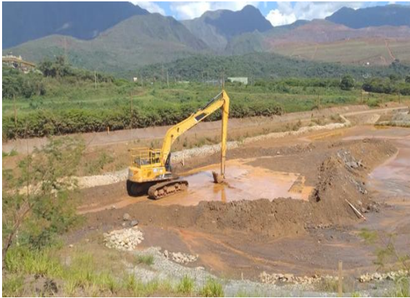
Figura 19 - Desassoreamento do Sump Dique Norte Sul. Fonte: Vale, 2025
