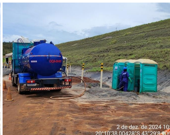
Figura 44 – Limpeza de banheiro químico. Fonte: Vale, 2025
