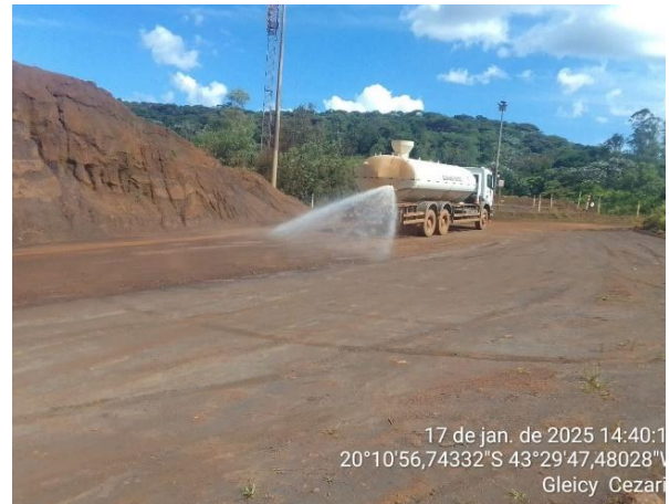
Figura 36 - Umectação de vias no Pátio de agregados. Fonte: Vale, 2025.
