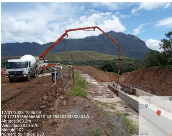
Figura 21 - Concretagem do canal lateral da ombreira direita da barragem. Fonte: Vale, 2025.
