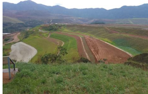
Figura 29 e Figura 30 – Hidrossemeadura e biomanta na ombreira esquerda do maciço principal e taludes de reforço do Dique Norte e Sul. Fonte: Vale, 2025.
