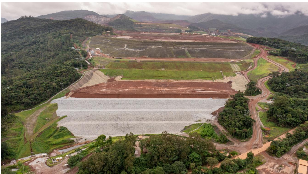
Figura 11 - Obras no Maciço Principal – reforço em estéril (dezembro/2024).
