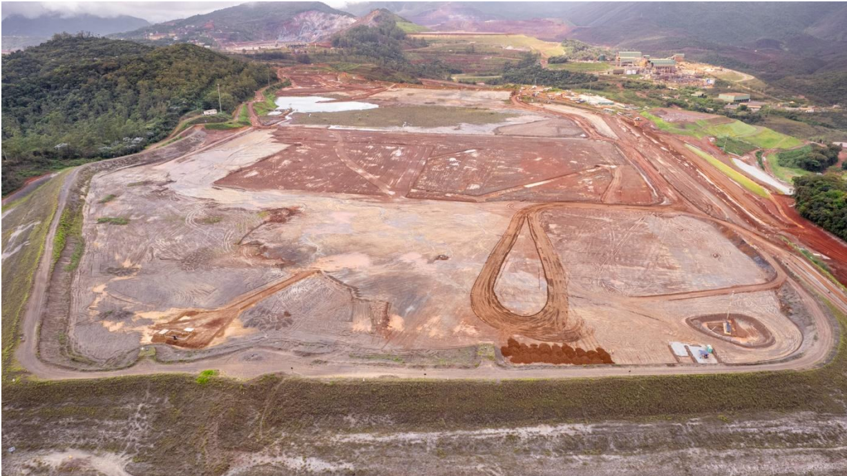
Figura 14 - Obras no Regreide Trecho 3 – escavação e aterro para nivelamento da estrutura (dezembro/2024).
