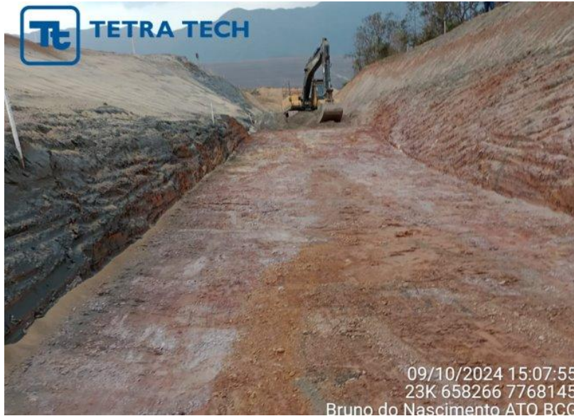
Figura 6 - Liberação de fundação do canal lateral
