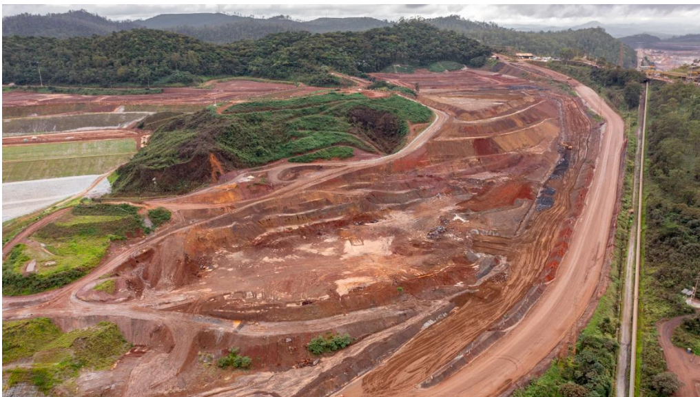
Figura 7 - Lançamento de estéril no Bota Espera-Sul.
