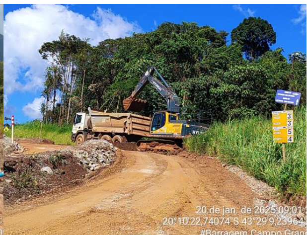
Figura 18 – Desassoreamento do sump do maciço. Fonte: Vale, 2024.
