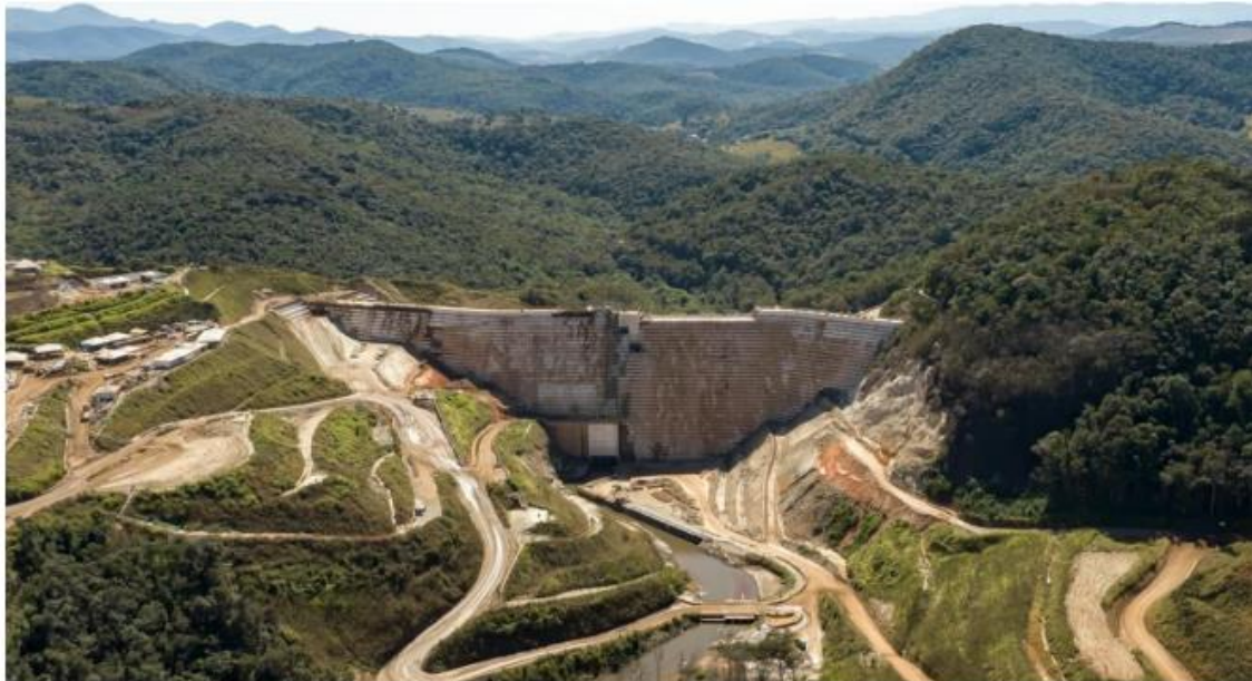
Foto 33. Estrutura de Contenção a Jusante Fábrica. Fonte: Vale, 2022.
