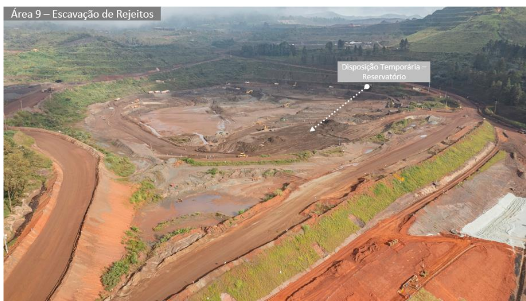
Figura 13. Localização disposição temporária dos rejeitos escavados no reservatório.
