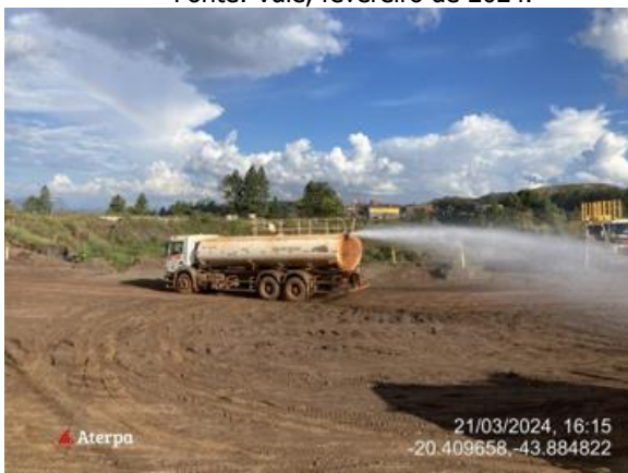
Foto 14. Aspersão de água nas vias, Fonte: Vale, março de 2024.
