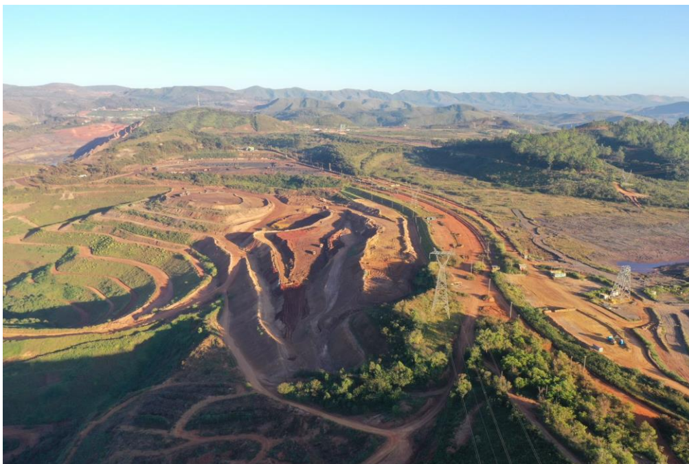
Figura 15. PDE.3 – Disposição do material de escavação da fundação do reforço.
