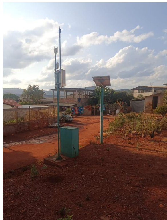
Foto 5. Estação de Monitoramento de Ruído de Mota. Vale, 2023.
