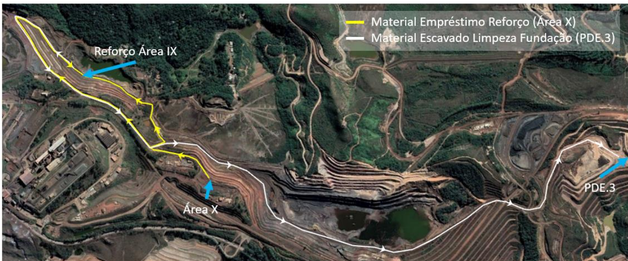
Figura 10. Movimentação de Terra - Etapa 1.
