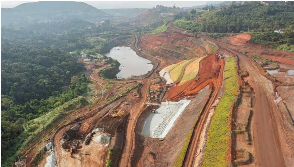
Foto 2. Execução Tapete Drenante ombreira esquerda est. 12 – Abril/2024.
