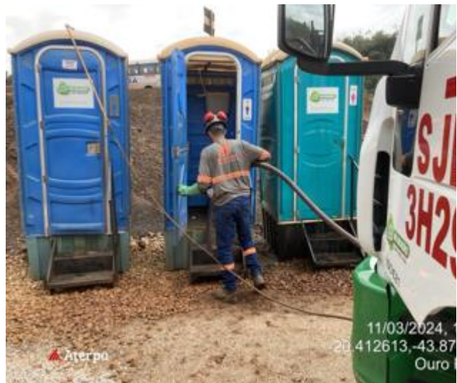
Foto 22. Higienização de banheiros hidráulicos (Fonte: Vale, 2024).
