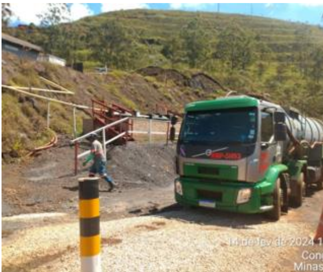
Foto 21. Sucção de efluente sanitário dos tanques sépticos (Fonte: Vale, 2024).
