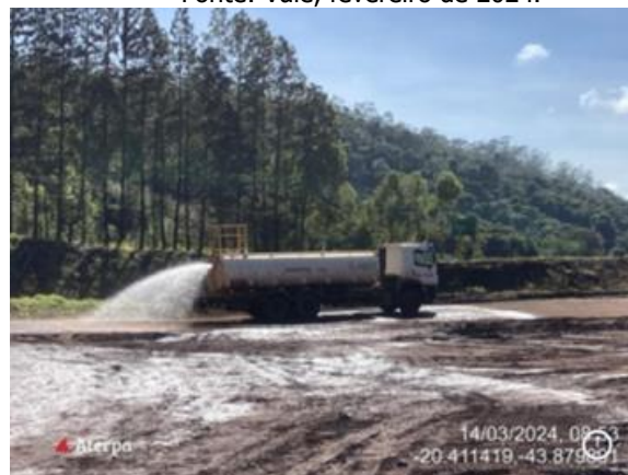
Foto 15. Aspersão de água nos acessos de obra. Fonte: Vale, março de 2024.
