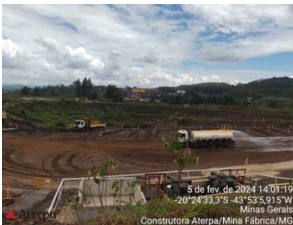
Foto 12. Caminhão pipa realizando aspersão das vias. Fonte: Vale, fevereiro de 2024.
