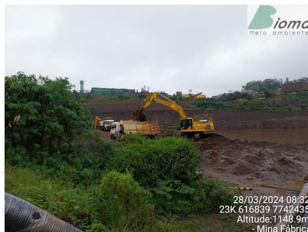
Foto 7. Máquina realizando retirada de top soil.
