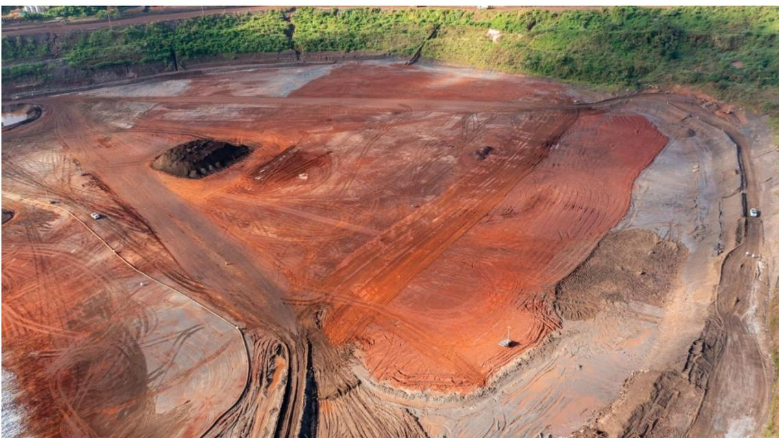
**Figura 17 – Remoção do rejeito dos depósitos temporários para Cava 5 e aplicação de argila no reservatório (janeiro/25).**
