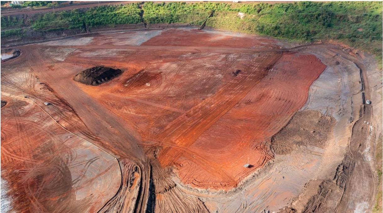
**Figura 41 – Remoção do rejeito do bota espera para Cava 5 e recobrimento do reservatório com argila (Janeiro/25).**
