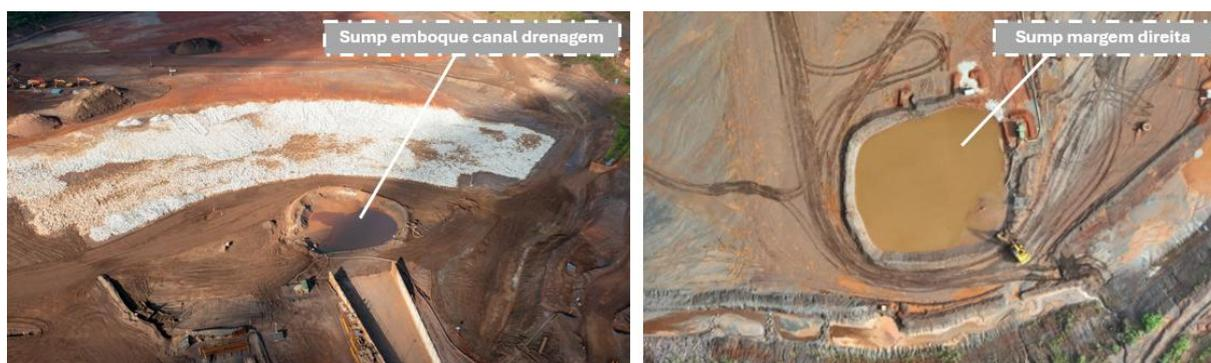
**Figura 3 - Sumps com bombeamento em operação (janeiro/25)**
