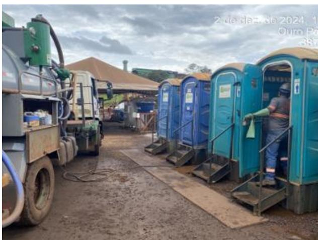
**Figura 118 - Sucção de efluente sanitário armazenado nos tanques sépticos (Fonte: VALE, 2024)**
