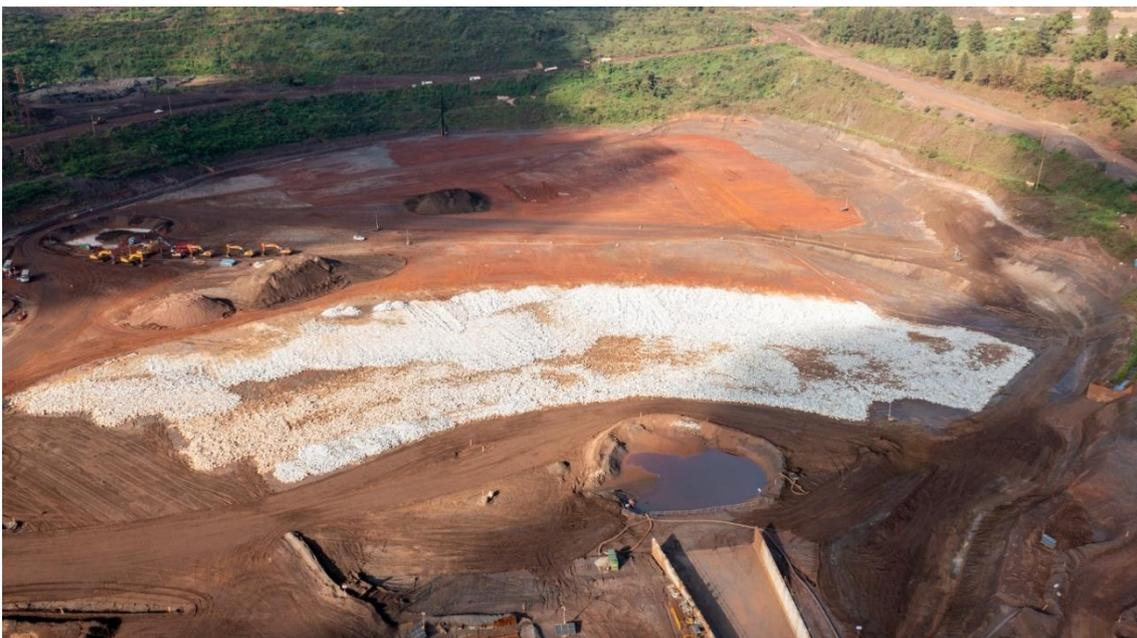
**Figura 5 - Execução do cinturão de enrocamento (janeiro/25)**
