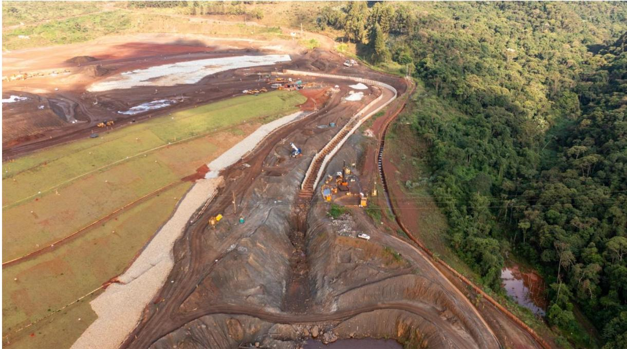
**Figura 42 - Construção do canal extravasor (janeiro/25).**
