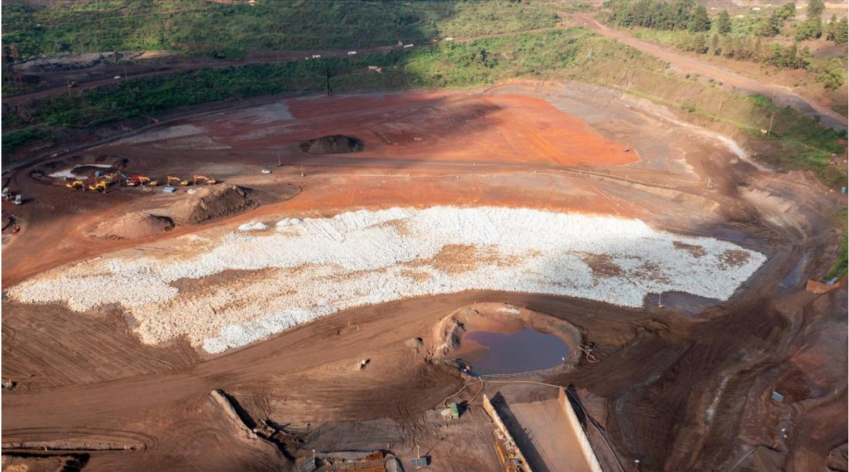
**Figura 40 - Construção do cinturão de enrocamento (janeiro/25).**
