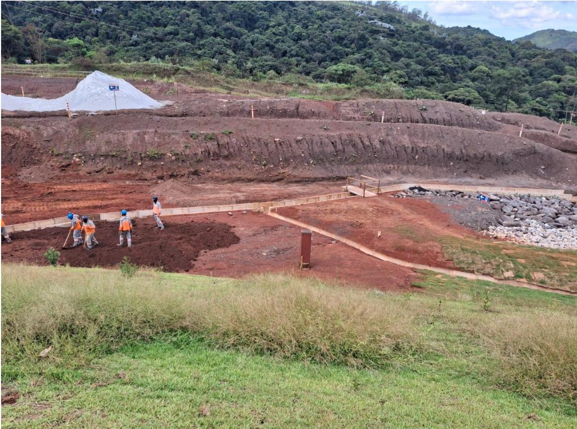
**Figura 36 - Sequência da construção das drenagens superficiais (Janeiro/25)**
