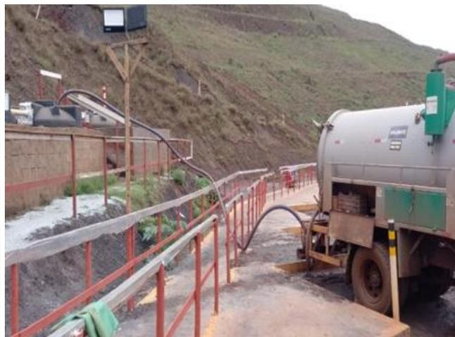
**Figura 114 – Recolhimento de efluentes dos tanques sépticos (Fonte: Vale, 2024)**
