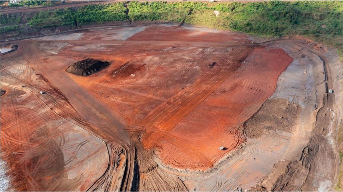
**Figura 6 - Cobertura superficial do reservatório com argila em andamento (janeiro/25).**
