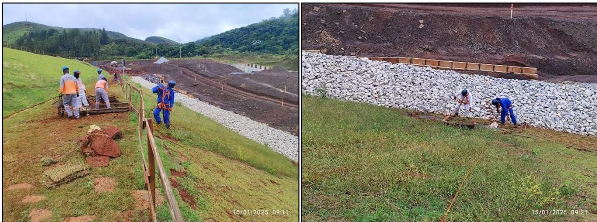
**Figura 66 - Manutenção da grama no talude de jusante da obra do reforço de Área IX (janeiro/25). Vale, 2025.**
