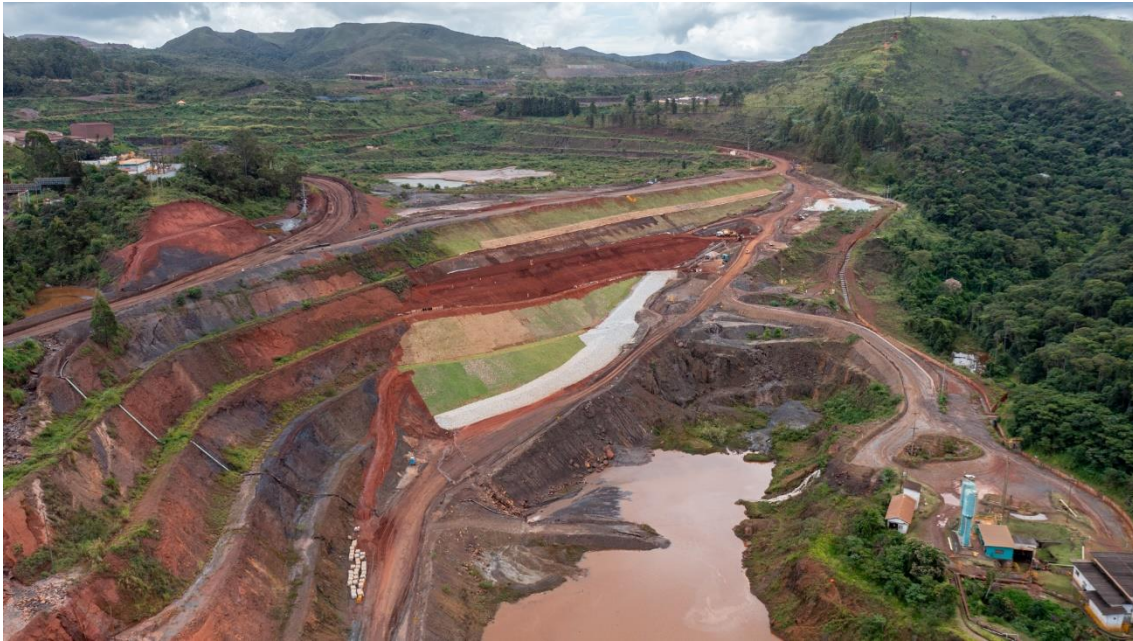
Foto 3. Limpeza de fundação Janeiro –2024.
