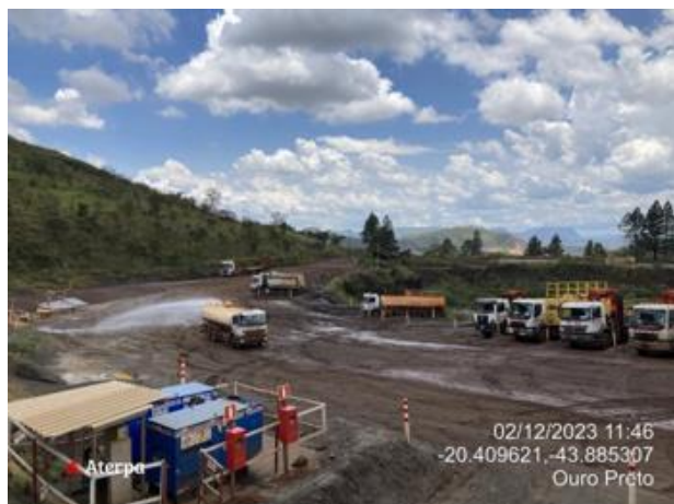
Foto 8. Aspersão de água nos acessos de obra. Fonte: Vale, 2023.
