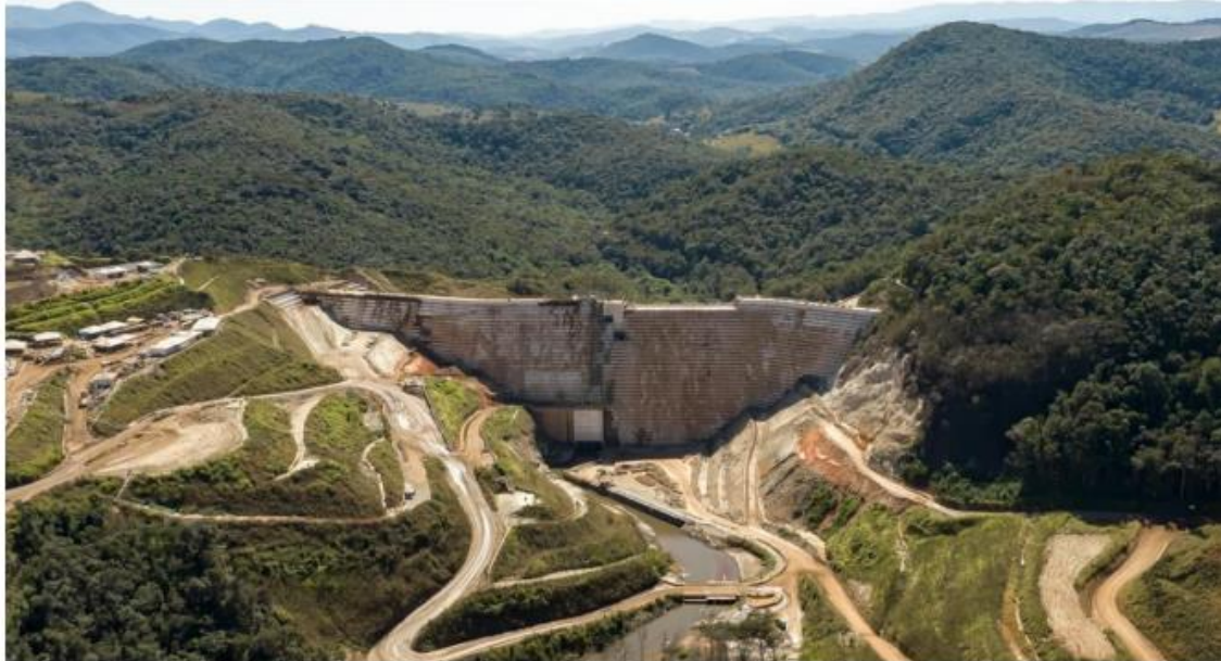
Foto 26. Estrutura de Contenção a Jusante Fábrica. Fonte: Vale, 2022.
