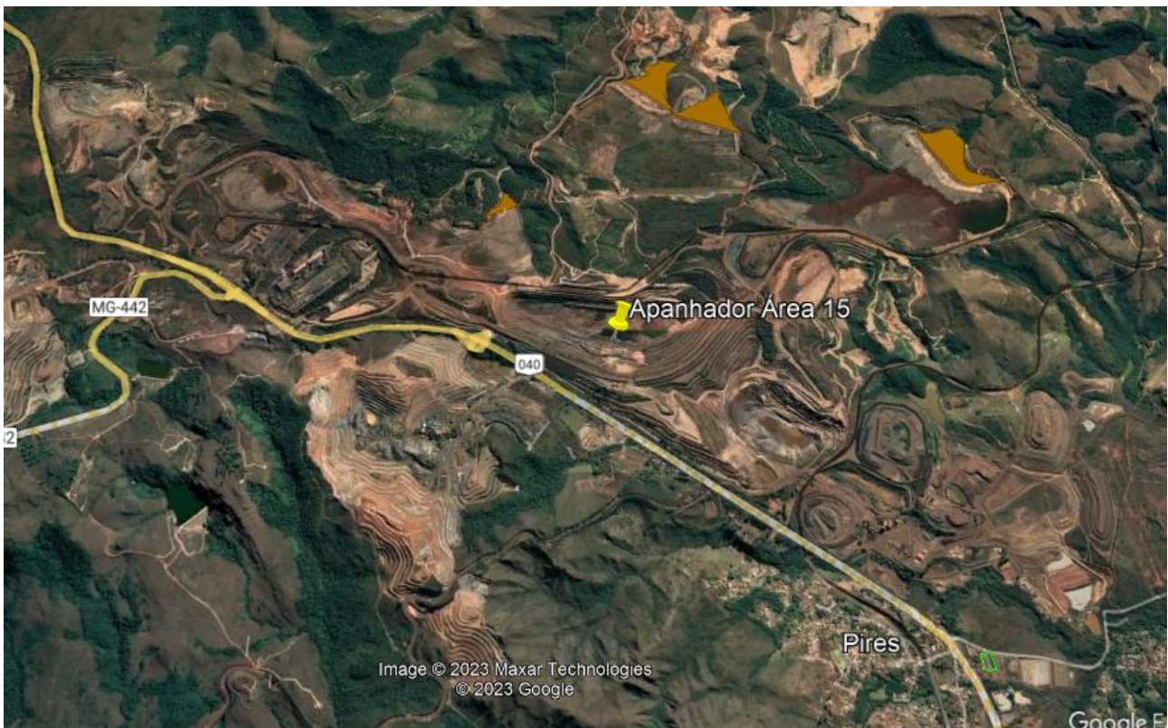
Figura 11. Localização do apanhador de água para aspersão - Área 15.
