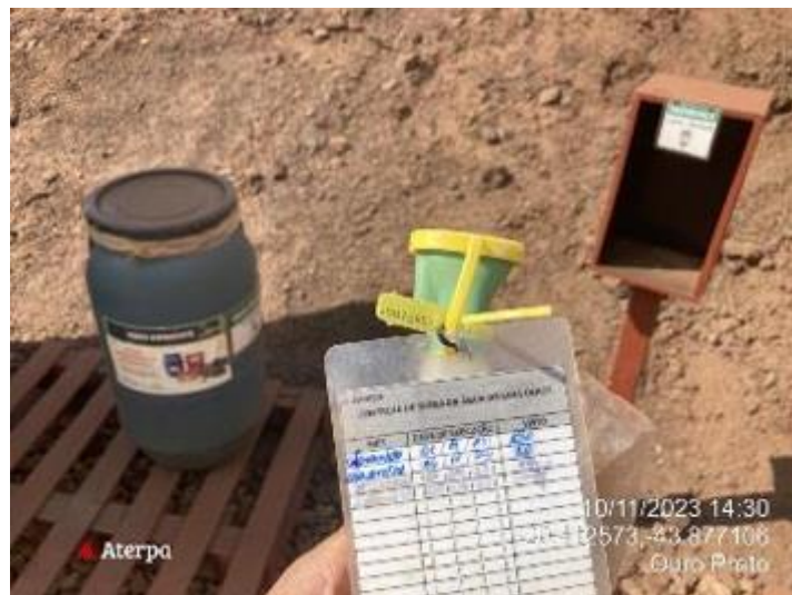
Foto 21. Inspeção e troca de água do lava olhos da frente de serviço. Fonte: Vale, 2023)
