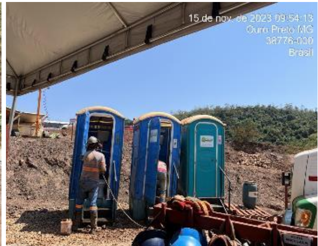
Foto 15. Higienização de banheiros hidráulicos. (Fonte: Vale, 2023).
