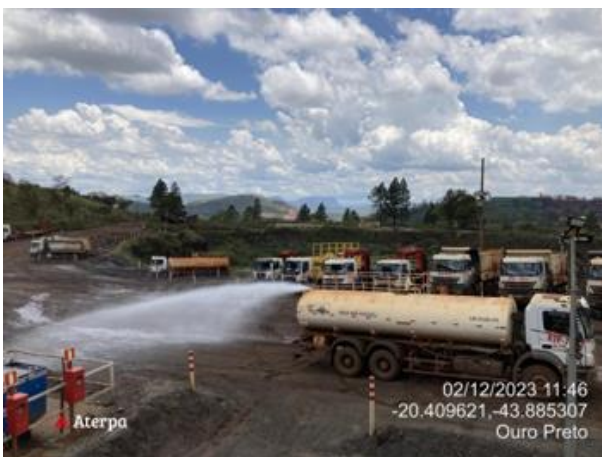
Foto 7. Captação de água para atividades de aspersão das vias, Fonte: Vale, 2023.
