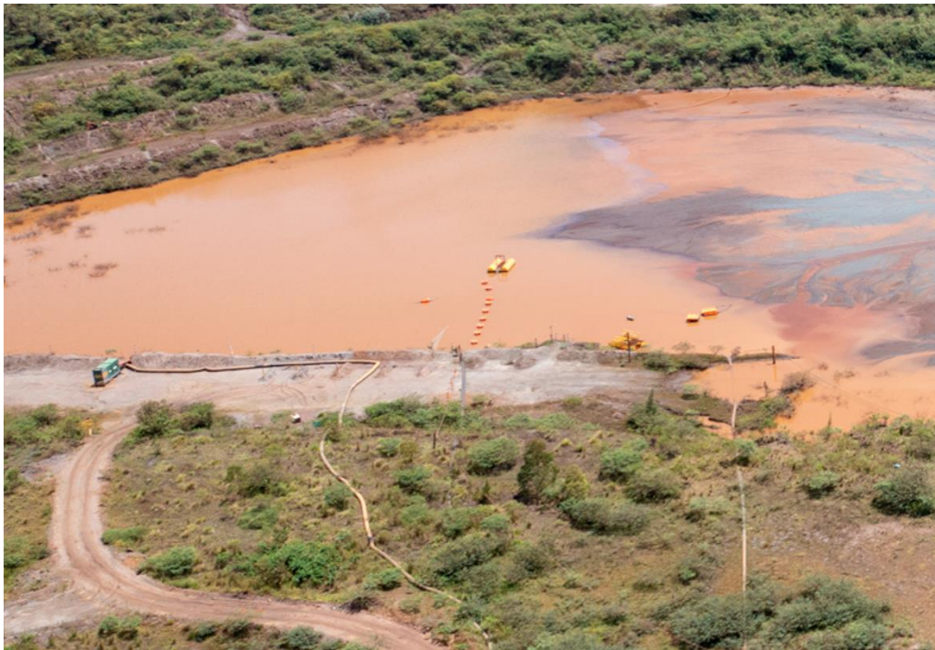
Foto 4. Bombeamento instalado no reservatório de Área IX.
