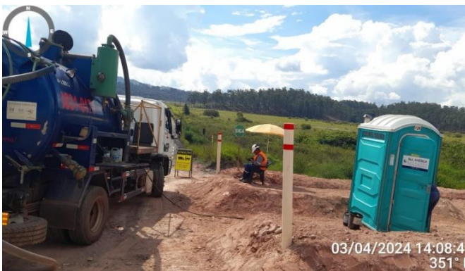
Foto 57. Execução de limpeza e higienização de banheiros químicos nos canteiros de obras e frentes de serviço. Fonte: Vale, 2024
