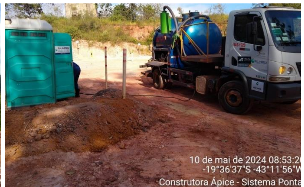
Foto 58. Execução de limpeza e higienização de banheiros químicos nos canteiros de obras e frentes de serviço. Fonte: Vale, 2024.
