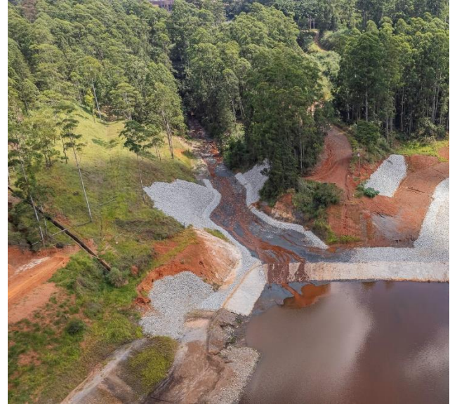
Foto 5. Estruturas de drenagens do Sump Minervino. Visão aérea, via drone. Fonte: Vale, 2024.
