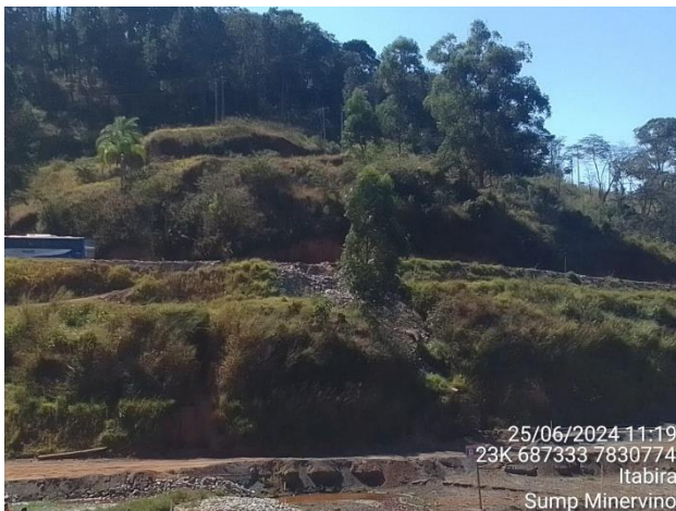
Foto 10. Desenvolvimento da Aplicação de hidrossemeadura com biomanta em taludes como medida de contenção de processos erosivos – Sump Dique Minervino. (VALE, 2024).
