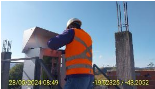
Foto 20. Equipamento no QAR-06. Monitoramento da qualidade do ar em 27/02/2024. Fonte: Vale, 2024.
