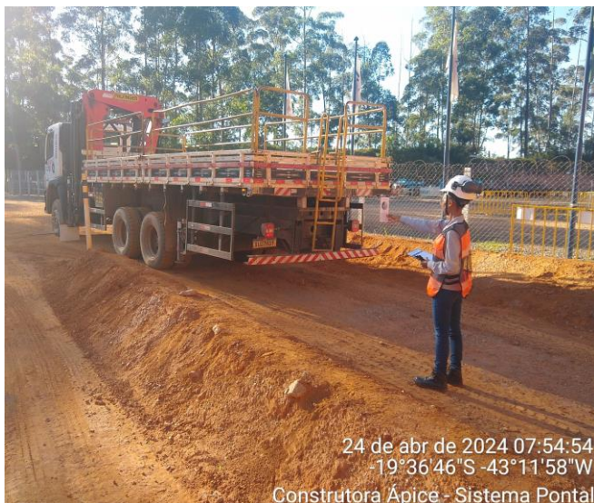
Foto 16. Controle de Emissões Proveniente de Escapamento de Equipamentos Movidos a Diesel.
