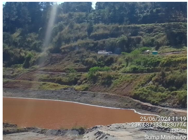
Foto 11. Desenvolvimento da Aplicação de hidrossemeadura com biomanta em taludes como medida de contenção de processos erosivos – Sump Dique Minervino. (VALE, 2024).
