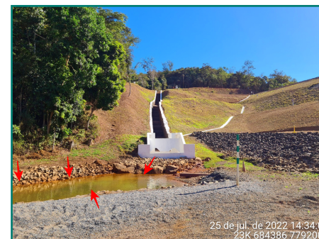
Espelho d'água presente na Área de Intervenção Ambiental, indicadas pelas setas em vermelho.
