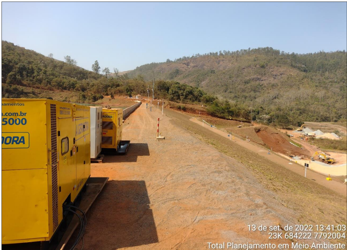
Figura 16. Vista da barragem Porteira, sentido oeste-leste.
