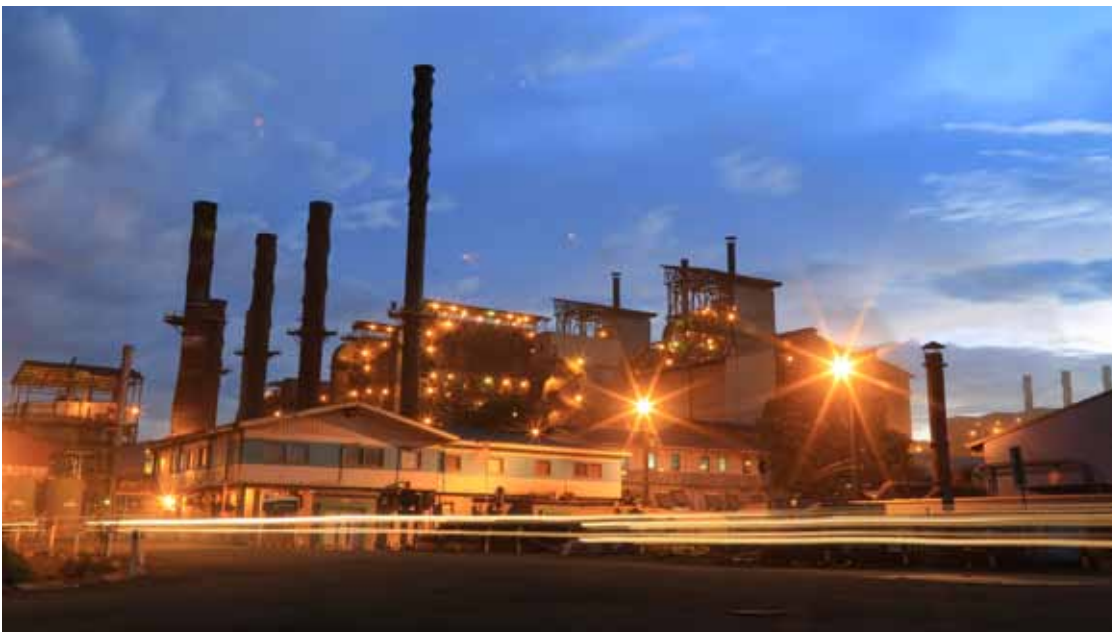
◀ Sorowako Pabrik Pengolahan Process Plant
