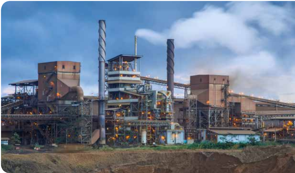
Pabrik Pengolahan kami di Sorowako Our Processing Plant in Sorowako
