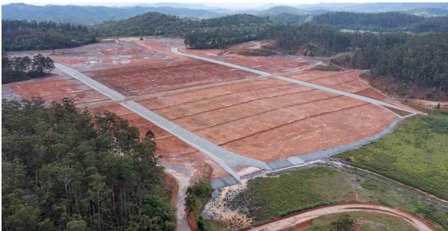
Figura 2 – Vista de Montante para jusante. Data de corte: outubro/2022.
