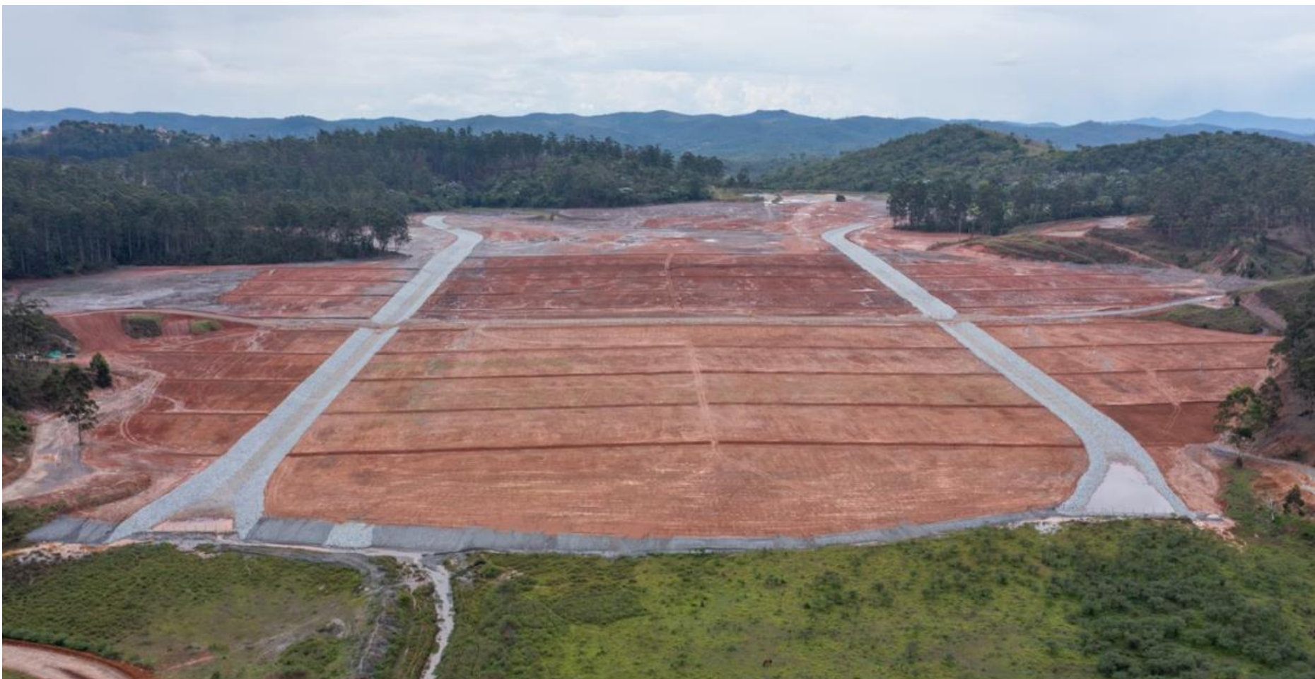
Figura 3 – Vista de Jusante para montante. Data de corte: outubro/2022.
