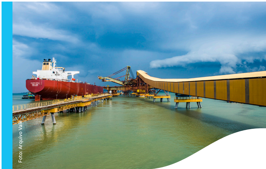
Pier 2 de embarque de minério e pelotas. Obra de fechamento realizada em 2016.
