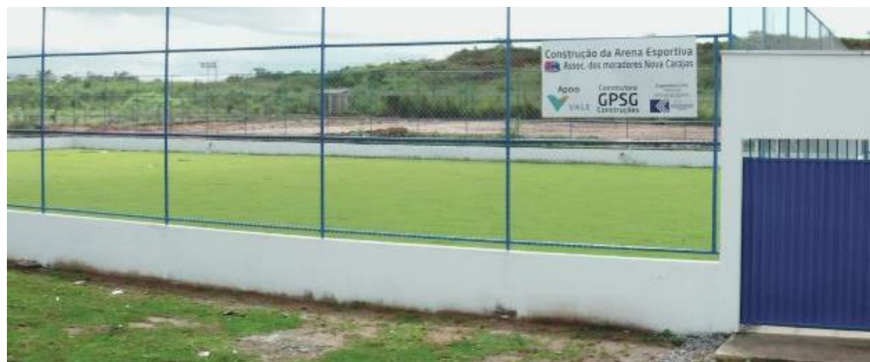
Arena esportiva do bairro Nova Carajás
