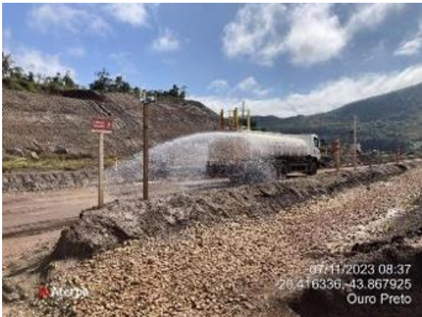
Foto 21. Aspersão nos acessos (Fonte: Vale, novembro 2023).
