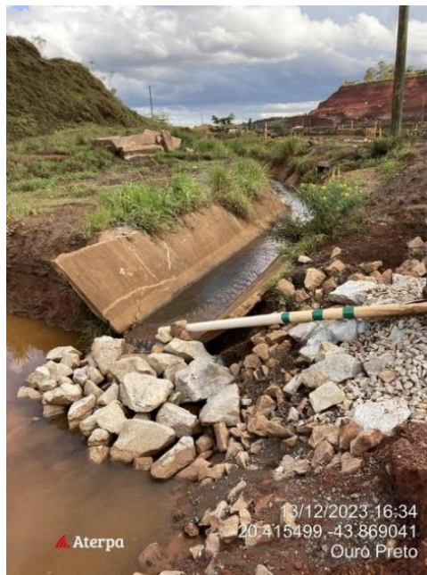
Foto 42: Vista do lançamento do canal de cintura CC001
