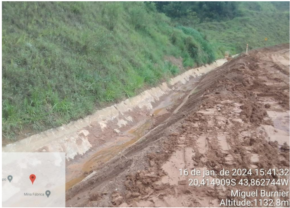
Foto 11: Andamento da limpeza canal CC03 – Grupo (janeiro/24).
