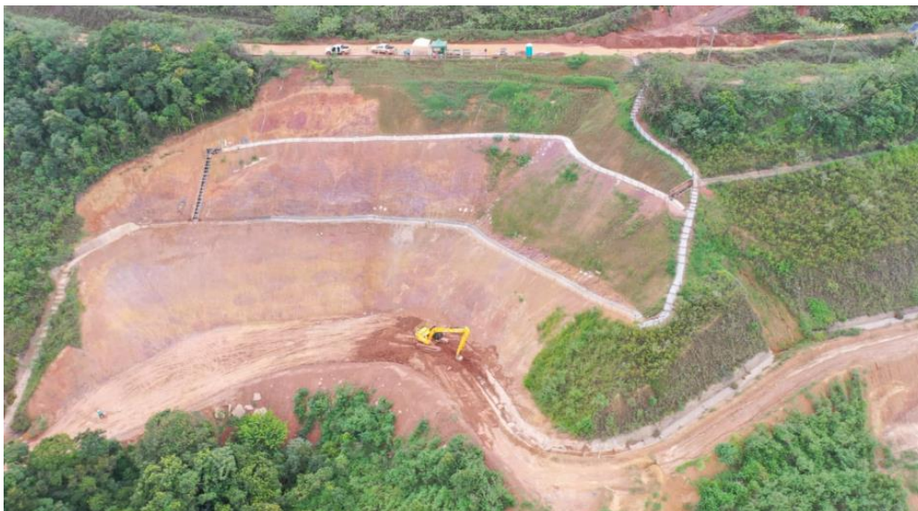
Foto 10: Andamento da limpeza canal CC03 – Grupo (janeiro/24).
