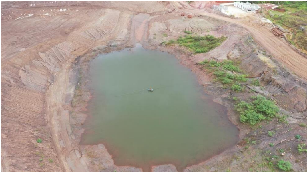
Foto 3: Sump em operação na Cava 10,5 – Dezembro/23.
