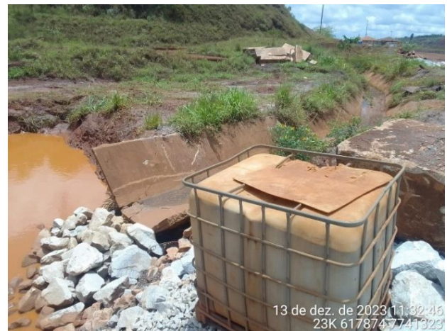
Foto 41: Instalação de flocculante para controle adicional da turbidez
