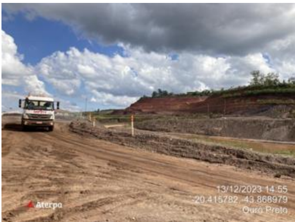
Foto 19. Uso de caminhão pipa para umectação das vias (Fonte: Vale, dezembro, 2023).
