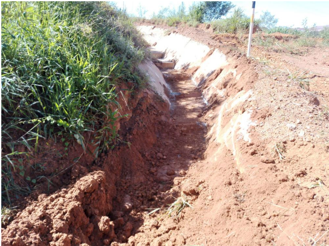
Foto 13:: Andamento da limpeza canal CC03 – Grupo (janeiro/24).
