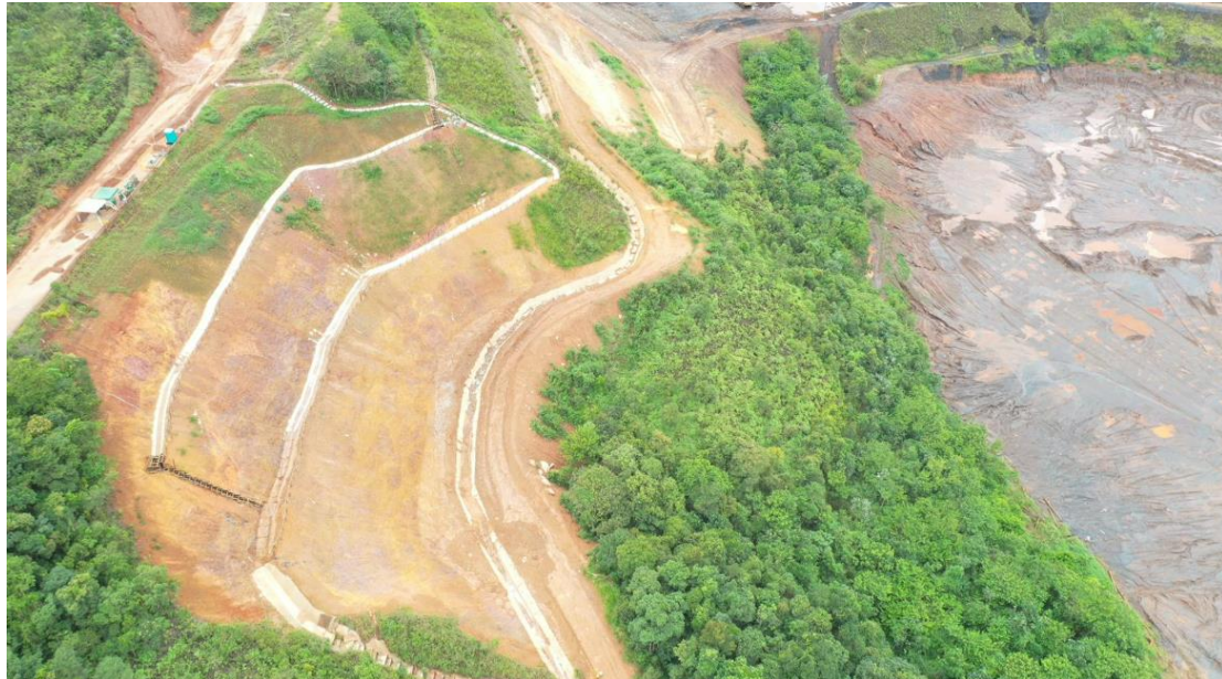
Foto 14: Andamento da limpeza canal CC03 – Grupo (janeiro/24).
