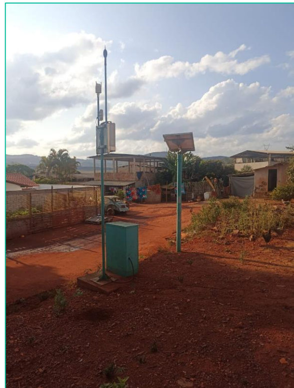
Foto 18. Estação de Monitoramento de Ruído de Ruído. Vale, 2023.
