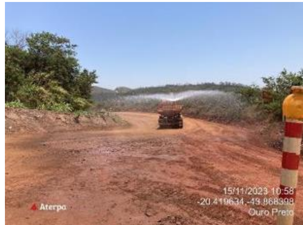
Foto 22. Aspersão frentes de obras da contrata Aterpa (Fonte: Vale, novembro, 2023).
