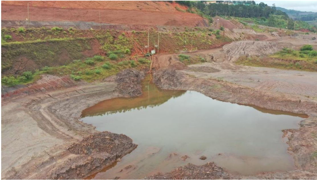
Foto 2: Sump em operação na Cava 10 – PPPC 23/24 – Dezembro/23.
