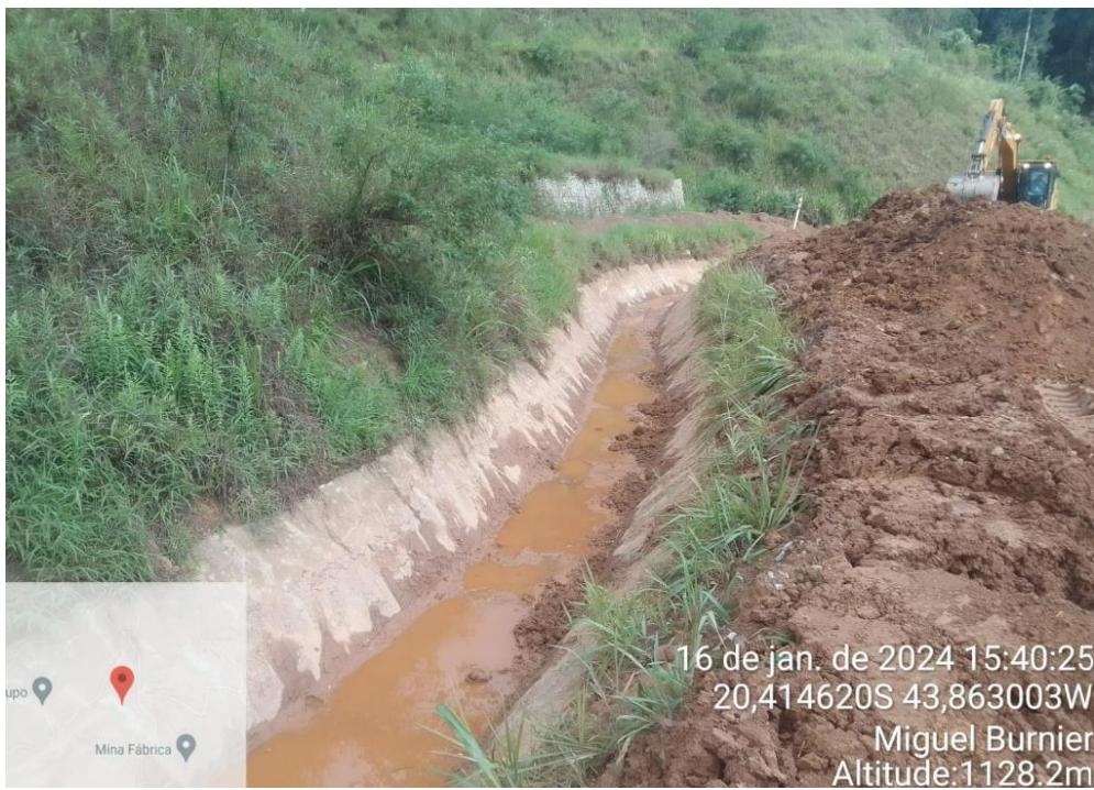
Foto 12: Andamento da limpeza canal CC03 – Grupo (janeiro/24).
