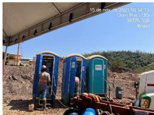
Foto 31. Rotina de higienização de banheiros químicos. Vale 2023.
