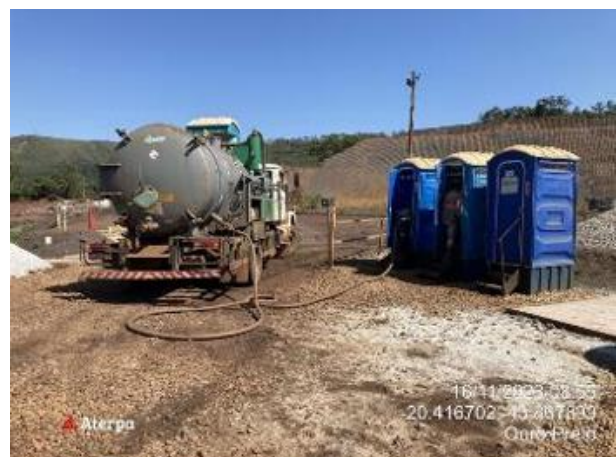
Foto 29. Limpeza e higienização dos banheiros químicos. Sucção de tanque sépticos no canteiro de obras. Fonte: Vale, 2023.
