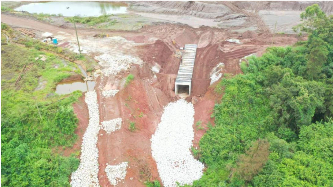
Foto 1: Status da obra do extravasor da Cava 10,5 – 05/02/2024.
