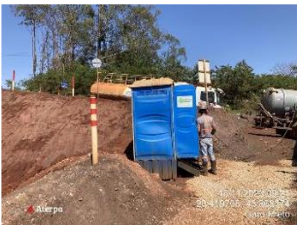
Foto 30. Limpeza e higienização de banheiros químicos nas frentes de obras. Fonte: Vale, 2023.
