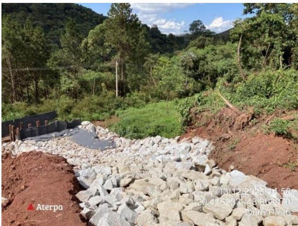
Foto 40: Vista do enrocamento executado para condução da água
