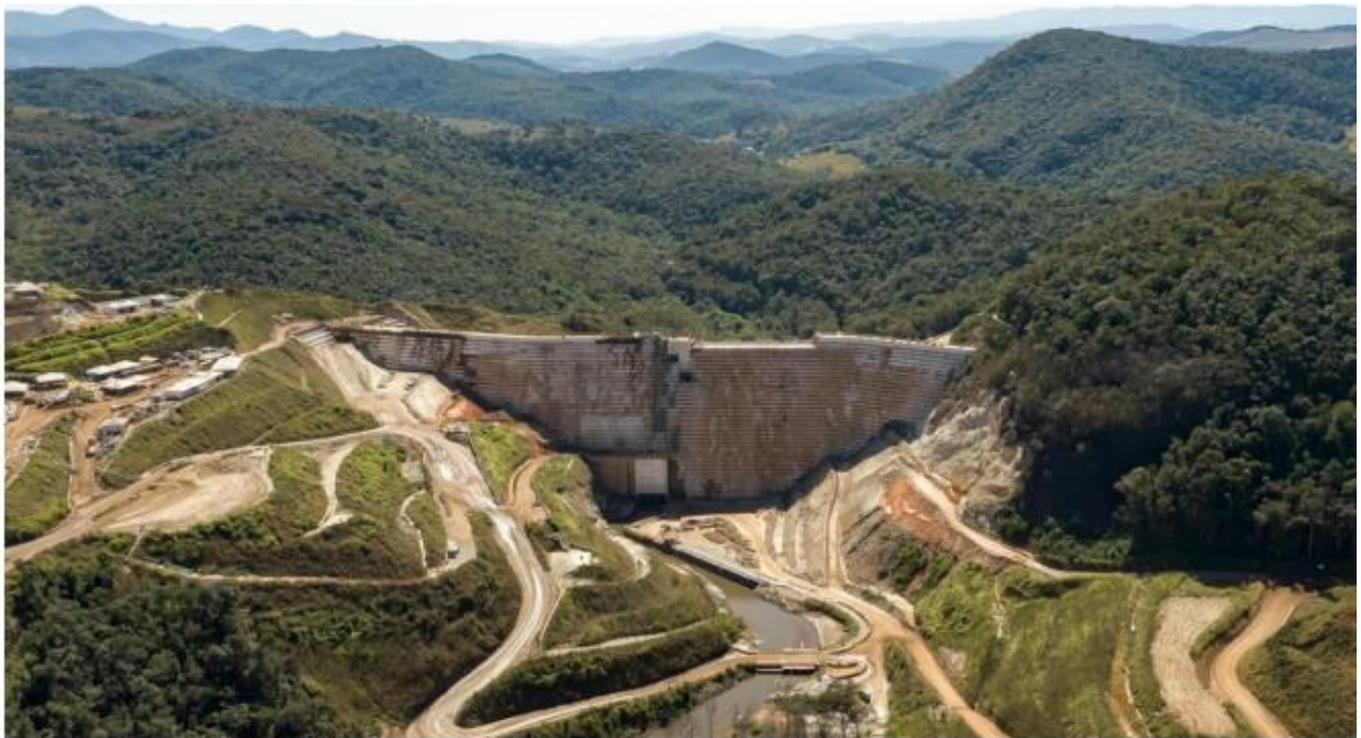
Foto 45. Estrutura de Contenção a Jusante Fábrica. Fonte: Vale, 2022.
