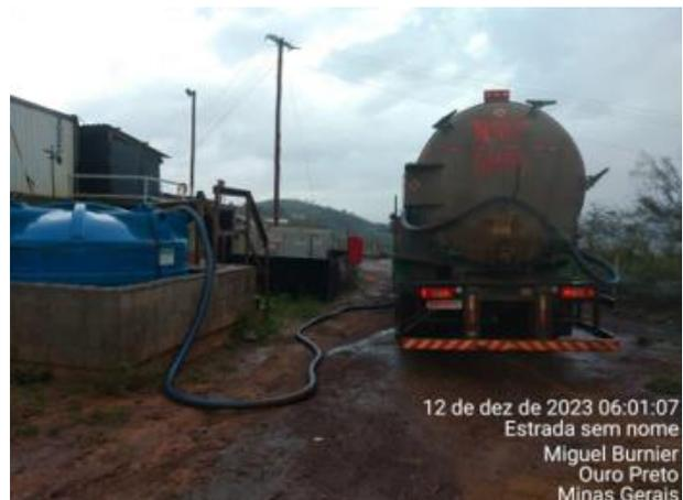
**Foto 31.** Sucção do tanque séptico no canteiro de Forquilhas realizado pela HB locações - Forquilhas I. Vale, dezembro de 2023.
