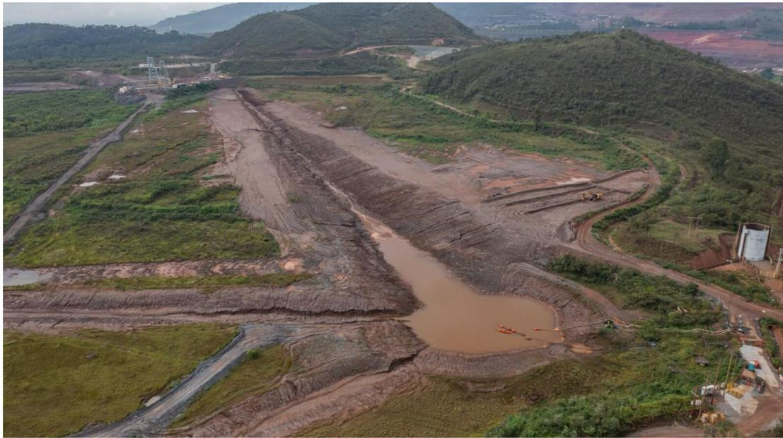
**Foto 8.** Forquilha I – Canal do teste piloto e canal do plano de chuva (Dezembro/23).
