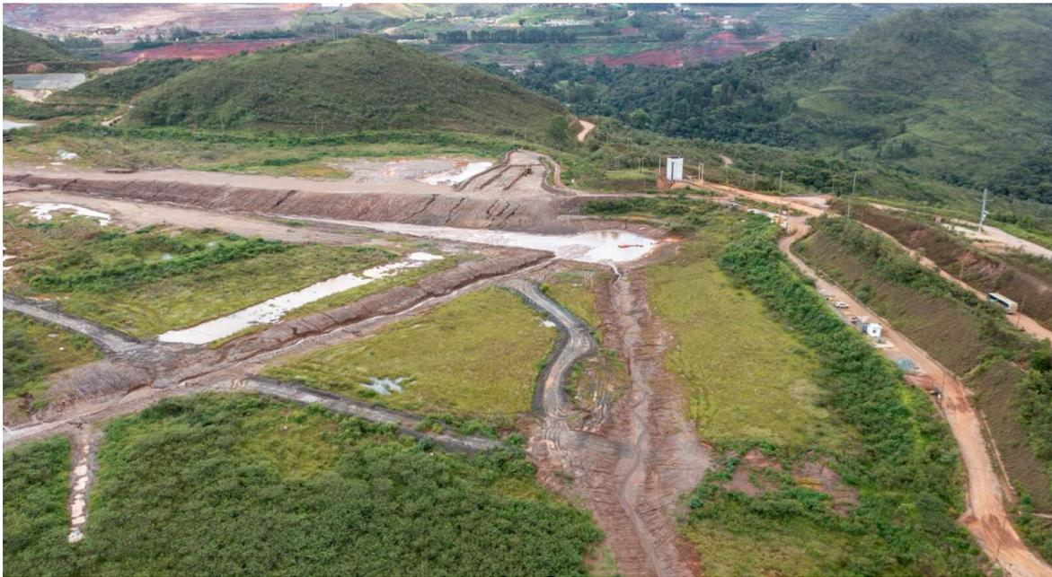
**Foto 13.** Forquilha I – Sump e sistema de bombeamento (Imagem Janeiro/24).
