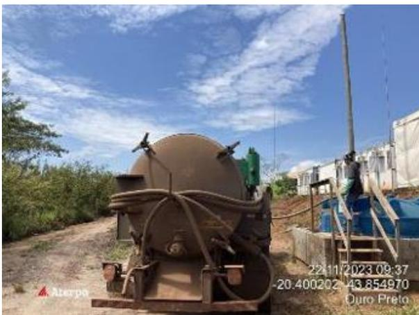
**Foto 30.** Sucção de efluente sanitário dos tanques sépticos no Canteiro de Forquilhas. Vale, novembro de 2023.
