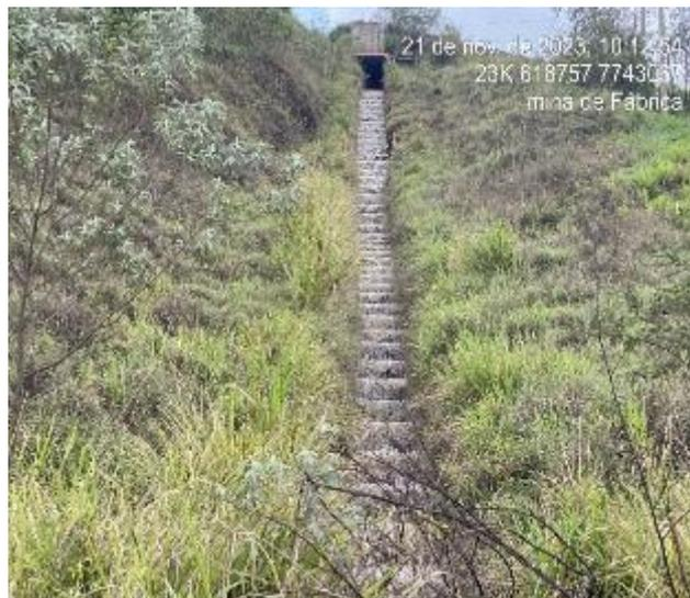
**Foto 18:** Vista do ponto de lançamento final Chicane, após realização da roçada.
