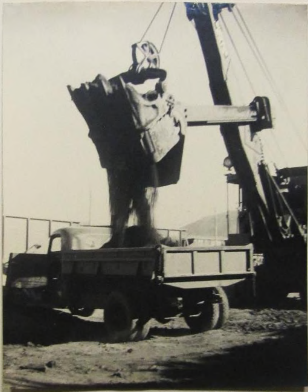
Trabalho mecânico na construção da estrada
