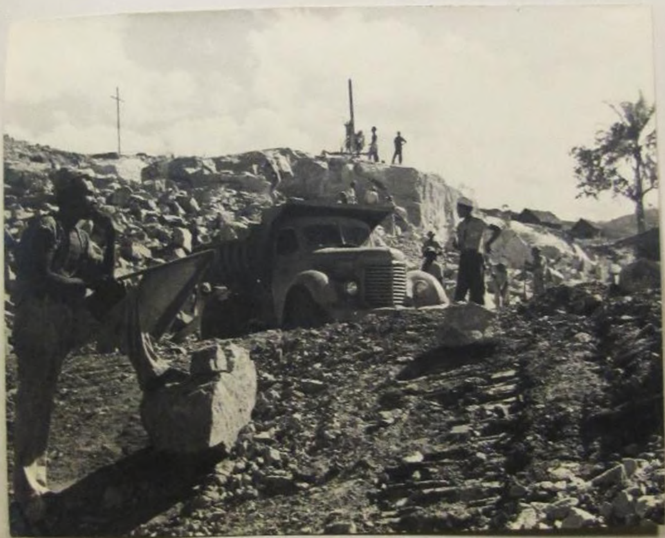
Desmontando a rocha.
