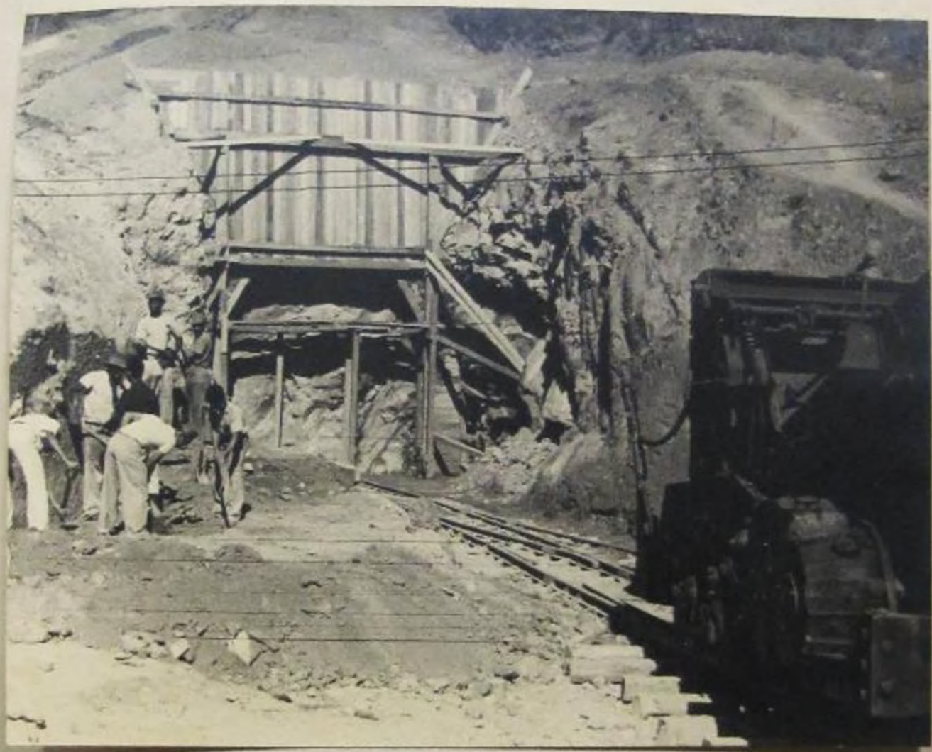
Perfuração do tunel de 1000 metros
