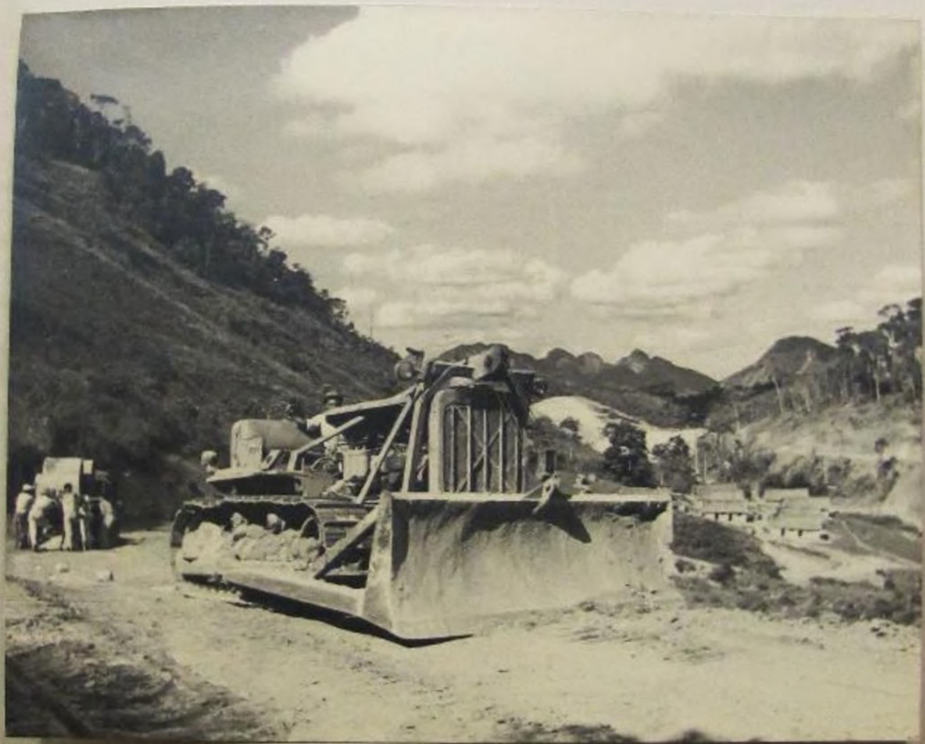
Preparando o leito da estrada de ferro
