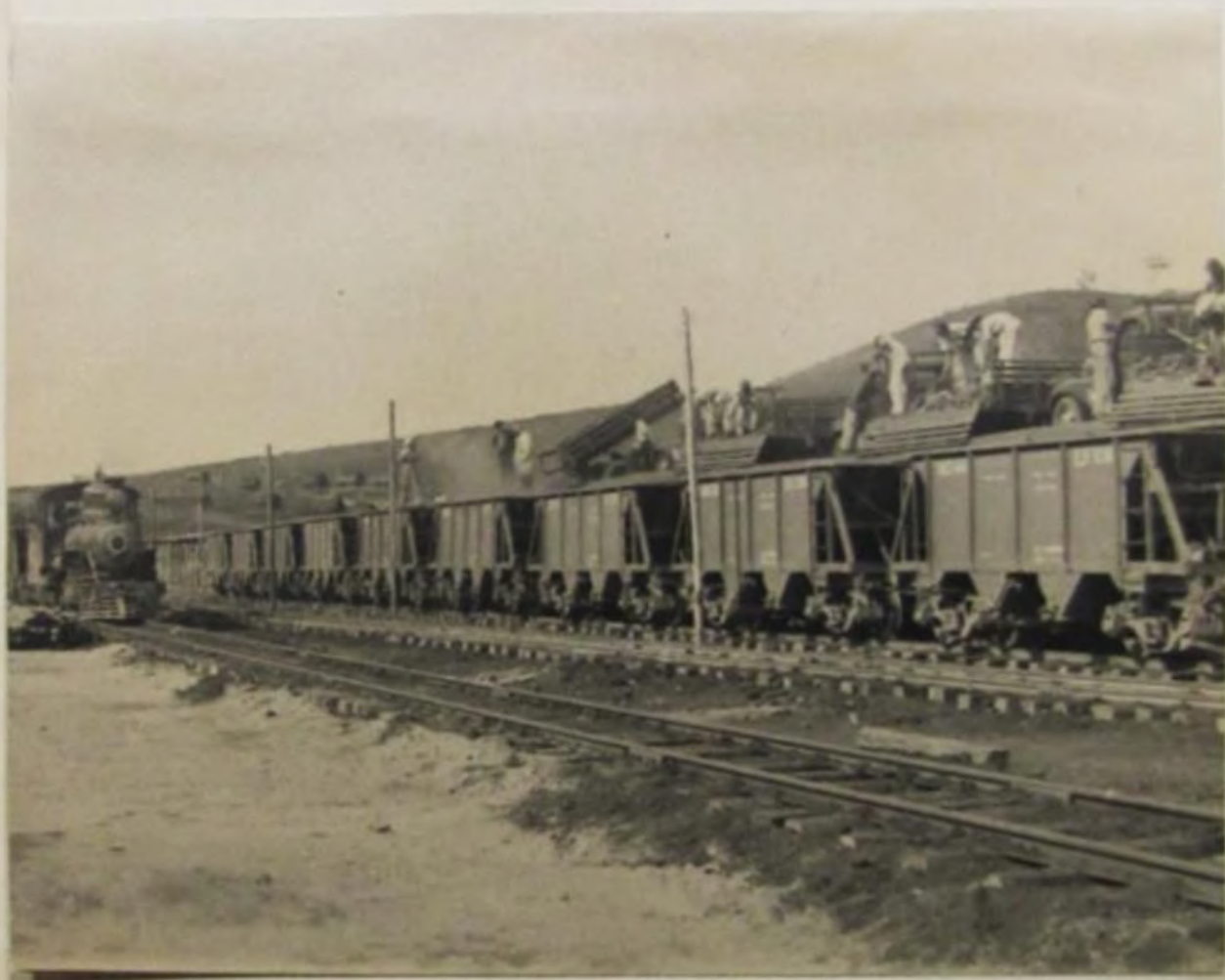
Carreg to provisório do minério
