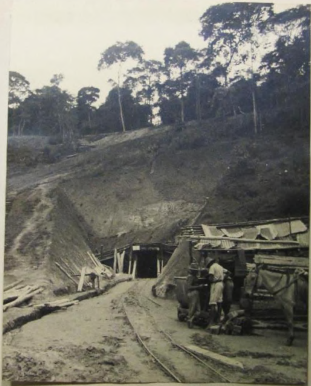
Tnelno Serv. de Abastec to de Agua
