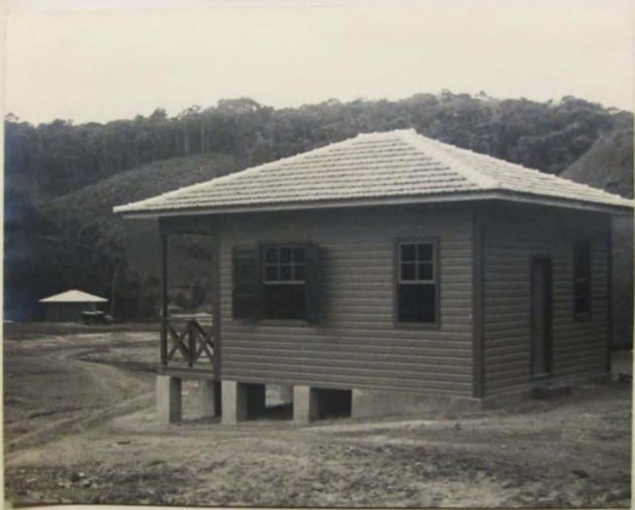
Residência de operário
