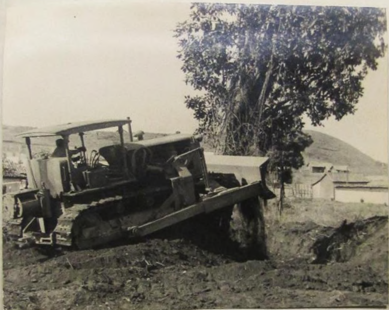
"Preparando o leito da estrada de ferro"
