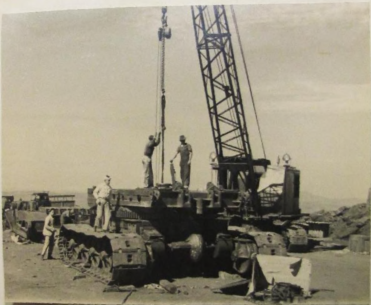
"Escavadeira (cap de de 16 ton. de minério)"
