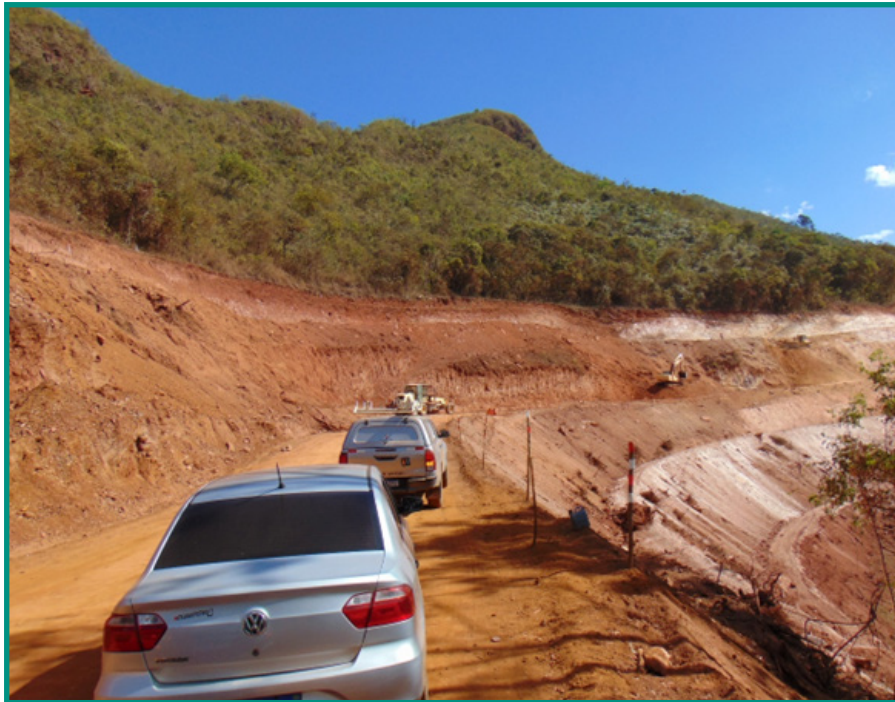
Em trecho da AEL, obras na MGC-262 causam interações no tráfego viário.
