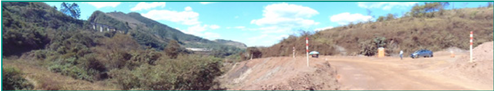
Vista panorâmica da ADA e AEL, no sentido Norte-Sul, voltada para a área urbana de Barão de Cocais.
