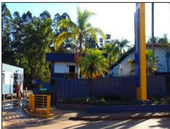
Figura 15. Unidade da Gerdau, indústria siderúrgica na área urbana de Barão de Cocais
