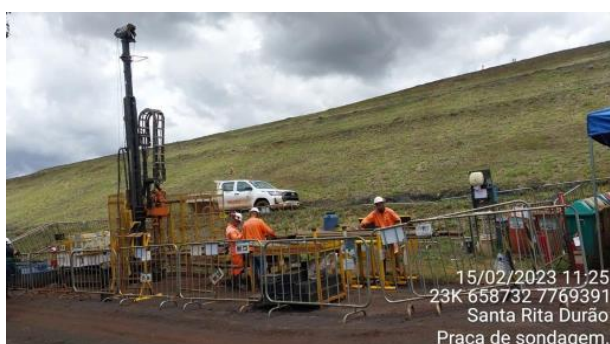
Fotos 5 e 6. Praça de sondagem geotécnica da barragem de Xingu. Sonda mista/CPTu, 2023.
