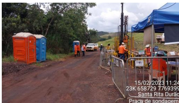
Fotos 5 e 6. Praça de sondagem geotécnica da barragem de Xingu. Sonda mista/CPTu, 2023.
