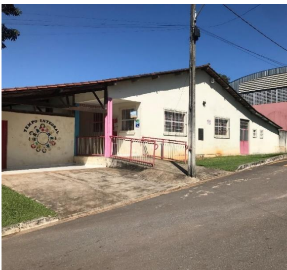
Figura 24 - Escola da Escola Estadual Dom Benevides. Ao fundo, Ginásio Poliesportivo Fonte: Lume, 2022
