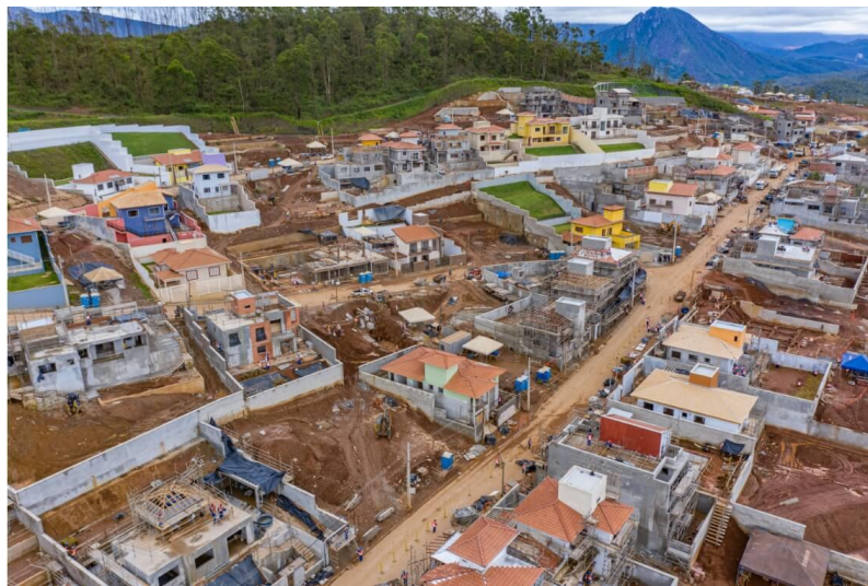
Figura 11 - Foto das obras de Nova Bento Rodrigues Fonte: Fundação Renova, 2021
