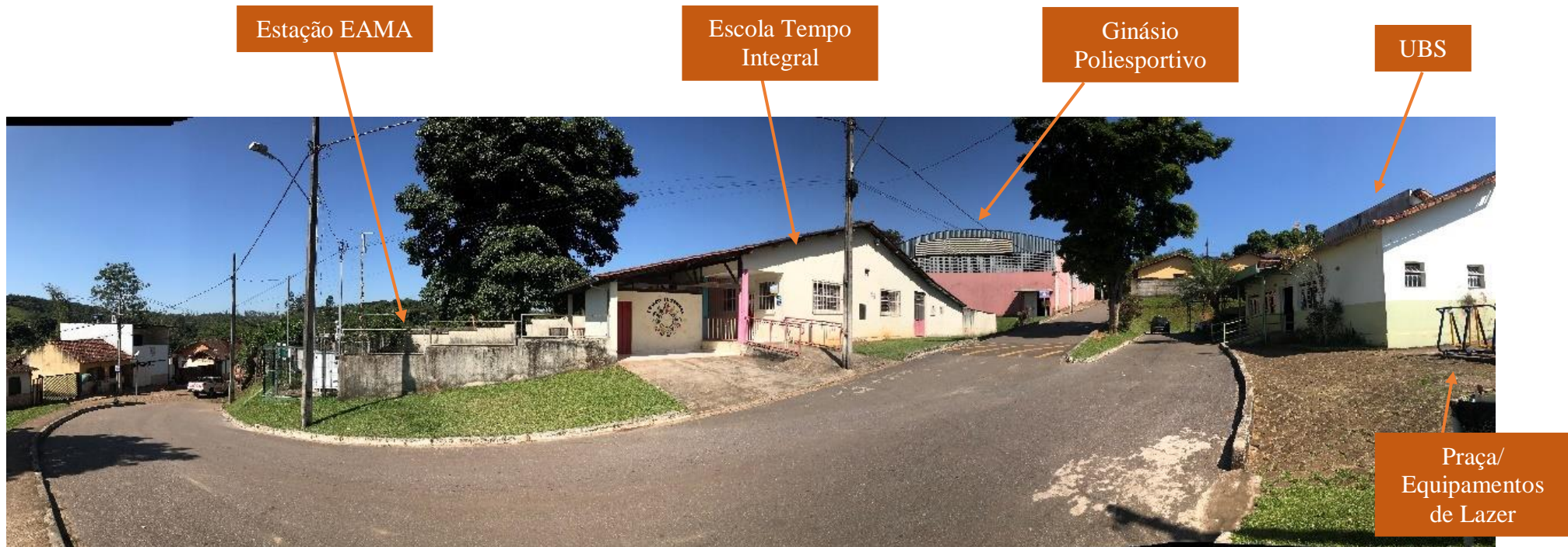
Figura 9 - Na primeira edificação a direita, pode-se observar a estrutura da UBS localizada em Santa Rita Durão. Além disso, a figura demonstra que diversas estruturas de interesse se localizam no mesmo ponto: Estação (da esquerda para direita) EAMA 71 da Vale, Estação de monitoramento da Samarco, Escola Tempo Integral, Ginásio Poliesportivo, praça com equipamentos de lazer.
