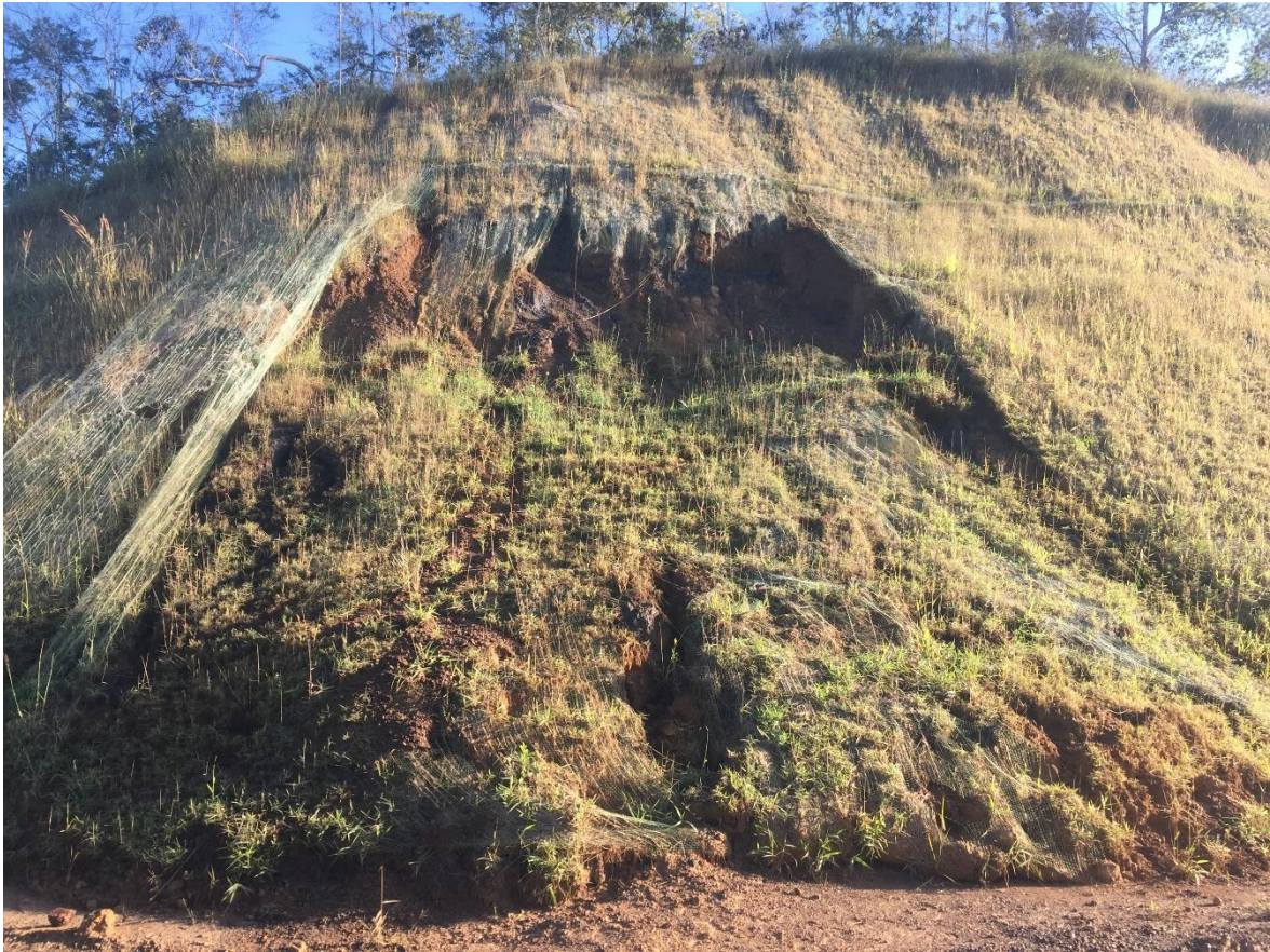
Figura 41 - Deslizamento em saprólito siltoso em corte de estrada recentemente protegido com tela vegetal, a nordeste da Área Diretamente Afetada (bloco norte). Coordenadas UTM: 664873 E; 7766223 N.
