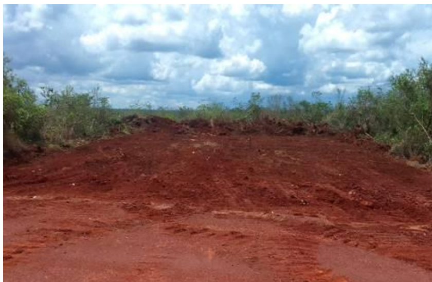
Figura 18. Leira de retenção de sedimentos em campo
