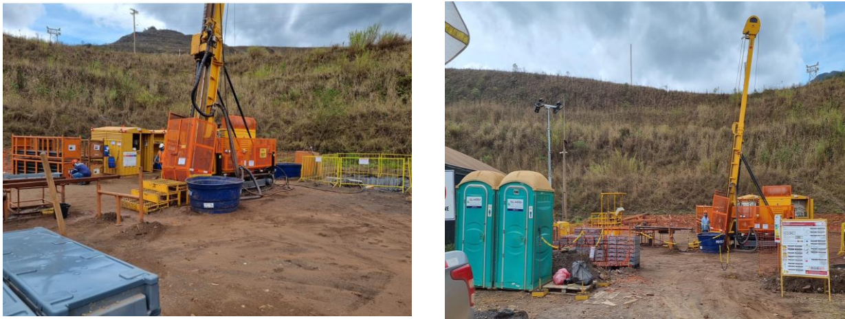
Figura 5. Exemplos de praças de sondagem em áreas da Vale no Complexo de Mariana. Fonte: VALE, 2021.
