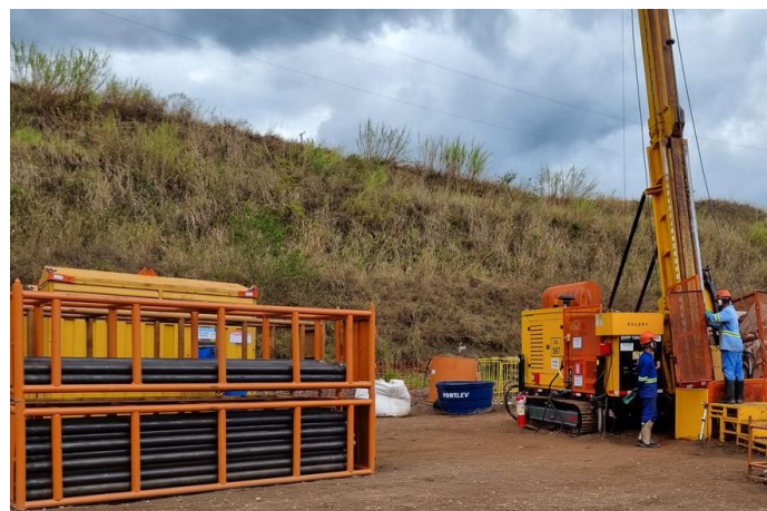
Figura 6. Foto ilustrativa de conjunto de hastes de perfuração. Fonte: VALE, 2021.
