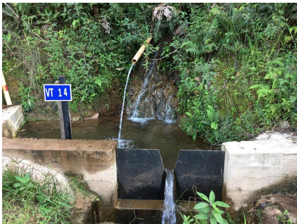
Figura 48 - Surgência no corte de estrada as margens do reservatório artificial. A surgência fica cerca de 2 m acima do ponto mostrado na imagem. Coordenadas UTM: 664156 E; 7762125 N.
