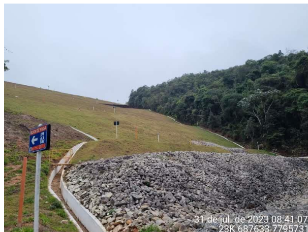
Foto 40. Vista da porção dos alteamentos do eixo do EDVC e do dique de partida (abaixo). Bioma, 2023.
