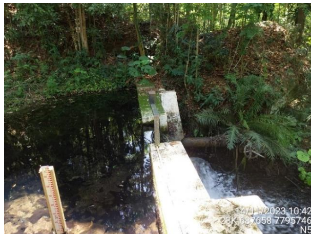
Foto 90. Medidor de vazão (vertedor) – Ponto EDVDC-N-05.
