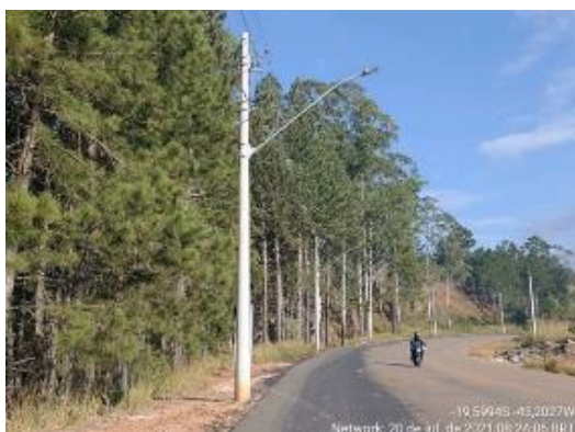
Figura 6-43 - Visão geral dos acessos pavimentados
