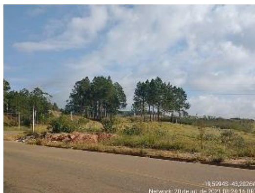
Figura 6-44 - Visão geral dos acessos pavimentados
