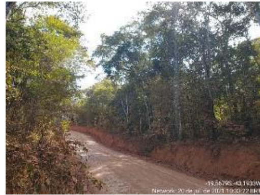
Figura 6-46 - Visão geral dos acessos não pavimentados
