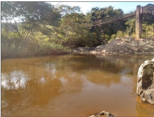
Figura 6-333 - Área de estudo – Ponto ICT12 – Rio Tanque – Captação - Montante
