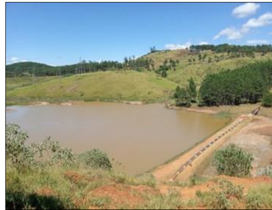
Figura 6-286 – Área antropizada, próxima ao barramento
