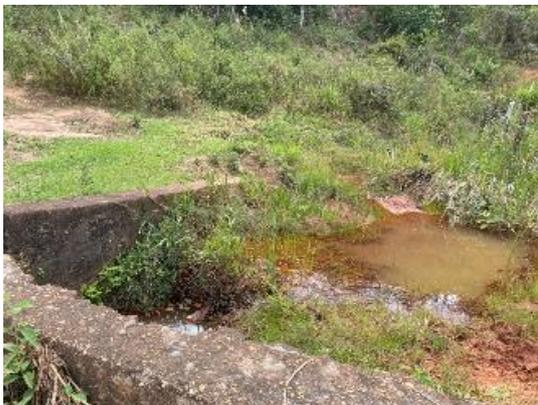
**Figura 6-125 - Ponto de travessia- Bueiro, do tipo manilha-TR-15**
