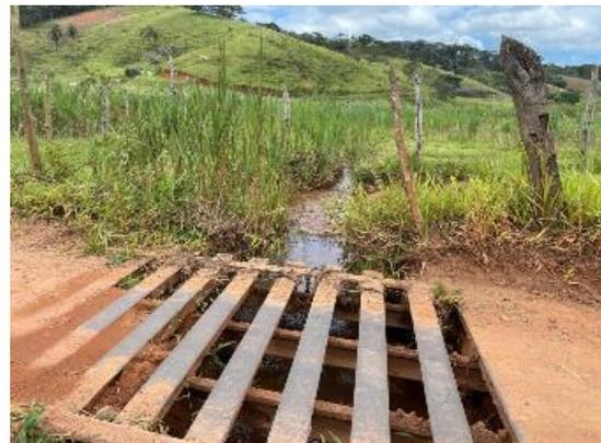
**Figura 6-126 - Ponto de travessia- curso d'água travessia do tipo ponte de ferro (mata-burro) -TR-16**
