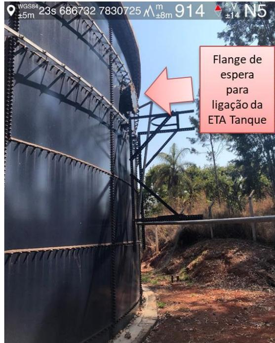
Figura 3-32 - Fotografia do Reservatório Existente com Flange de Espera para Conexão com a Nova ETA. Fonte: Arcadis (2021)
