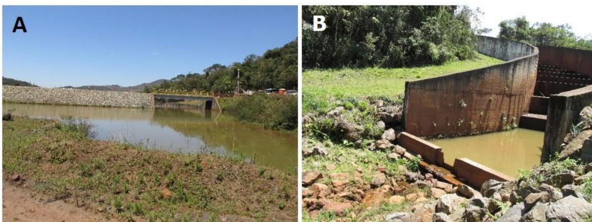
Figura 49 - Barragem João Pereira (UTM N: 7.739.462, E: 614.155). (A) Visão geral da barragem João Pereira. (B) Saída do vertedouro da barragem João Pereira.
