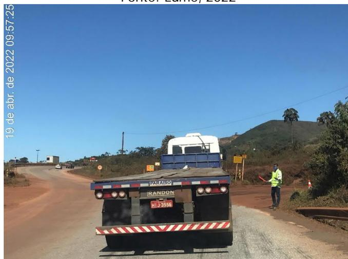
Figura 309 Ponto de Pare e siga na ADA com placas indicadoras e acompanhamento de pessoal no monitoramento bem como cabine de segurança
