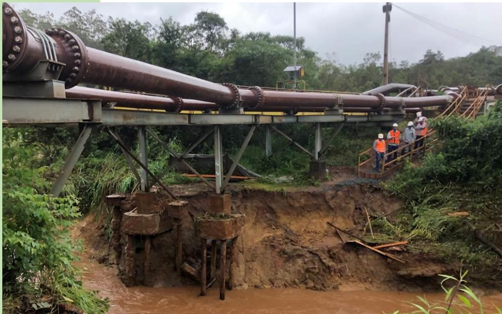
Figura 3 – Vista da margem esquerda e base 43/53 do *Pipe Rack* de um mesmo ponto de observação, com intervalo de quatro (04) meses, período chuvoso. Fonte: Vale S.A.
