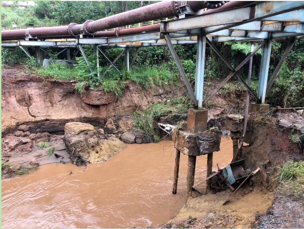
Figura 2 – Vista da margem esquerda do Ribeirão Vargem Grande, com exposição das estruturas de suporte do *Pipe Rack*, bem como degradação das margens.
