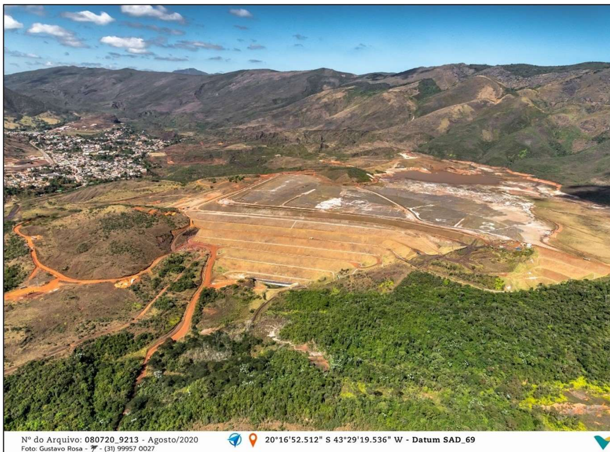
Foto 56 Visão geral da Barragem Doutor e adjacências, onde se nota ausência de rupturas no declive e a exposição de solos claros relacionados às ocorrências relacionadas a filitos, quartzitos e coberturas consolidadas.
