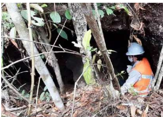
Foto 63 - Entrada da Galeria 26, com zona de abatimento antigo.
