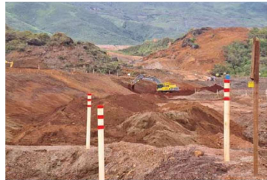
Foto 07 Obras de implantação do sistema extravasor da barragem Doutor Autor: Total meio Ambiente, 2020
