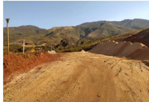
Foto 13 Obras de implantação do sistema extravasor da barragem Doutor Autor: CLAM, 2021
