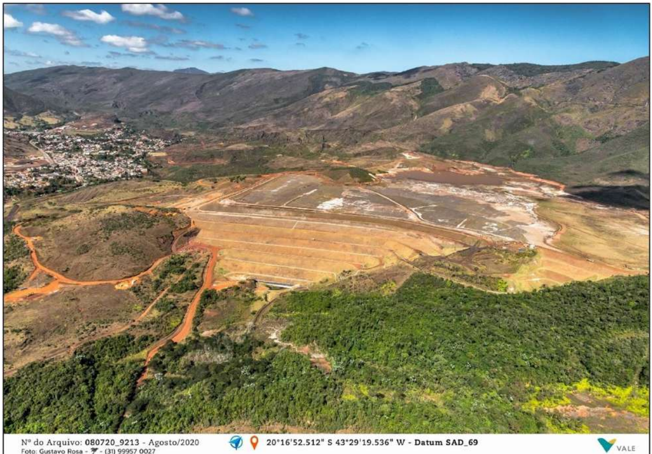
Foto 05 - Visão geral da Barragem Doutor e adjacências, onde se nota ausência de rupturas no declive e a exposição de solos claros relacionados às ocorrências relacionadas a filitos, quartzitos e coberturas inconsolidadas.
