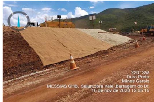
Foto 05 Obras de implantação do sistema extravasor da barragem Doutor Autor: Total meio Ambiente, 2020
