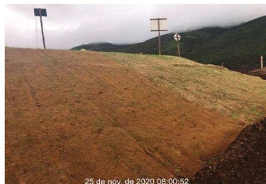
Foto 08 Obras de implantação do sistema extravasor da barragem Doutor Autor: Total meio Ambiente, 2020
