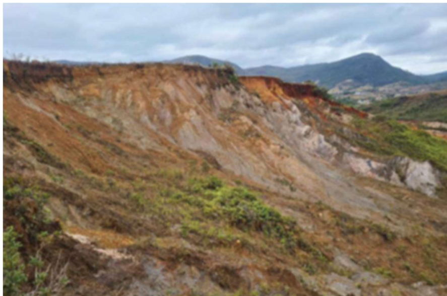
Figura 113 Detalhe de processo erosivo
