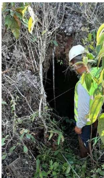
Foto 36 - Entrada da Galeria 12.
