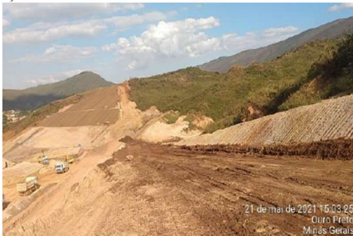
Foto 10 Obras de implantação do sistema extravasor da barragem Doutor Autor: CLAM, 2021
