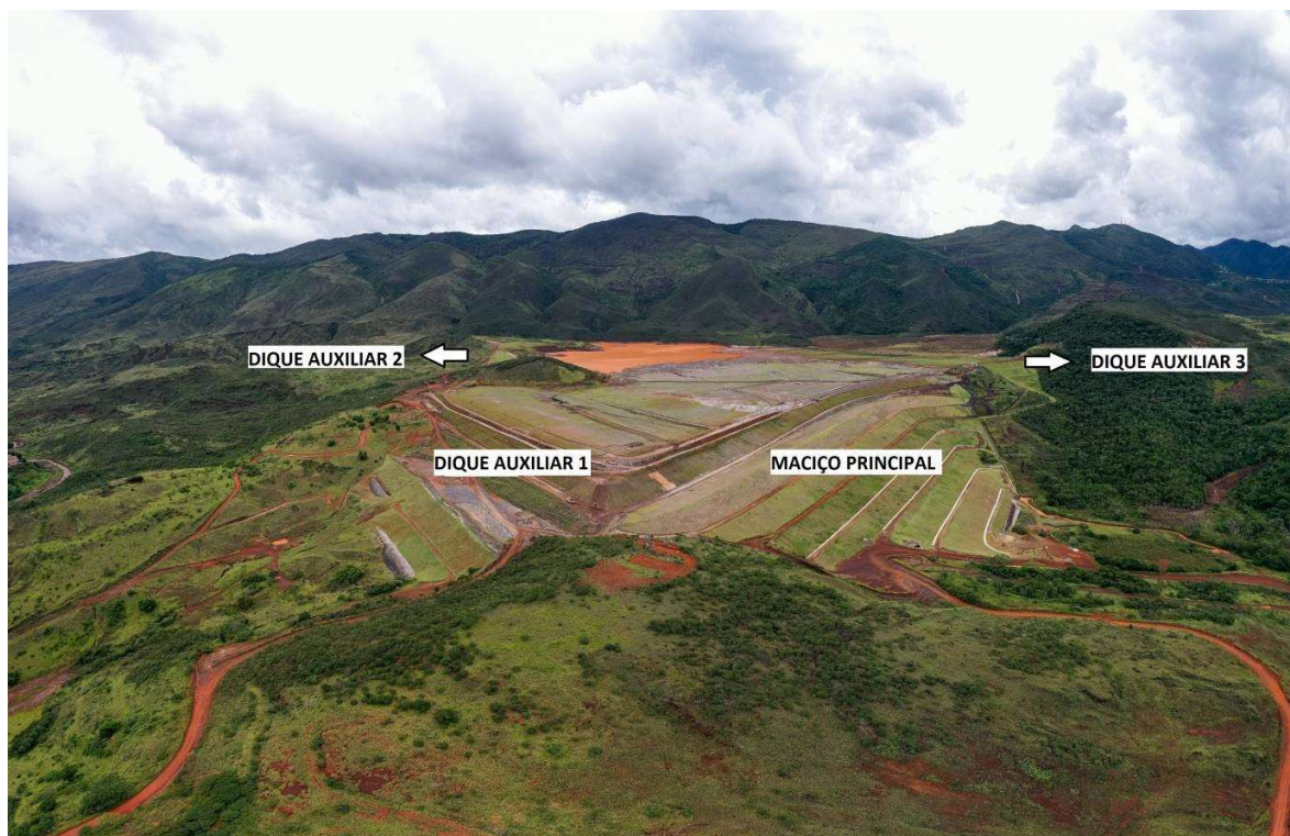
Foto 01 Vista geral da barragem Doutor
