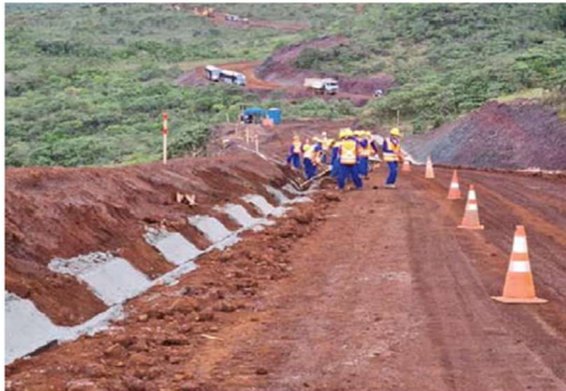
Foto 06 Obras de implantação do sistema extravasor da barragem Doutor Autor: Total meio Ambiente, 2020
