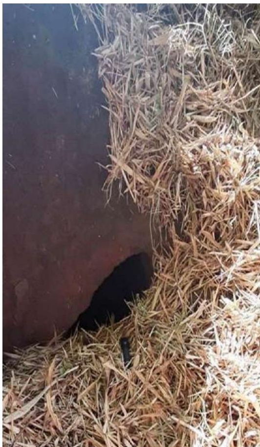
Foto 49 - Entrada estreita coberta da Galeria 18, em bambuzal próximo à rodovia MG-129. Autor: CLAM, 2020
