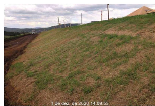
Foto 09 Obras de implantação do sistema extravasor da barragem Doutor Autor: Total meio Ambiente, 2020
