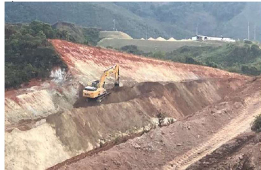
Foto 11 Obras de implantação do sistema extravasor da barragem Doutor Autor: CLAM, 2021
