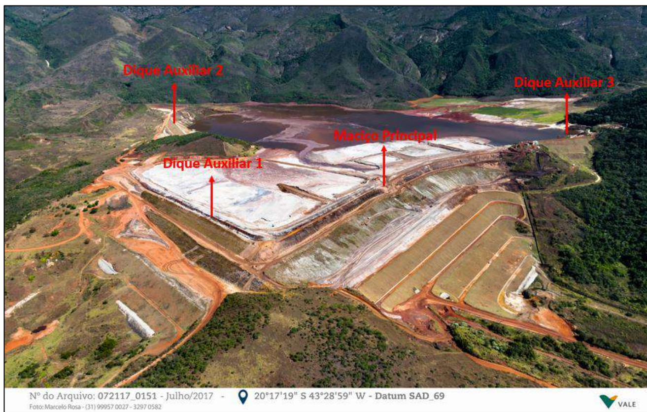
Figura 3.2 – Vista geral da Barragem Doutor.
