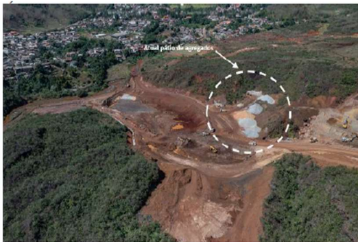
Foto 12 Obras de implantação do sistema extravasor da barragem Doutor Autor: CLAM, 2021
