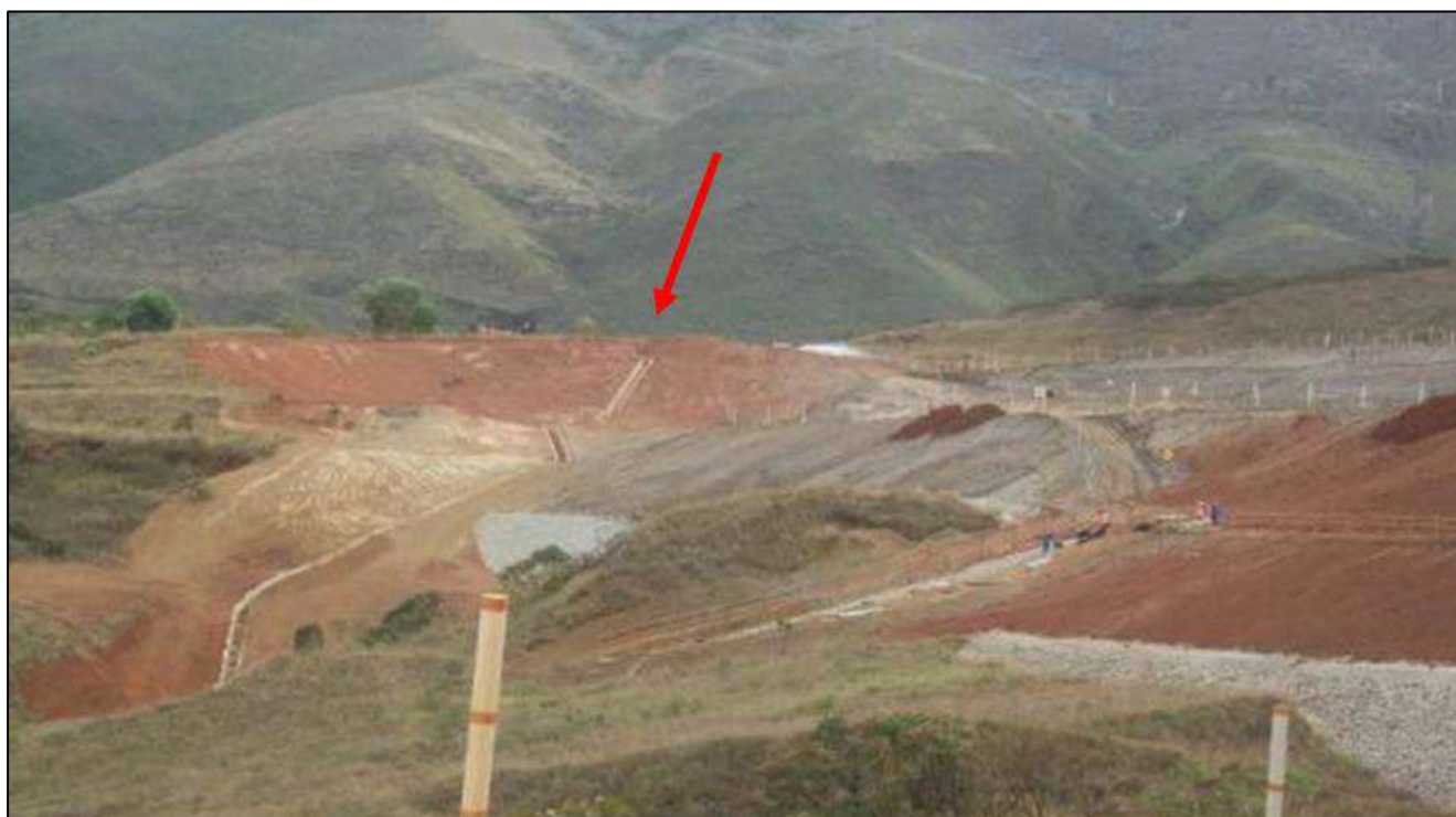
Figura 3.5 – Vista das descidas de água D10, D11 e D12 concluídas. Fonte: VL 119.18-10-D-BA-RT-07-300-Rev0.
