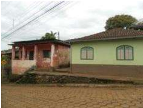
Foto 102 Antigo local das Ruínas do Casarão da Lapa (P35), no lugar se situam esses dois imóveis, respectivamente n° 4 e 6. Autor: CLAM, 2021.
