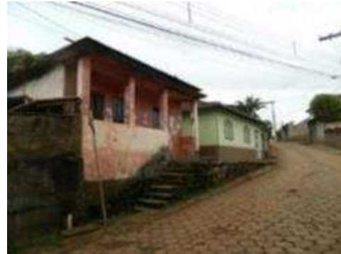
Foto 103 Antigo local das Ruínas do Casarão da Lapa (P35), no lugar se situam esses dois imóveis, respectivamente n° 4 e 6. Autor: CLAM, 2021.
