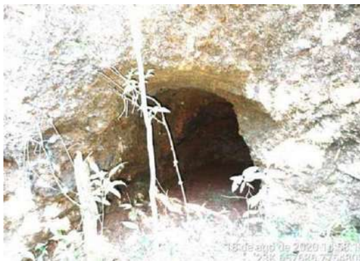
Foto 55 - Entrada da Galeria 24, de reduzidas dimensões, apenas para pesquisa.
