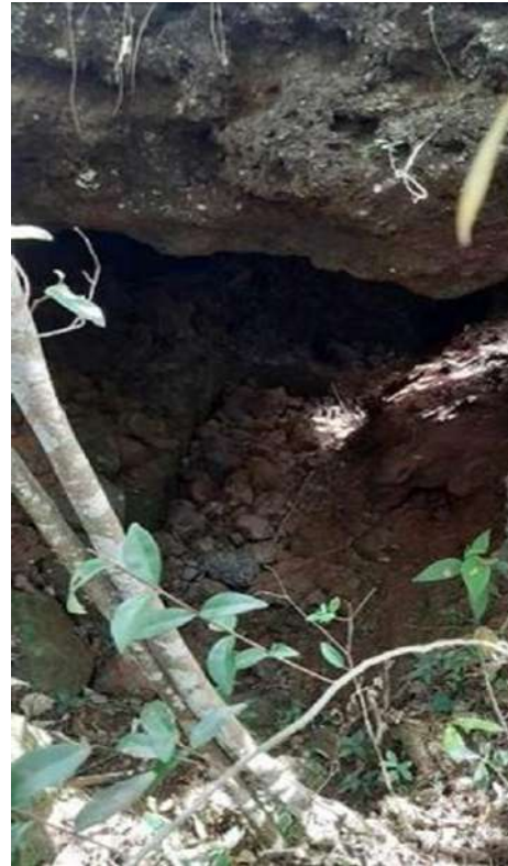
Foto 30 - Galeria 06, com escavações recentes. Autor: CLAM, 2020
