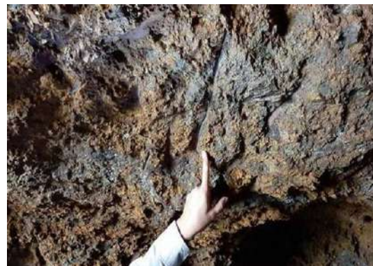
Foto 24 - Marcas de picaretadas no teto. Autor: CLAM, 2020
