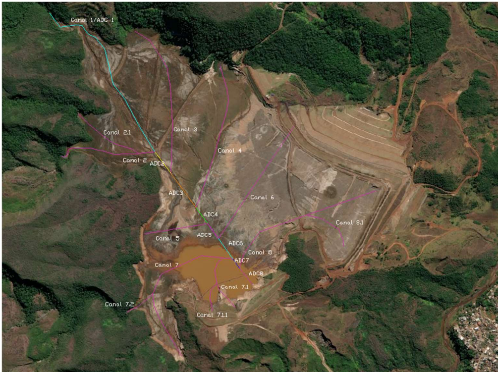
Figura 15 Canais para condução de águas pluviais no reservatório para a descaracterização da barragem Doutor.
