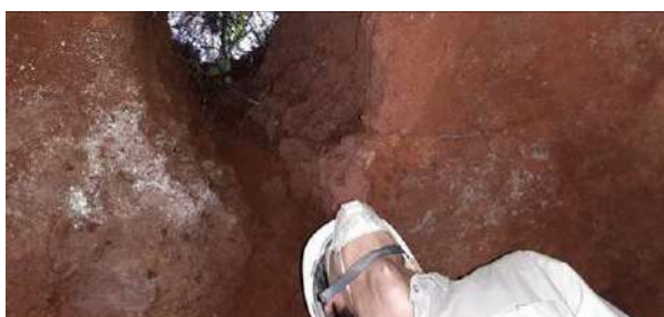
Foto 41 - Claraboia aberta para retirada de material no teto da Galeria 13.
