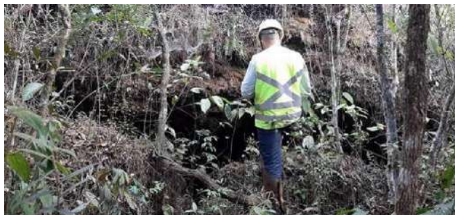
Foto 56 - Entrada da Galeria 25, forma lenticular e abatimentos internos. Forma passagem para lavra antiga ao lado oposto.
