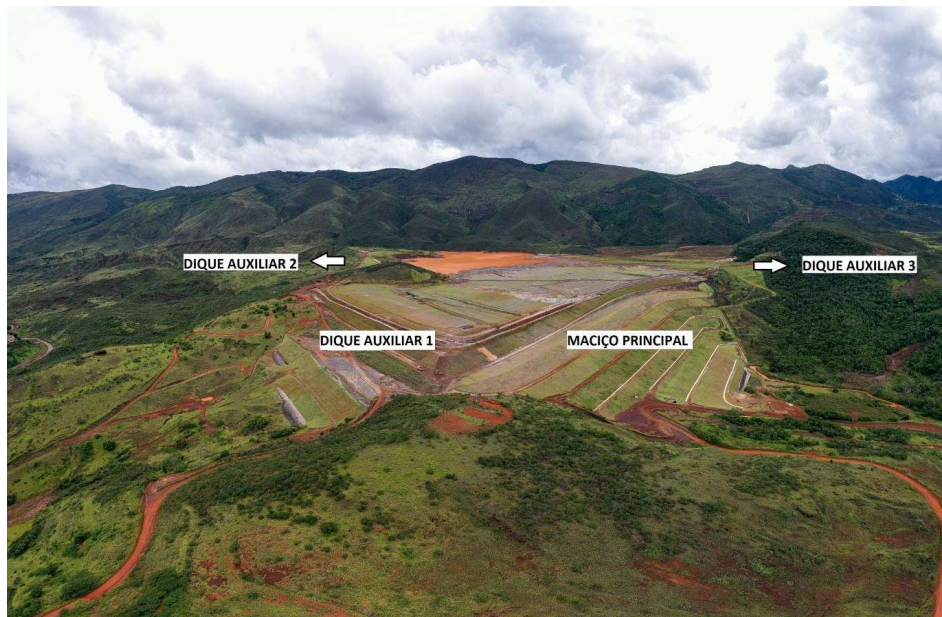
Foto 02 Localização das principais estruturas da barragem
