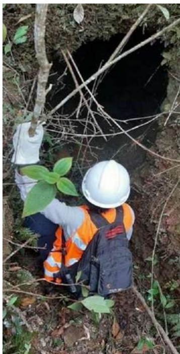
Foto 47 - Entrada da Galeria 16.
