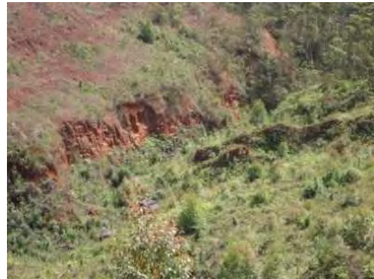
Figura 27: Drenagem inativa com grande processo erosivo.
