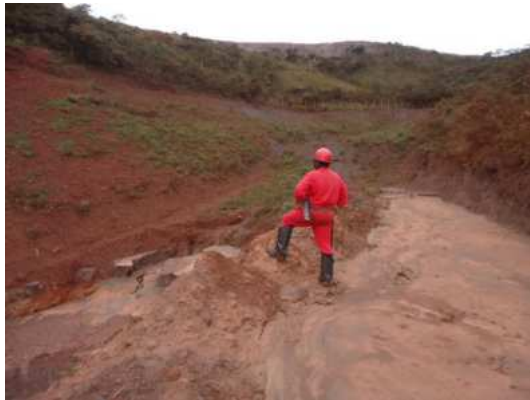
Figura 34: Drenagem muito assoreada ao fundo.
