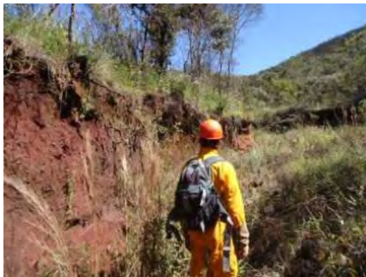
Figura 72: Calha da drenagem com aproximadamente 2 mts de profundidade.
