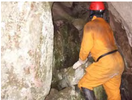
Figura 284: Interior da cavidade com desabamento.
