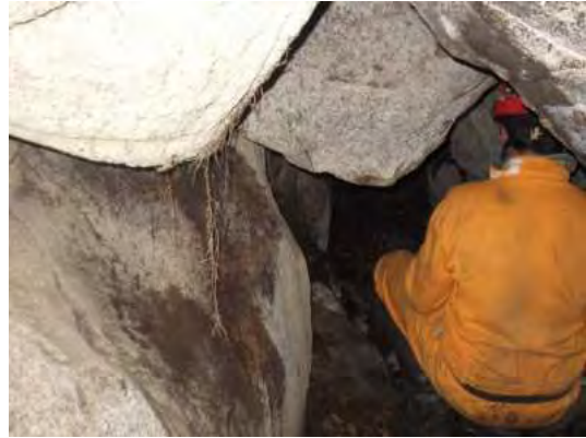
Figura 267: Conduto com teto baixo.
