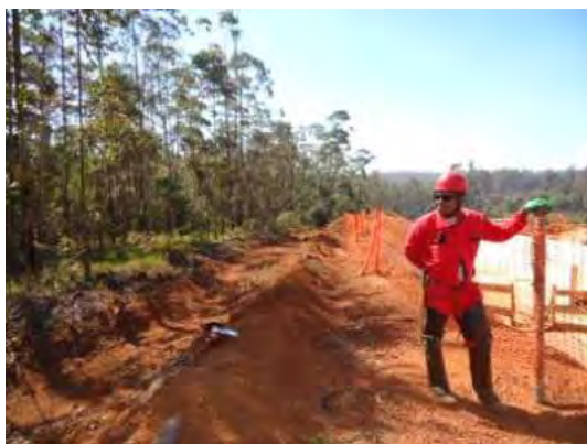
Figura 18: Divisa entre eucaliptos e a obra.
