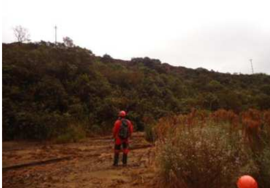
Figura 146: Drenagem bastante assoreada.
