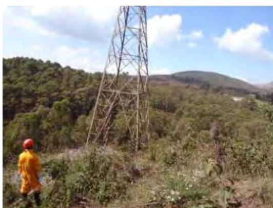
Figura 4: Torre de transmissão.
