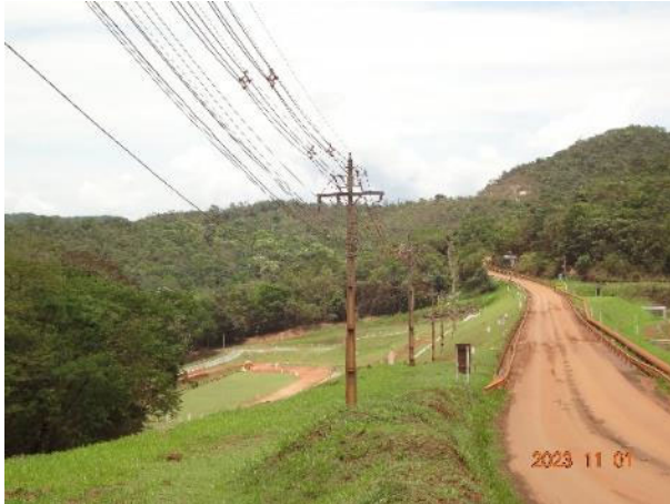
Figura 56 – Parte do traçado da linha de energia elétrica sobre o talude da Barragem Dicão, com predominância de braquiarião.
