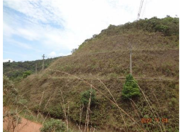
Figura 57 – Linha de energia elétrica passando em uma berma do talude de corte à margem da MG 129, com predominância de capim-gordura.
