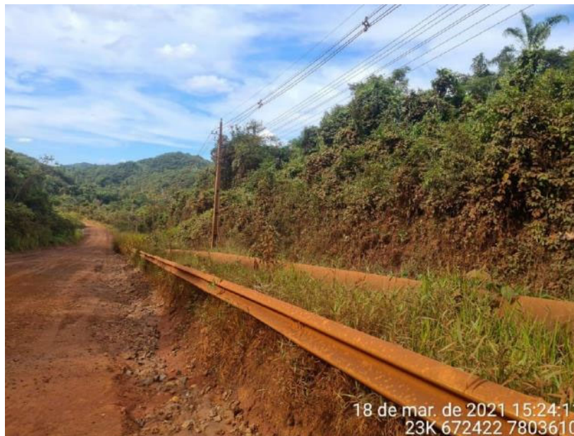
Figura 166 – Trecho da Linha de Distribuição, denominada BR-RD04, localizada na Mina Brucutu. Fonte: Total (2021).
