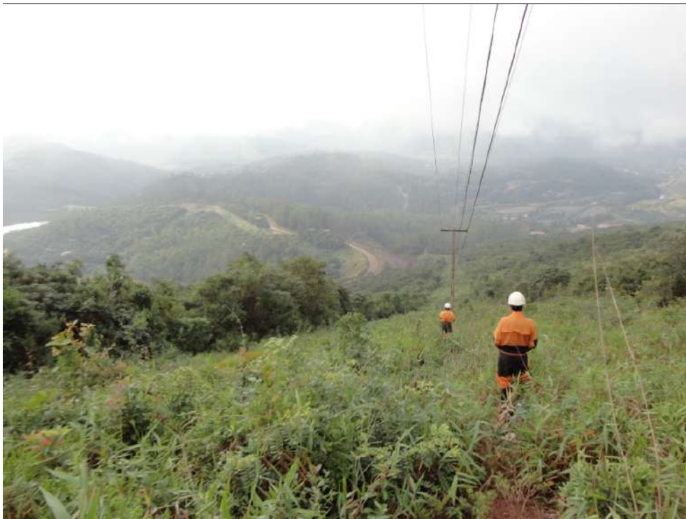
Foto 14 - Direção: E; Coordenadas: UTM 687638/7794610 ZONA 23K DATUM SAD69; Altitude: 893 m - Dia 27-05-2014: Vista parcial de caminhamento sob Linha de transmissão. Local caracterizado como baixo potencial espeleológico devido às lentes de Filito que aparecerem afloradas.
