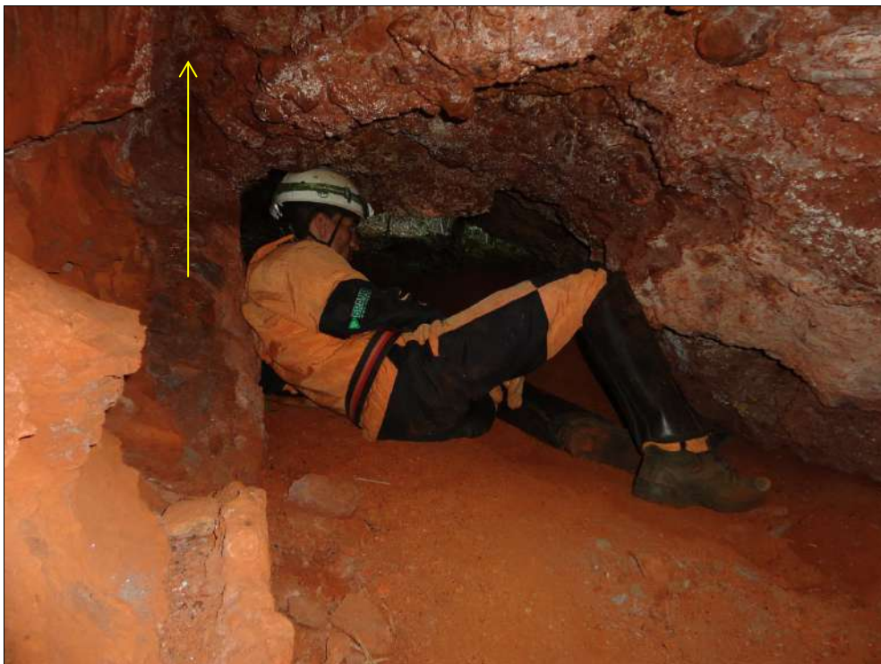
Foto 6.91 - Contato litológico observado no teto da cavidade AGL_0009, demarcado pela ocorrência de uma fratura.
