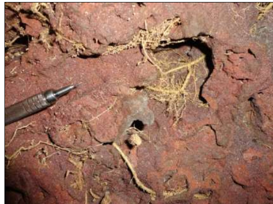
Foto 6.18 - Raízes observadas nas paredes e no teto da cavidade.
