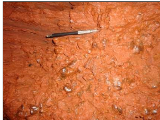
Foto 6.70 - Crosta ferruginosa, delgada, marrom-avermelhada observada de forma generalizada na cavidade.
