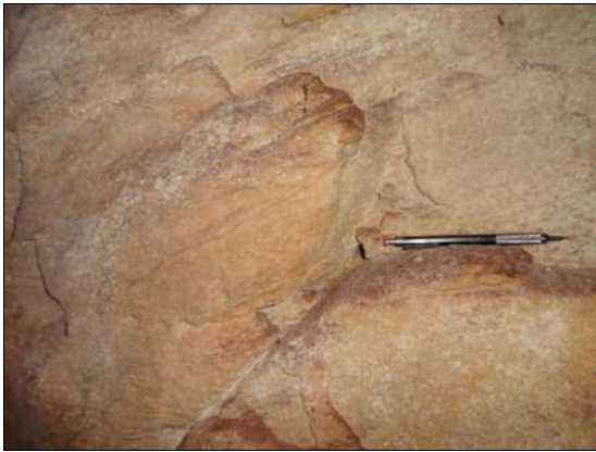
Foto 6.104 - Vista parcial de quartzito, observado na cavidade AGL_0011.
