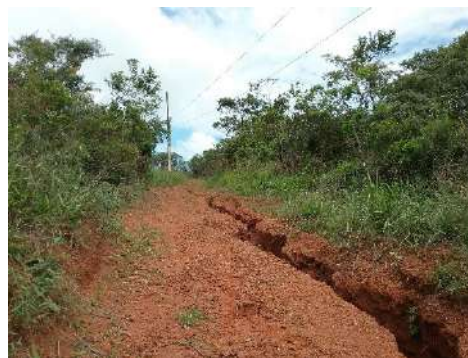
Foto 13 - Processo erosivo (sulco) no acesso localizado na porção norte da AEL.
