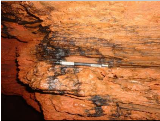
Foto 6.67 - Guano observado no teto e nas paredes da cavidade.
