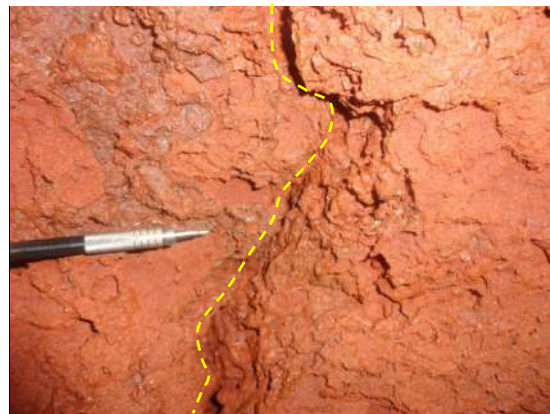
Foto 6.60 - Junta de alívio identificada no teto da AGL_0006.
