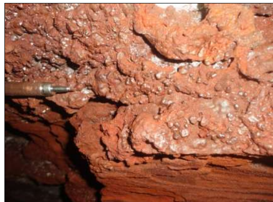
Foto 6.44 - Crosta ferruginosa, delgada, marrom-avermelhada, observada nas paredes e teto da cavidade.
