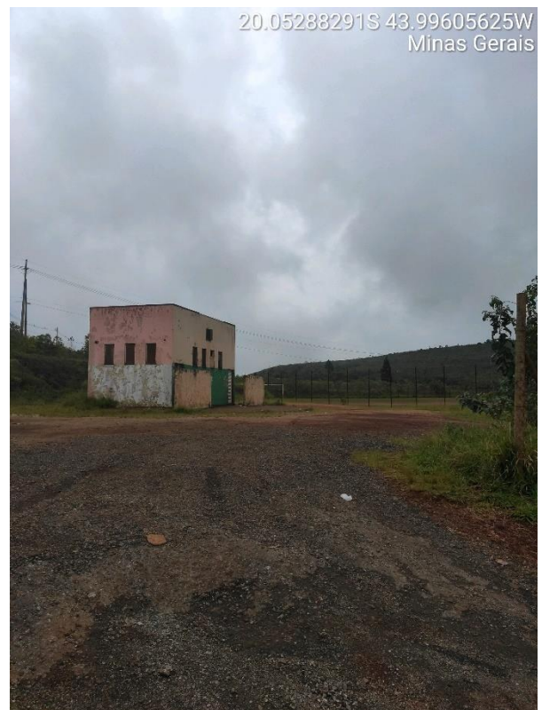
Figura 58 - Rua Florença, próximo à entrada do Parque do Rola Moça. Fonte: Lume, 2021
