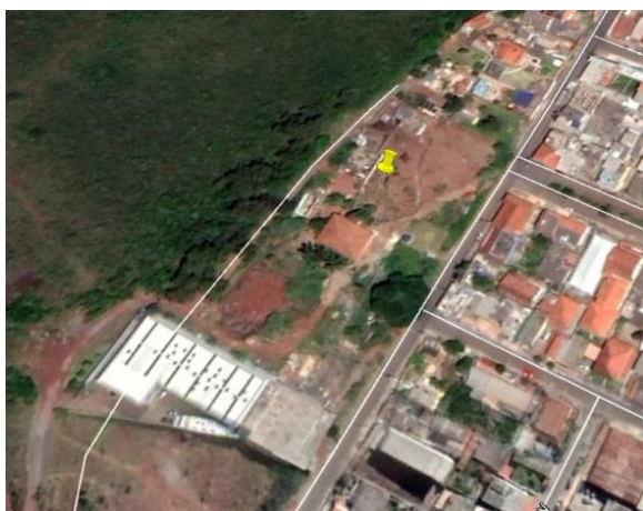
Figura 44 - Ponto de Captação de Água na Rua Quebec. Fonte: Google Earth, 2021
