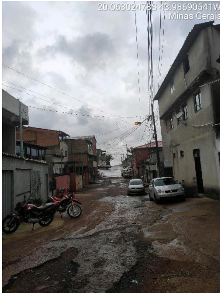
Figura 38 - Residências com baixo Padrão Construtivo, localizadas na porção sudoeste da AEL. Fonte: Lume, 2021
