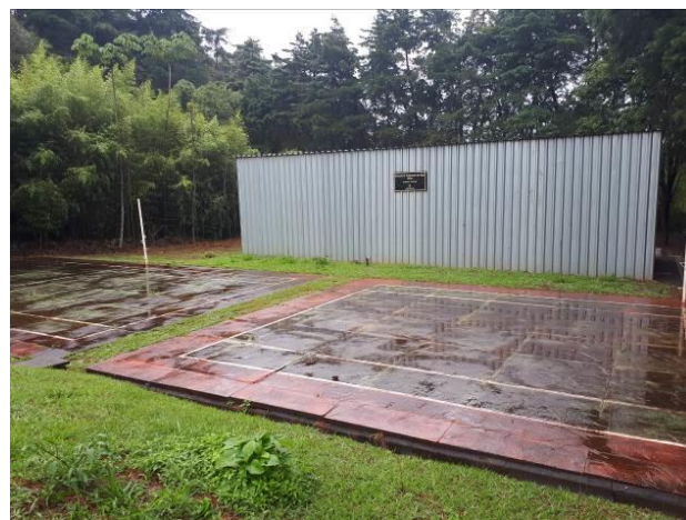
Figura 49 - Estação de Tratamento de Água do condomínio Jardim Monte Verde.
