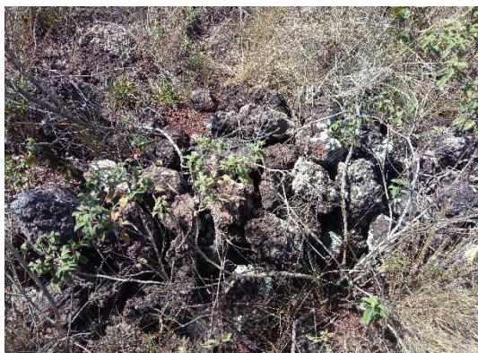
Figura 89 - Espaldão B2 – estrutura de pedras.
