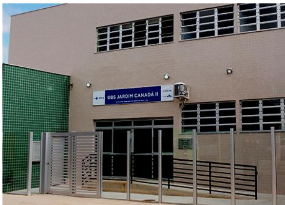
Figura 61 - Unidade Básica de Saúde Jardim Canadá II Fonte: Prefeitura Municipal de Nova Lima
