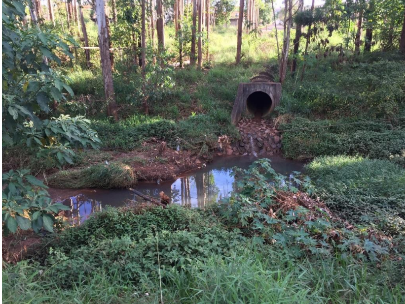
Figura 36 – Ponto de desague de efluentes urbanos na margem direita do Córrego Seco. Coordenadas UTM: 606.189,53 E; 7.782.388,82 N.
