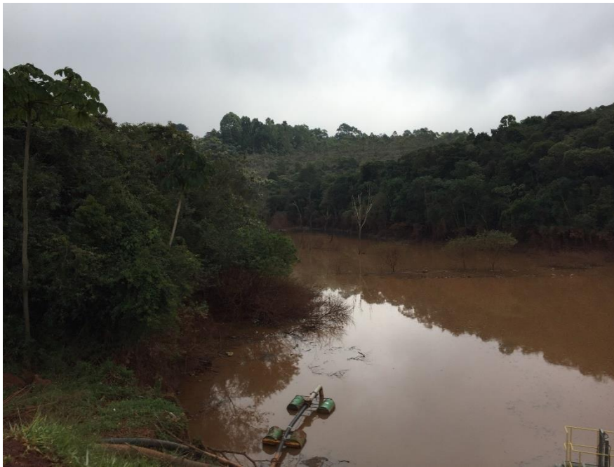
Figura 38 – Córrego Seco represado na barragem 6 da Mina de Mar Azul. Vista para montante. Coordenadas UTM: 608.286,42 E; 7.781.715,04 N.
