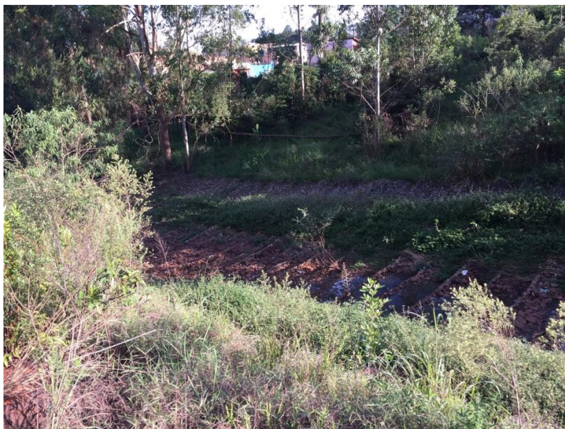
Figura 37 – Trecho do canal com pavimento artificial formado por enrocamento em degraus. Vista para jusante a partir da margem esquerda. Coordenadas UTM: 606.492,66 E; 7.782.219,35 N.
