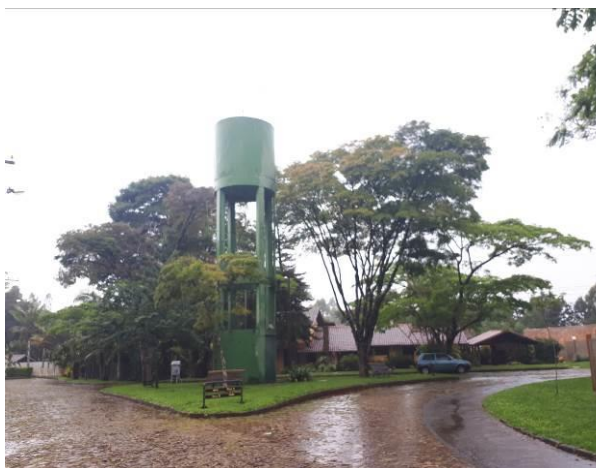
Figura 48 - Reservatório de Água do Condomínio Jardim Monte Verde.
