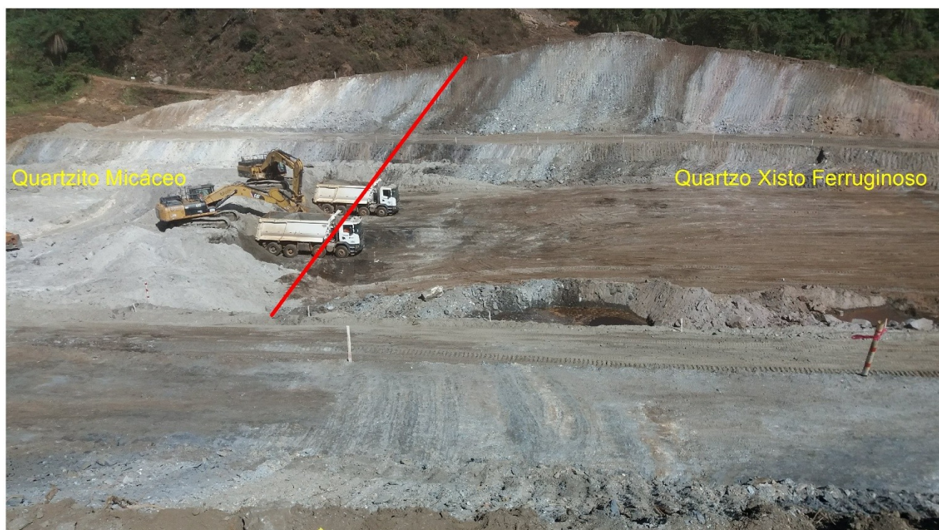
Figura 6 - Vista do corte no canal de desvio da galeria da ECJ-CCR, visada para oeste, coincidente com a locação da seção D-D'.
