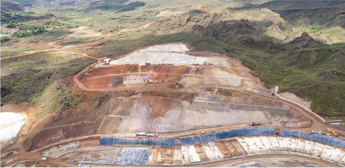
*Figura 4 - Barragem Doutor: Escavação e concreto projetado do Talude 03 (25/10/2022)*
