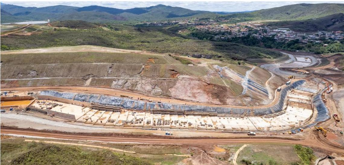
*Figura 3 - Barragem Doutor: Construção trecho em concreto canal extravasor (25/10/2022)*
