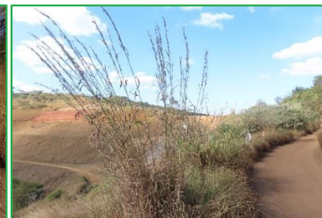
Visão geral dos acessos não pavimentados e outras estruturas minerárias
