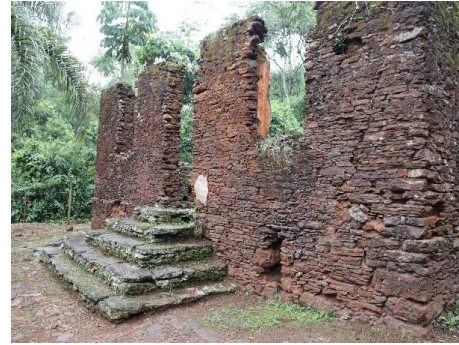
Figura 6-230 - Edificações da Vila de Gongo Soco em ruínas.
