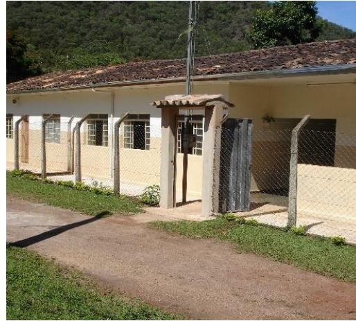
Figura 6-268 - Fachada da Escola Municipal Raimundo Linhares em André do Mato Dentro.
