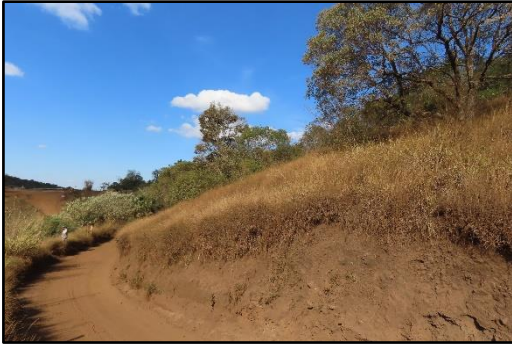
Figura 6-139 - Visão geral dos acessos não pavimentados e outras estruturas minerárias
