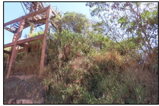
Figura 6-142 - Visão geral dos acessos não pavimentados e outras estruturas minerárias
