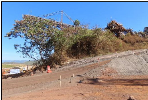
Figura 6-141 - Visão geral dos acessos não pavimentados e outras estruturas minerárias
