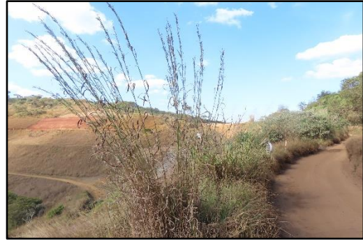
Figura 6-140 - Visão geral dos acessos não pavimentados e outras estruturas minerárias
