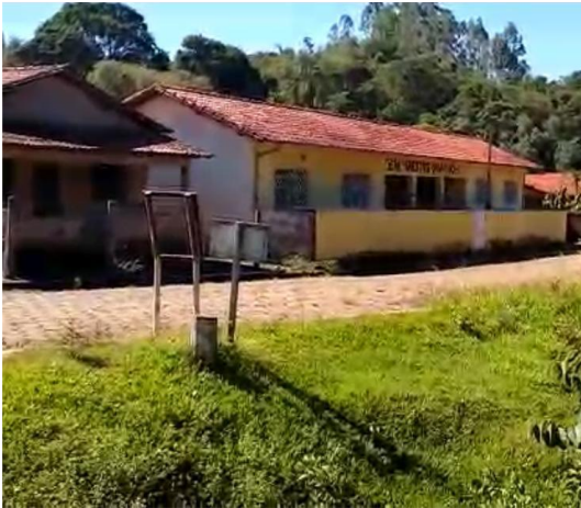
Figura 6-267 - Escola Municipal Mestre Quintão, na comunidade de Socorro.
