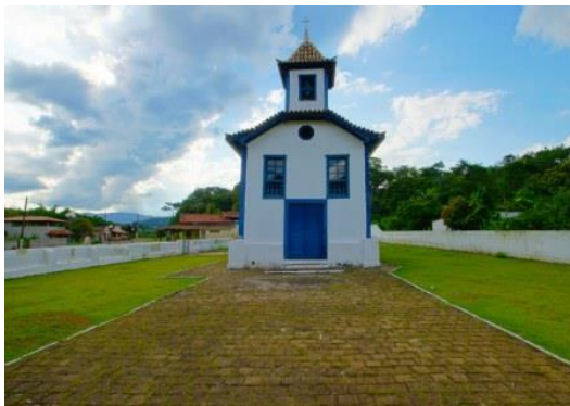
Figura 6-231 - Vista externa da Igreja N. Sra. Mãe Augusta do Socorro.
