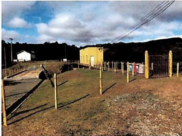
(a) Visão geral da estrutura de vertimento.
