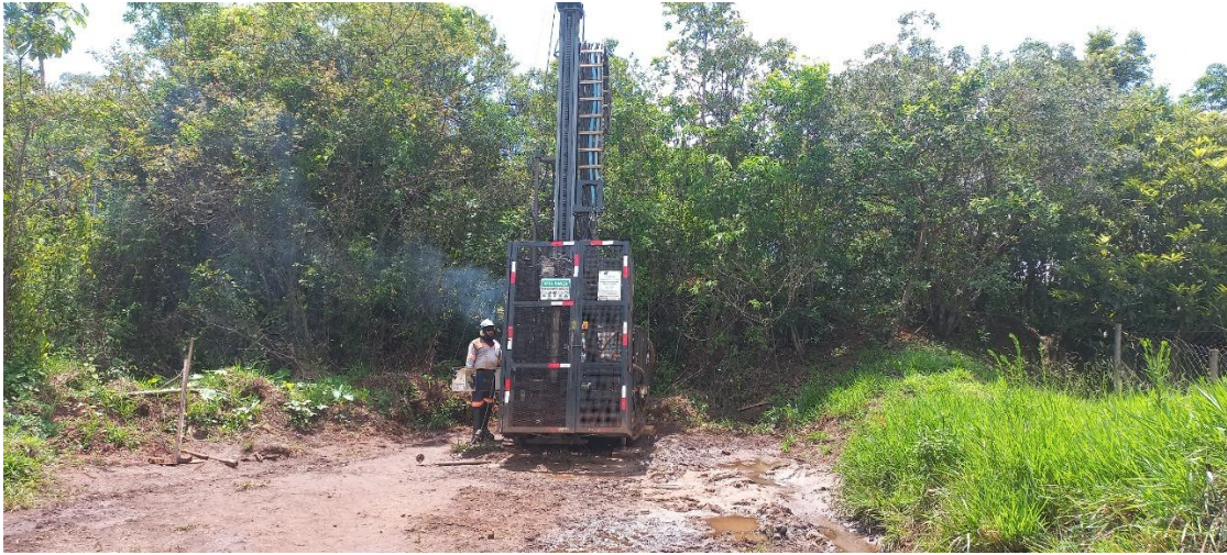
Figura 4-7 – Execução da atividade de sondagem. Fonte: Vale S.A.
