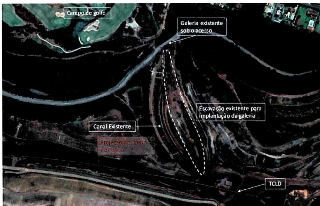
Figura 3.13 – Detalhe da região da galeria e dreno de fundo da PDE Barreira Acústica antes da implantação da obra (Fonte: Doc. [13]).
