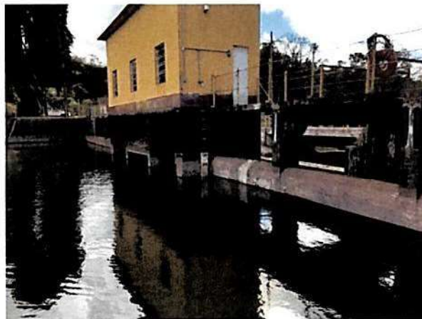
(c) Vertedouro livre e sifão, ao centro.
