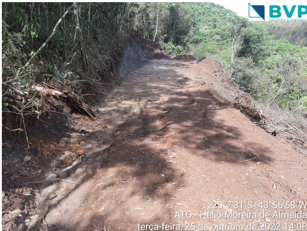
Figura 4-4 - Acesso para realização das sondagens - jusante para montante
