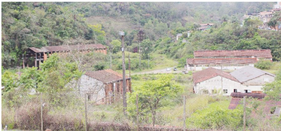
Figura 6-94 - Vista do Conjunto Histórico e Industrial de Morro Velho. Fonte: NOVA LIMA, 2022.
