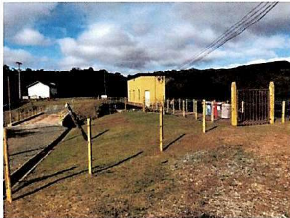
(a) Visão geral da estrutura de vertimento.
