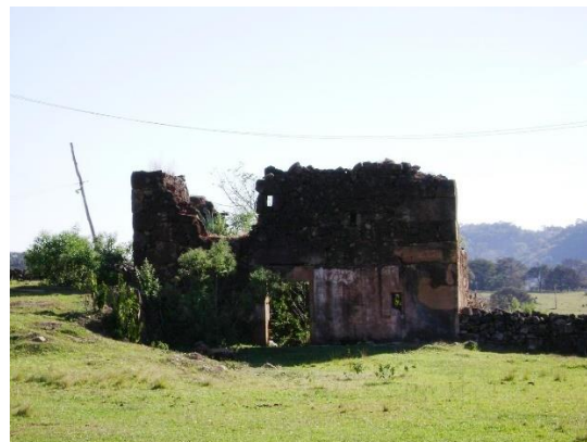
Figura 6-101 - Estrutura de edificação histórica.
