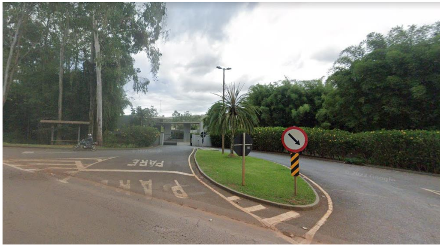
Figura 6-114 - Vista para portaria do Condomínio Capitão do Mato pela BR-356
