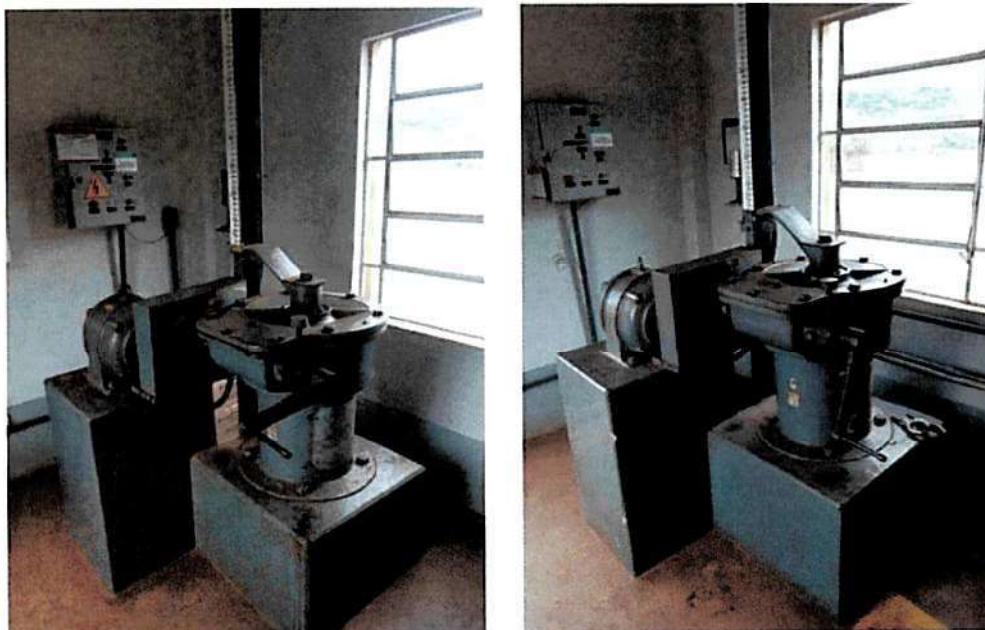
Figura 1 - Comporta 5 e 6 - Imagem de acionamento eletromecânico e manípulo de acionamento manual
