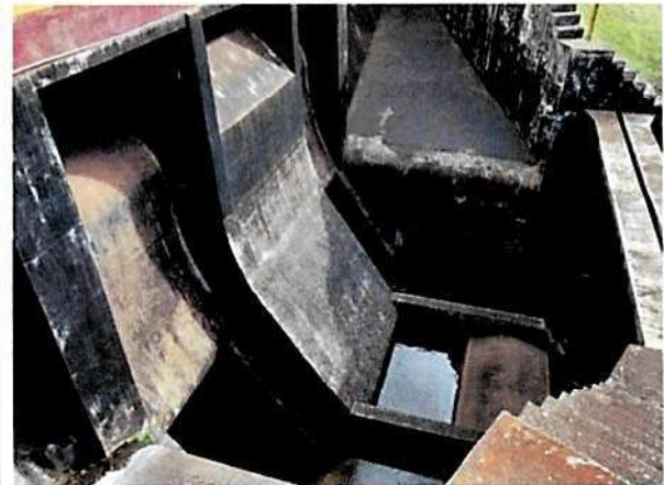
(f) Saída das adufas, do sifão e do vertedouro livre, ao fundo.
