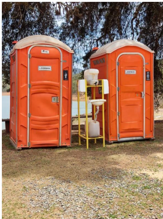
Figura 4-11 - Banheiros químicos disponibilizados na frente de serviços. Fonte: Vale
