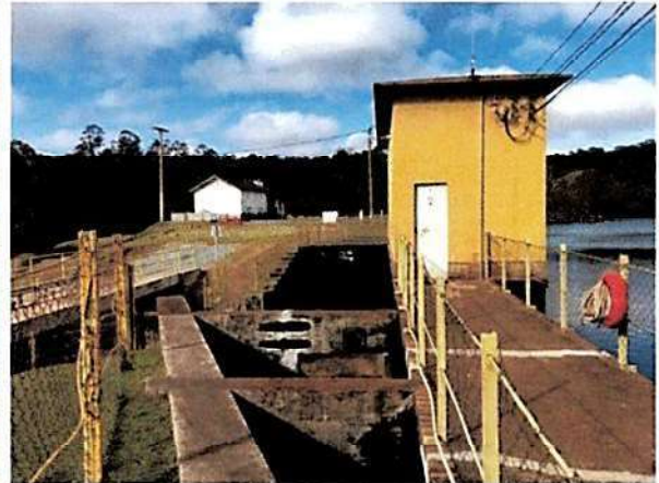
(b) Estrutura de vertimento e laje do passadiço da barragem.
