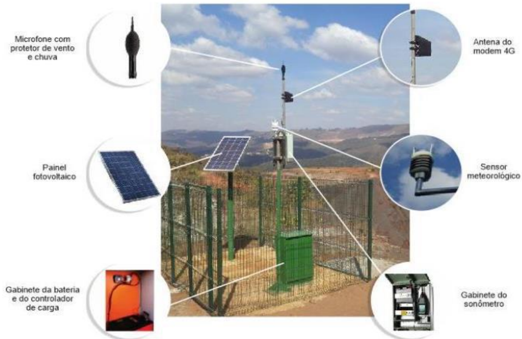
Figura 6-11 Estação de monitoramento sonoro e seus principais componentes.
