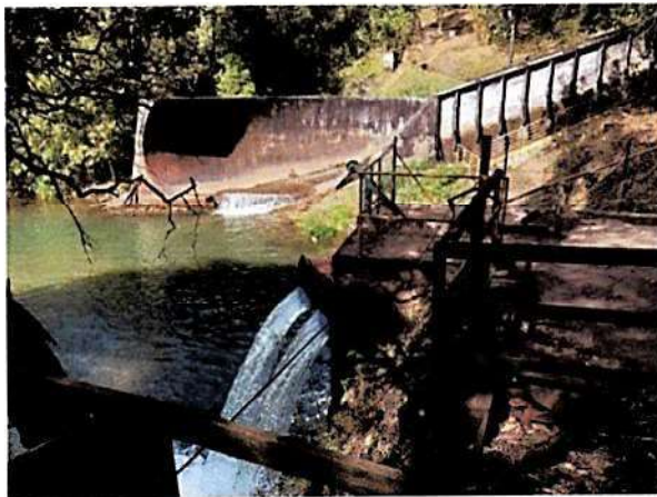
(i) Saída da tubulação de fundo das tulipas e final do rápido.
