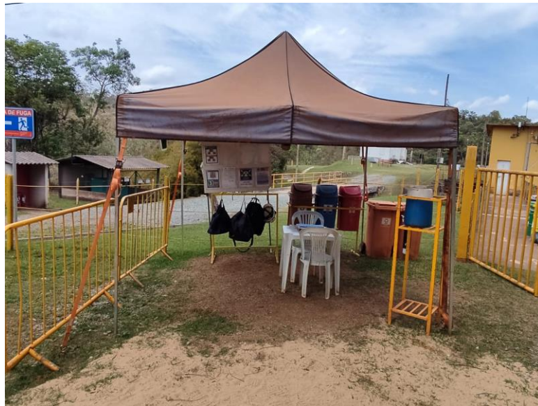
Figura 4-10 – Frente de apoio para execução da supressão vegetal e sondagens. Fonte: Vale
