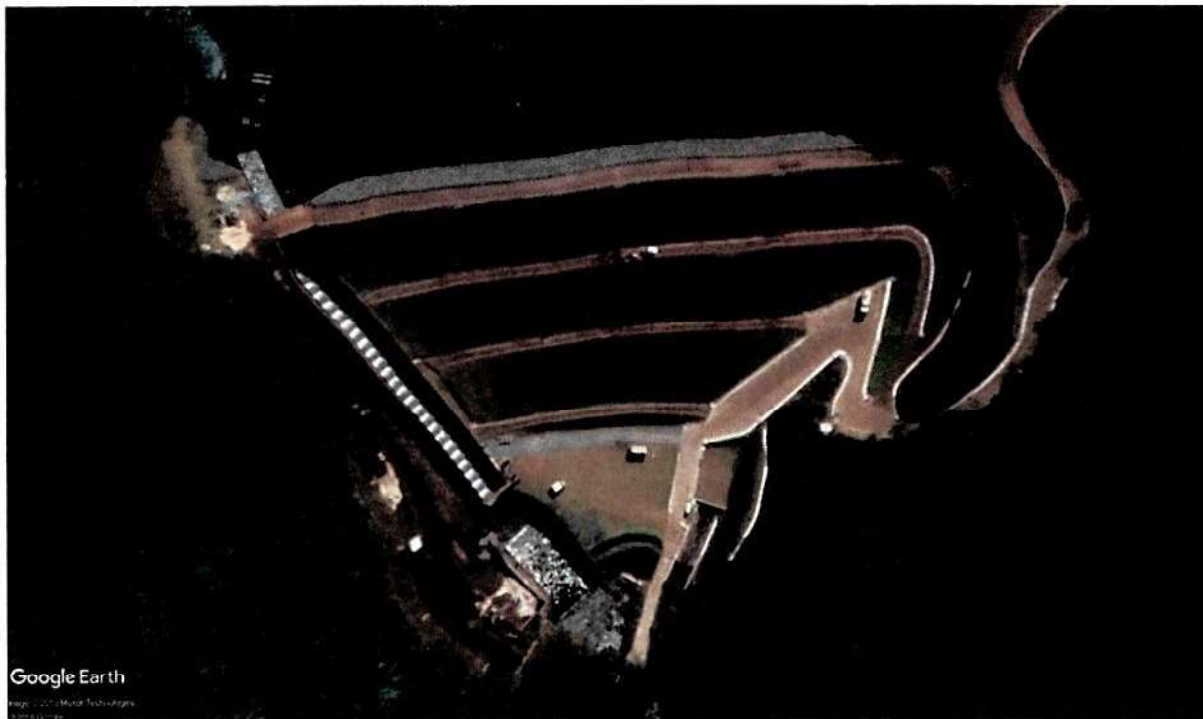
Figura 3.21 – Visão geral do sistema extravasor da Barragem Capitão do Mato.
