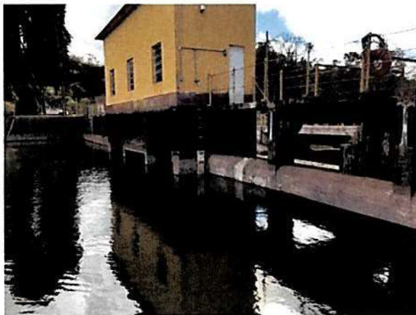
(c) Vertedouro livre e sifão, ao centro.
