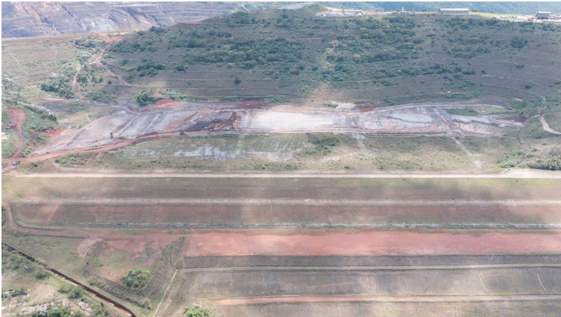
Figura 2 - Barragem Sul Superior: Visão Geral em 27/10/2022
