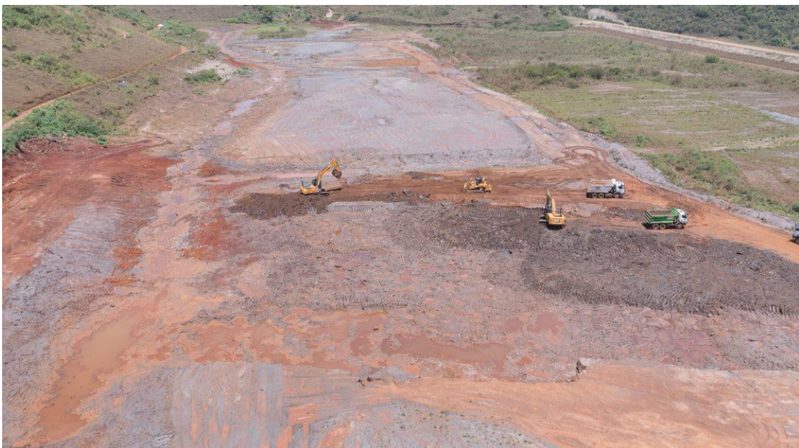
Figura 3 - Barragem Sul Superior: Escavação do Platô 4 entre os canais 3 e 4 em 27/10/2022
