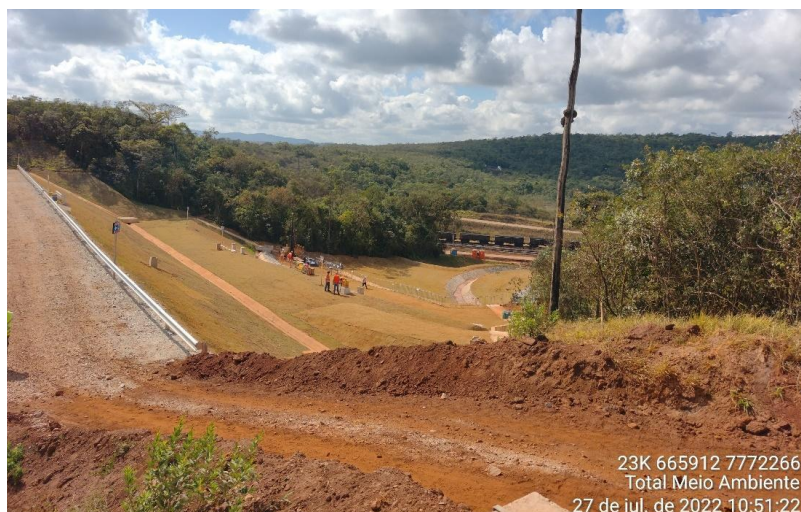
Vista geral da AEL. Na imagem observa-se o topo do barramento de Diclão Leste, a Área de Estudo Local do Projeto, representada pela vegetação, à esquerda, e à distância um caminhão trafegando pela rodovia MG-129, situada à, aproximadamente, 500 m de distância.
