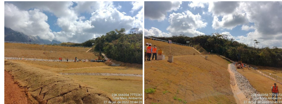
Vista frontal da estrutura de barramento Dicão.
