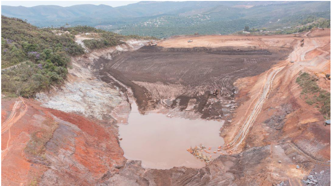
Figura 2 - Barragem B3/B4: Visão Geral (17/10/22)
