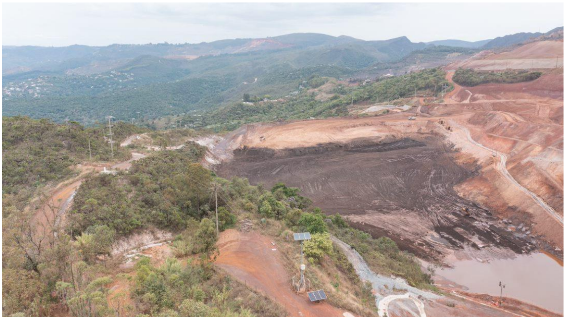
Figura 3 - Barragem B3/B4: Escavação etapa 6 (17/10/22)
