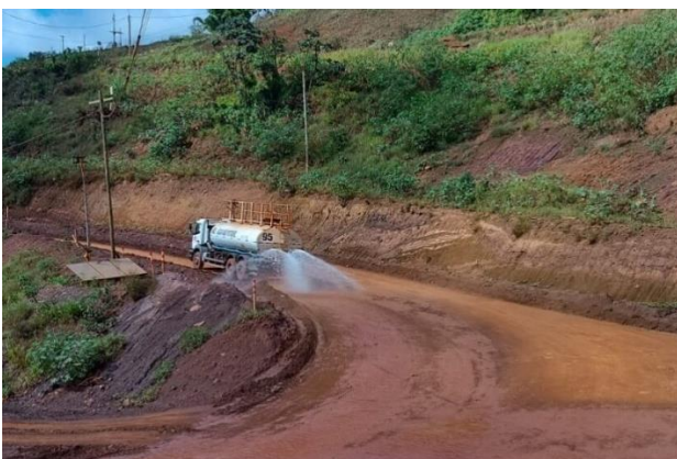
Foto 13. Umectação nos acessos. (Fonte: Vale, janeiro de 2024).
