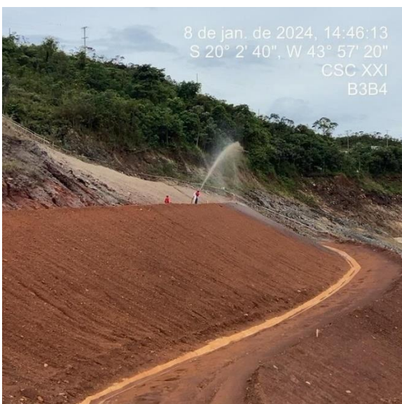
Foto 4. Aplicação de MVP no reforço da ombreira esquerda (Fonte: Vale, 08 de janeiro de 2024).
