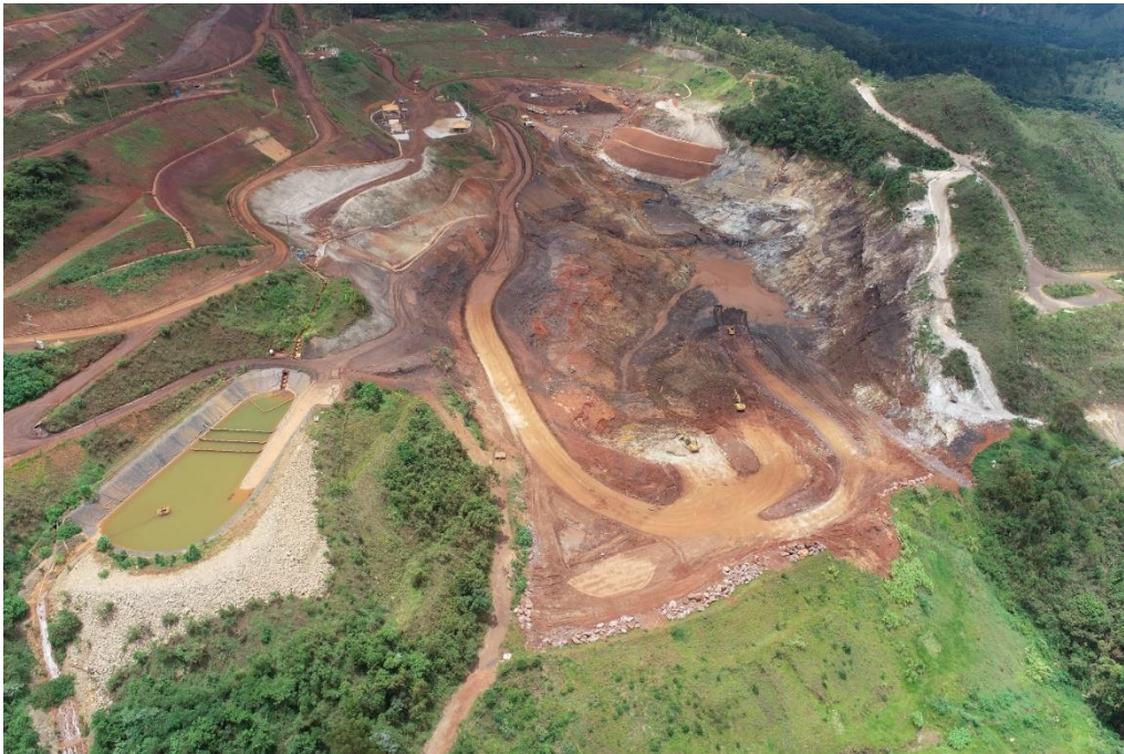
Foto 1. Execução da etapa 11 da descaracterização. (Fonte: Vale, jan 2024).
