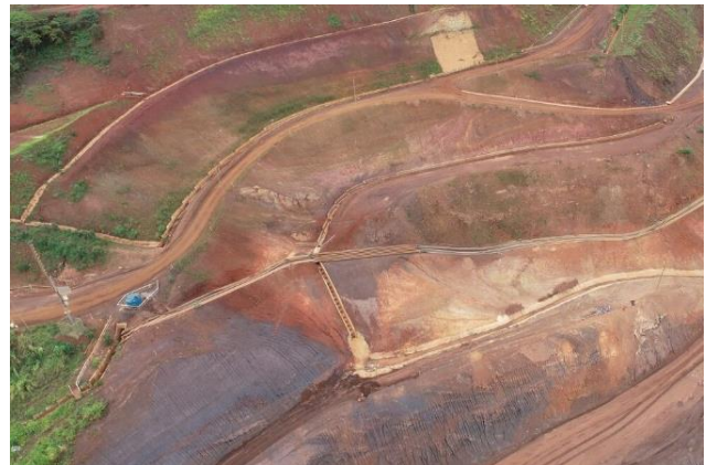
Foto 3. Canal de cintura e drenagens - Obras de descaracterização da barragem B3/B4. (Fonte: Vale, dezembro de 2023).
