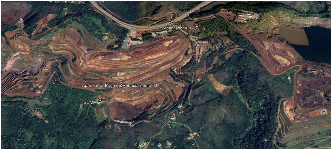
Figura 49. Localização do novo apanhador de água implantado em novembro de 2023 no Poço de Rebaixamento 03 e Apanhador APIA já existente. (Fonte: Vale, 2024)
