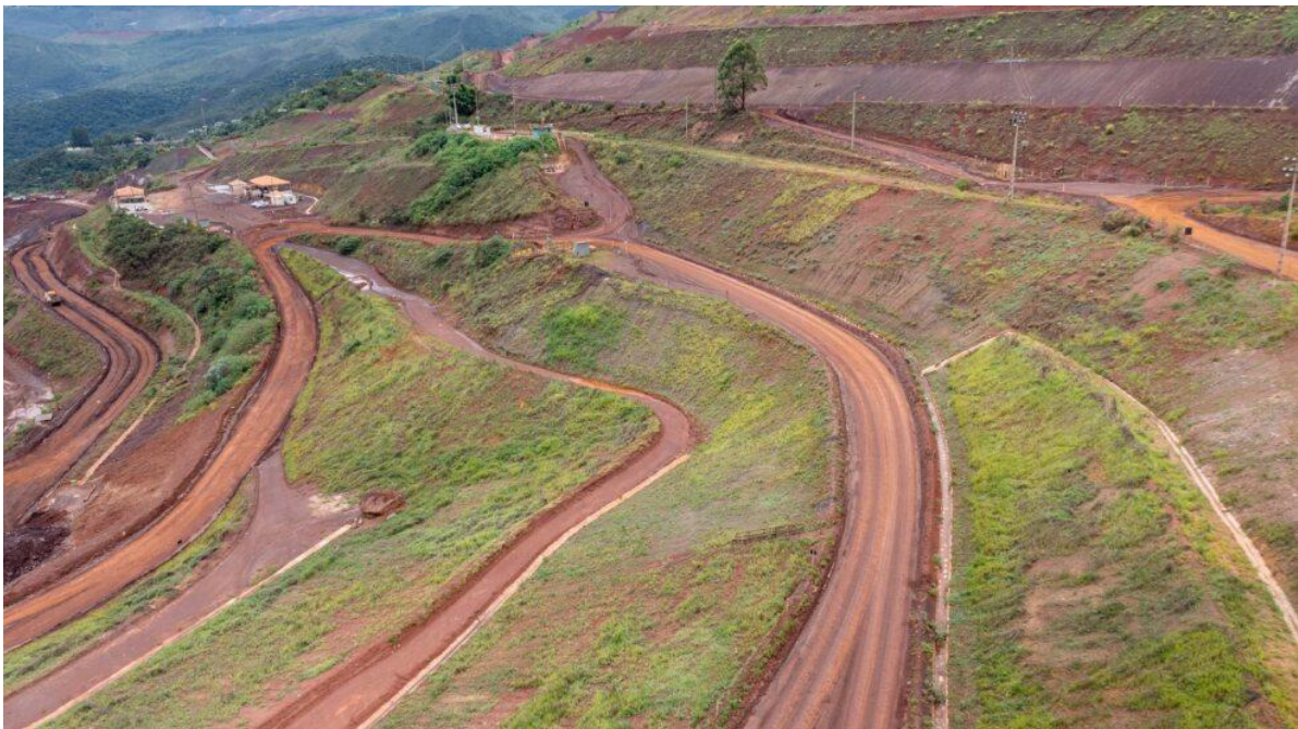
Foto 7. Aplicação de MVP bem estabelecido e em processo de germinação. (Fonte: Vale, 29 de janeiro de 2024)
