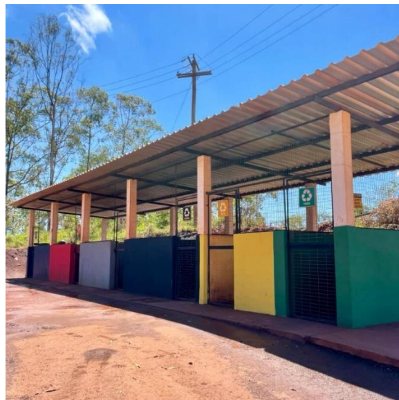
Foto 21. DIR do Canteiro. (Fonte: Vale, 2023).
