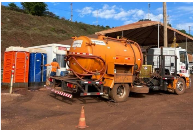
Foto 17. Higienização de banheiros hidráulicos. (Fonte: Vale, 2023).
