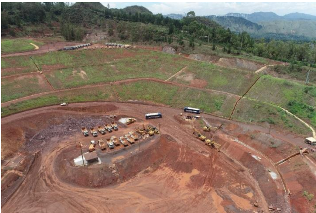
Foto 2. Canaletas e drenagens - Obras de descaracterização da barragem B3/B4. (Fonte: Vale, janeiro de 2024).
