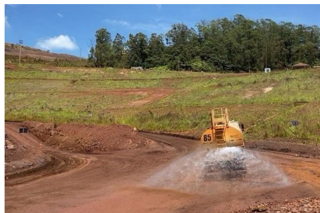
Foto 14. Umectação nos acessos. (Fonte: Vale, dezembro de 2023).
