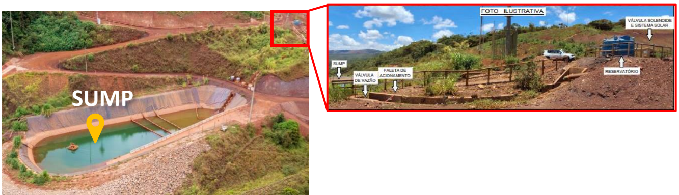
Figura 30. Sistema automatizado de aplicação de floculante. (Fonte: Vale, dezembro de 2023)
