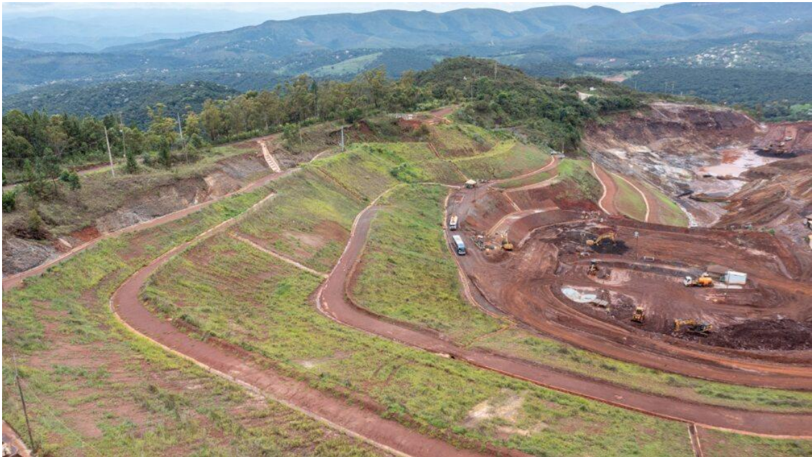
Foto 6. Aplicação de MVP bem estabelecido e em processo de germinação. (Fonte: Vale, 29 de janeiro de 2024)
