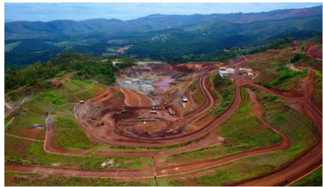
Foto 11. Vista da PDE-X após processo de revegetação bem estabelecido das ombreiras da barragem. (Fonte: Vale, janeiro de 2024)
