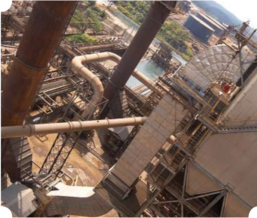
Peralatan pengendali polusi yang canggih pada Tungku Listrik No.2 baru dipasang oleh PT Inco.
